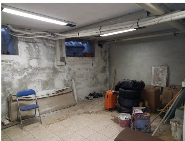
Vista interna del Magazzino – Cantina al piano interrato
