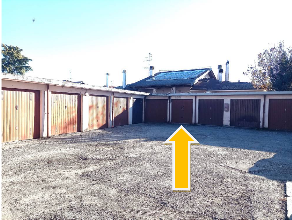
Vista esterna dell'autorimessa da cortile condominiale
