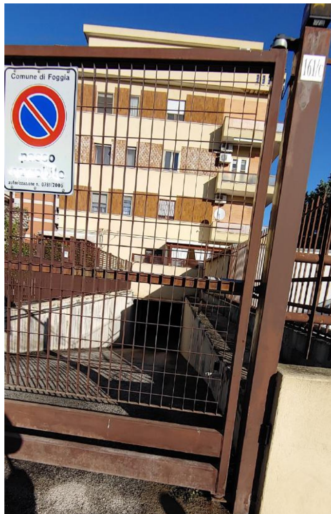
FOTO C2 - PALAZZINA DI VIA LEONE XIII N. 161 - FOGGIA/ RAMPA DI ACCESSO AI BOX (CIV. 161/C)
