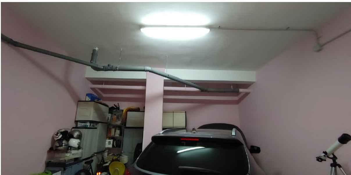
Foto C7 - BOX AUTO AL I PIANO INTERRATO - INTERNO
