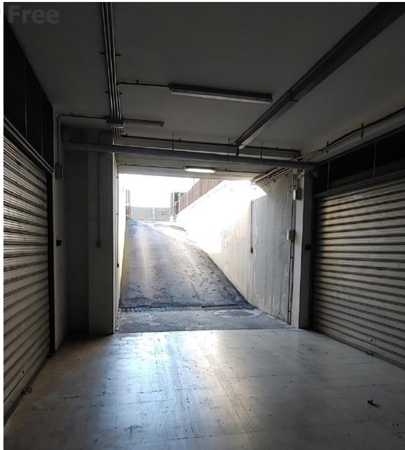
Foto C3 - BOX AUTO AL I PIANO INTERRATO - RAMPA DI ACCESSO AI BOX/CORSIA DI MANOVRA
