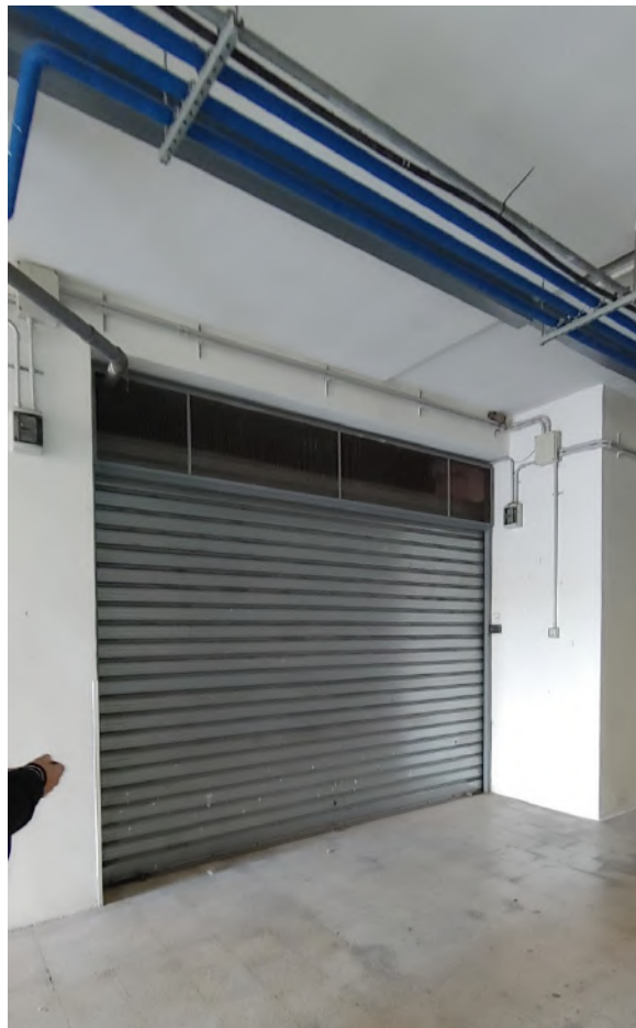
Foto C4 - BOX AUTO AL I PIANO INTERRATO - SERRANDA D'INGRESSO
