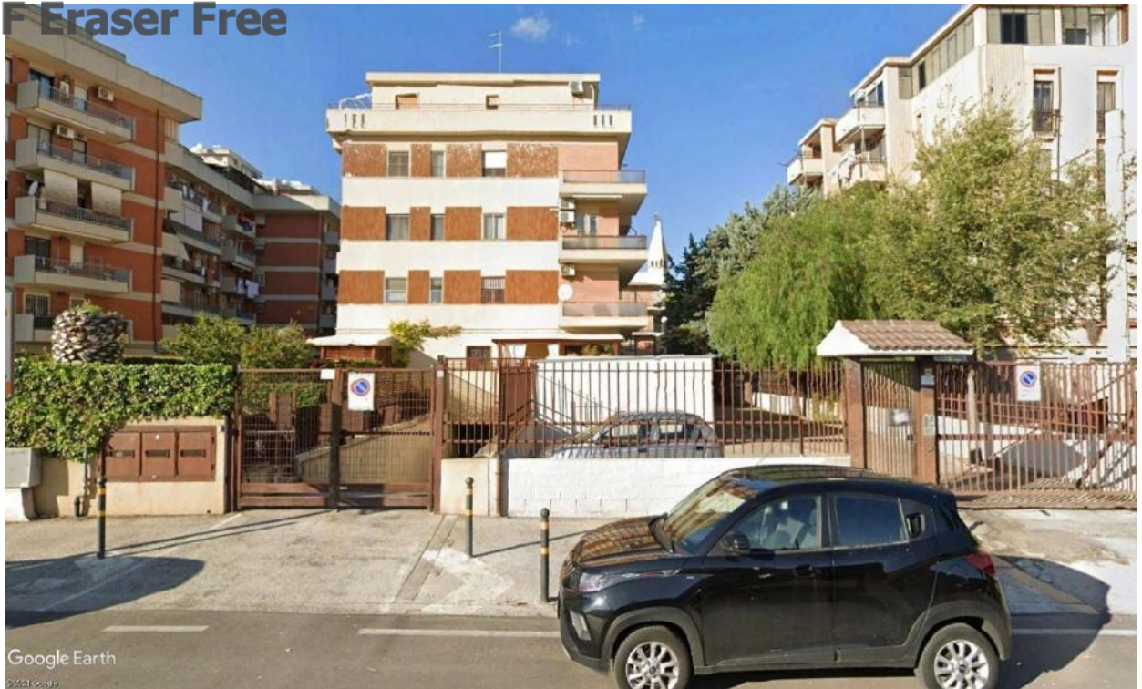
Figura 3 – Stabile di Via Leone XIII n. 161/C – Foggia
