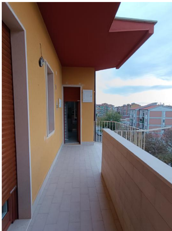
Foto C8 - LOTTO 1 - ABITAZIONE AL TERZO PIANO - BALCONE AD OVEST
