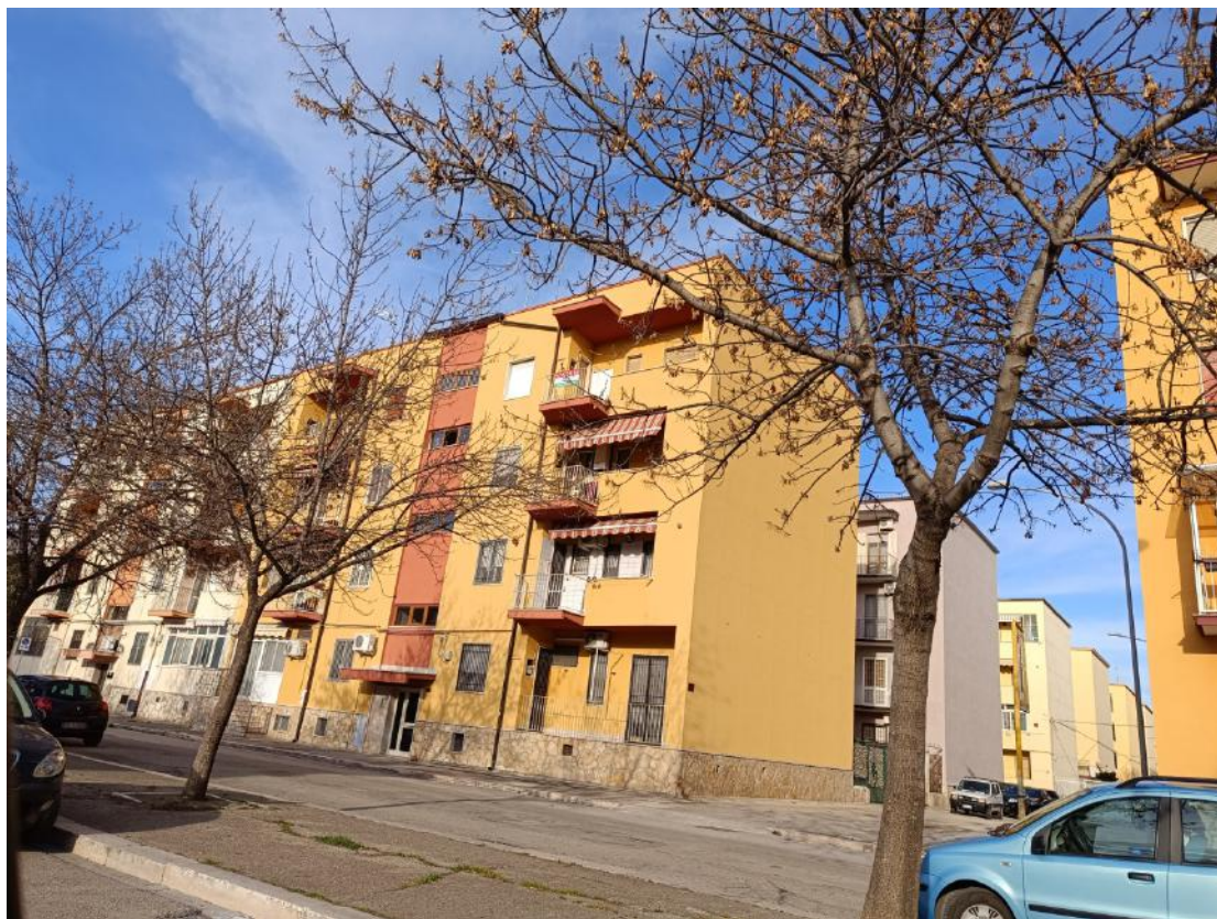
Foto C1 - LOTTO 1 - FABBRICATO VIA LUIGI OBERTJ N. 6 FOGGIA
