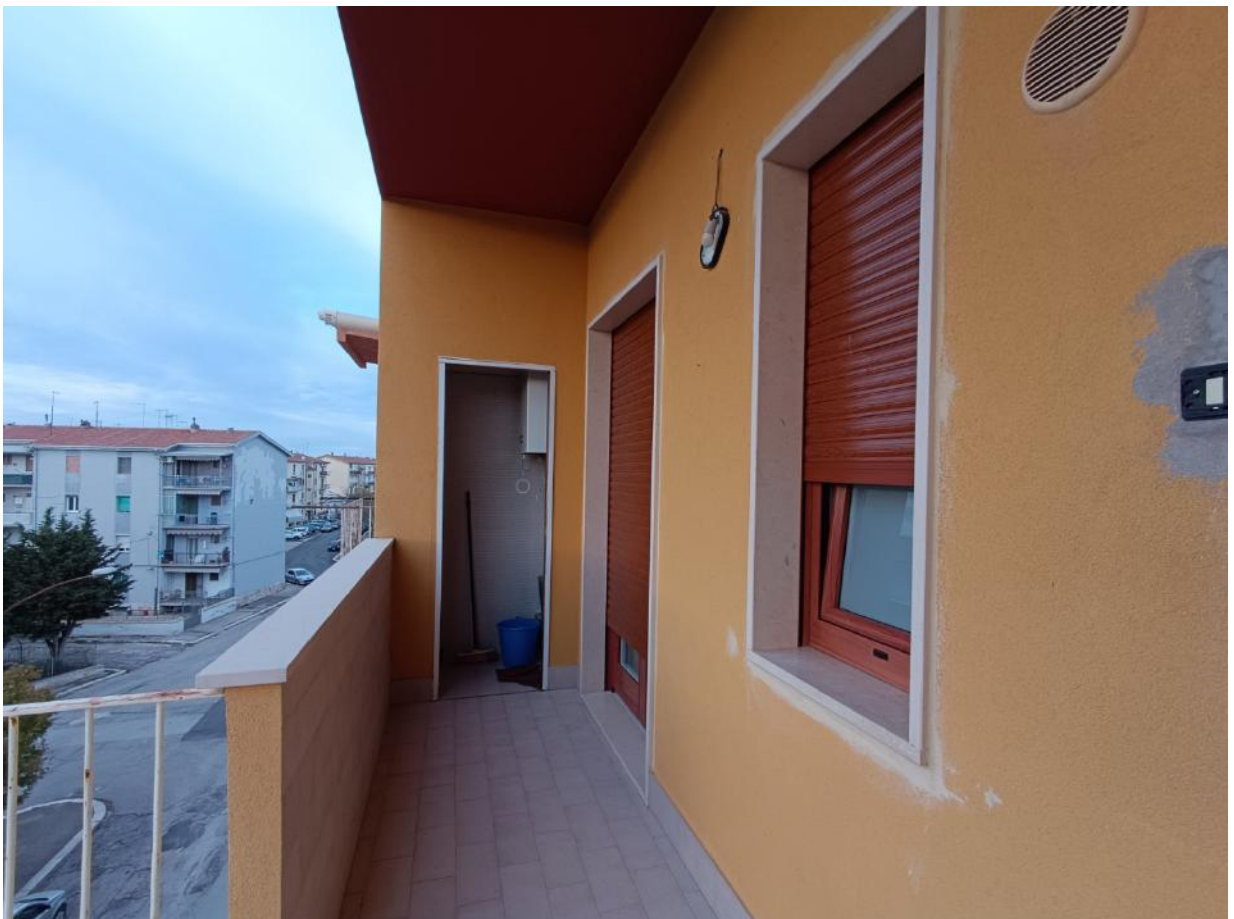
Foto C6 - LOTTO 1 - ABITAZIONE AL TERZO PIANO - BALCONE AD OVEST
