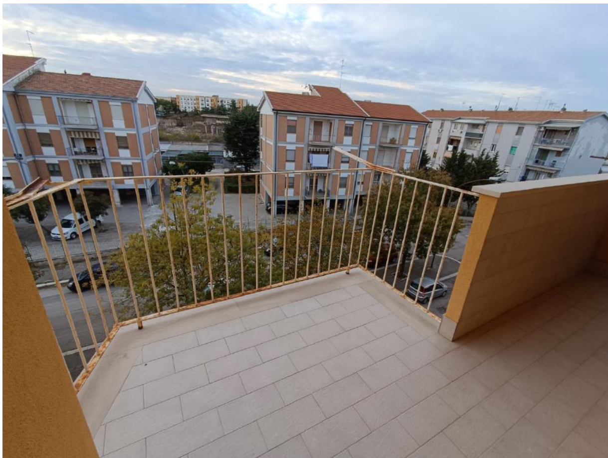
Foto C7 - LOTTO 1 - ABITAZIONE AL TERZO PIANO - BALCONE AD OVEST
