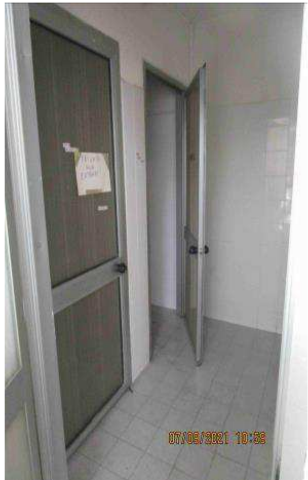
Servizi igienici - corpo su via Goia
