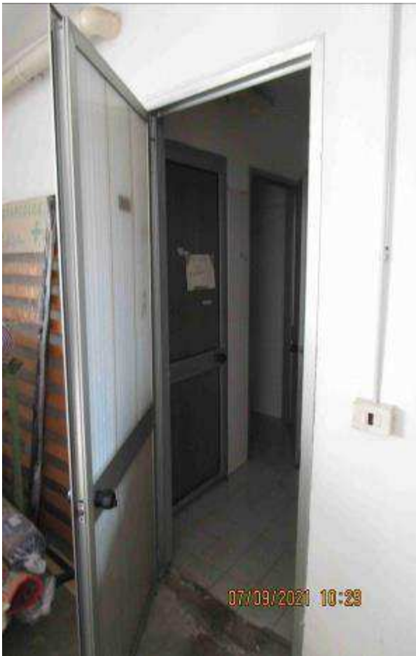
Servizi igienici - corpo su via Goia
