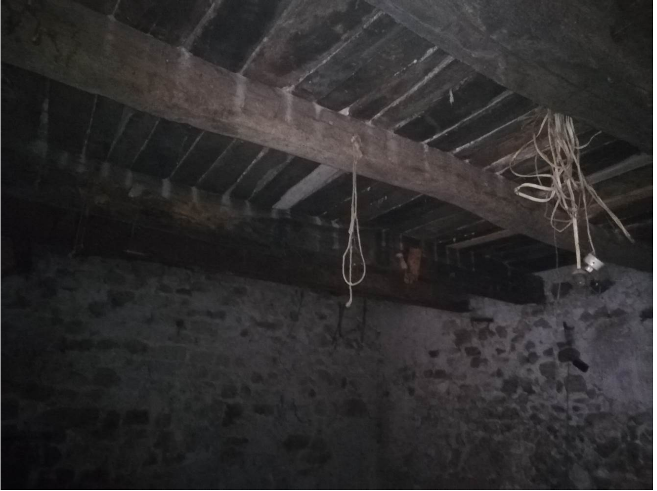
Foto 6 – interno angolo sinistro
