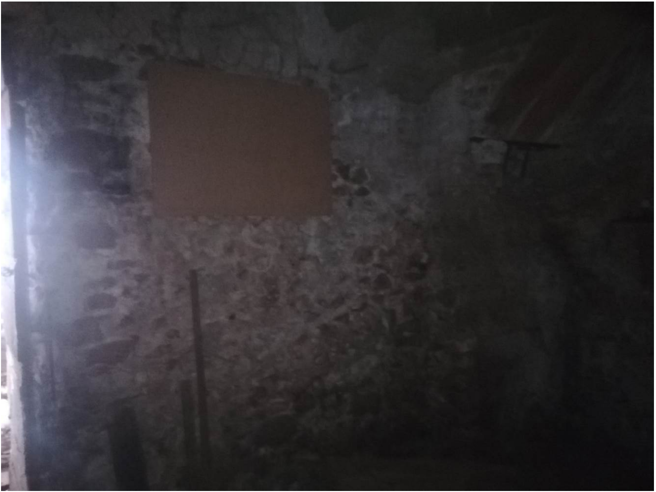
Foto 7 – interno – vano finestra
