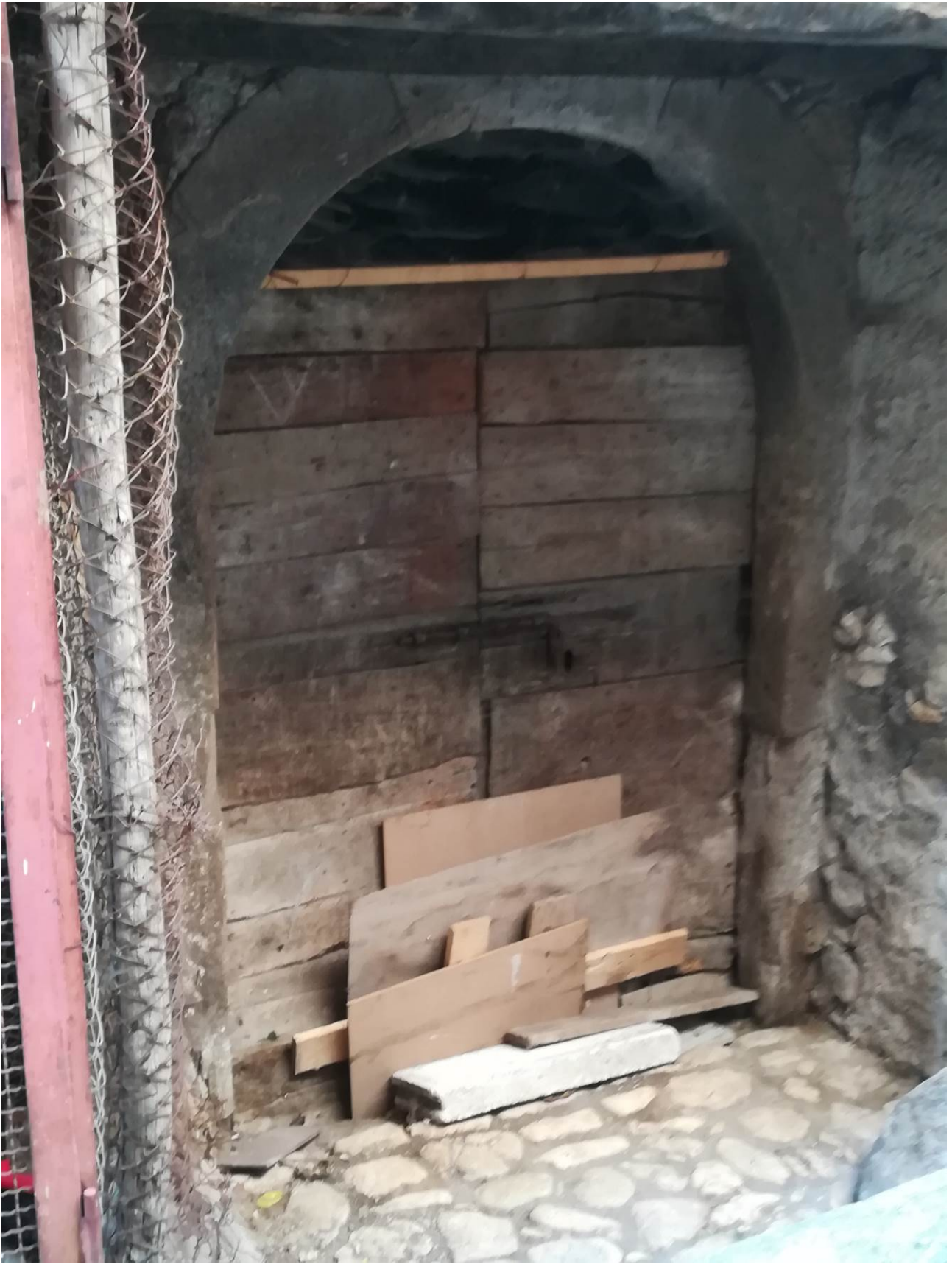
Foto 2 – porta di ingresso
