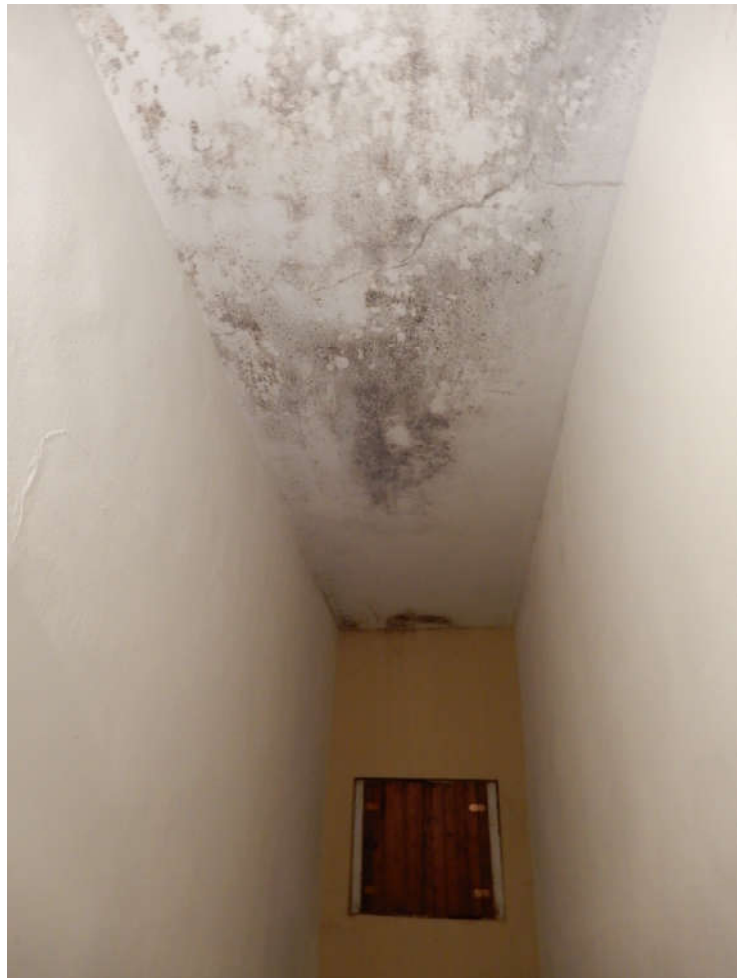
Soffitto scala di collegamento
