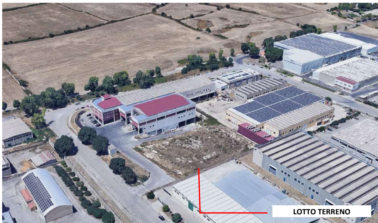
Figura n°32 : Immagine con l'ubicazione del lotto di terreno.
