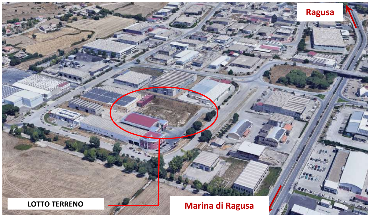
Figura n°31: Immagine con l'ubicazione del lotto di terreno.
