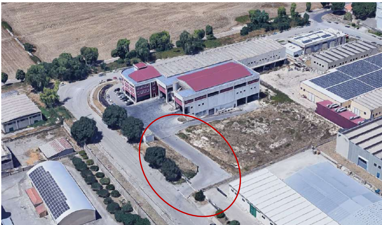
Figura n°38: Accesso carrabile dalla Particella n°1169 per raggiungere il capannone industriale.
