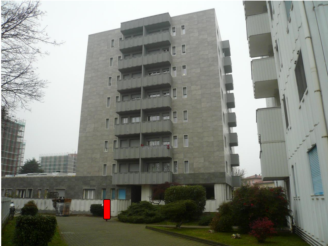
Figura 1 - Vista del fabbricato in cui sono ubicati i beni oggetto di stima
