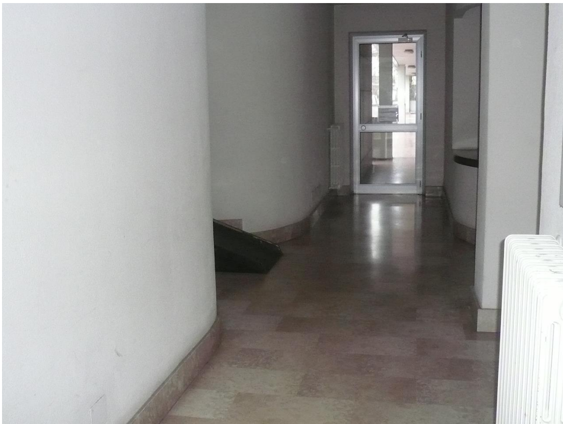
Figura 4 - Particolare parti comuni del fabbricato
