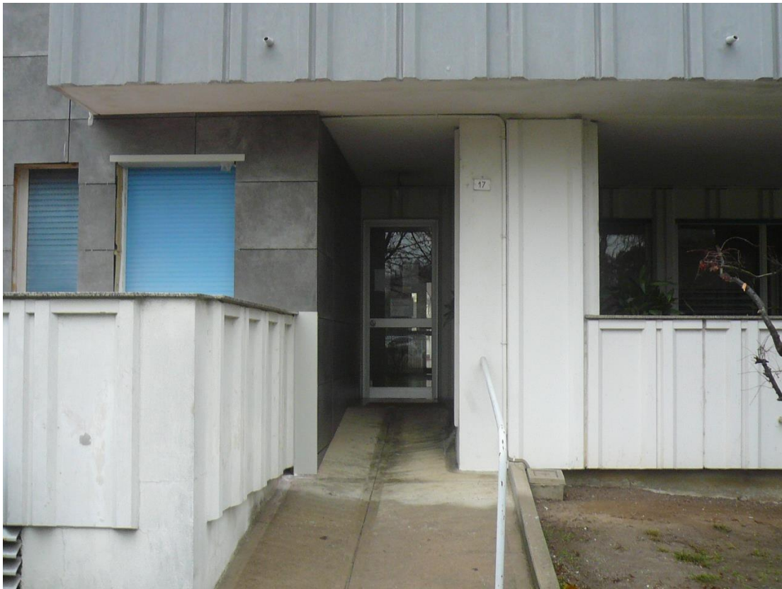
Figura 3 - Particolare ingresso al fabbricato
