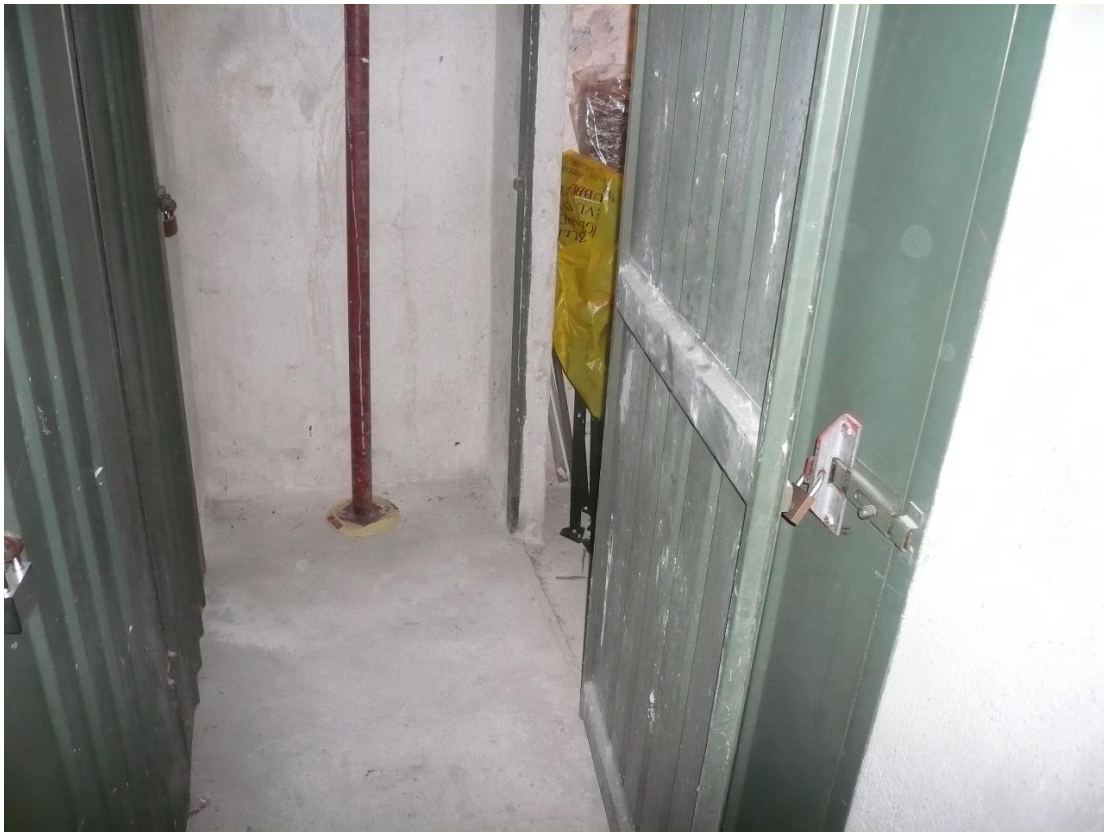
Figura 13 - Particolare locale cantina
