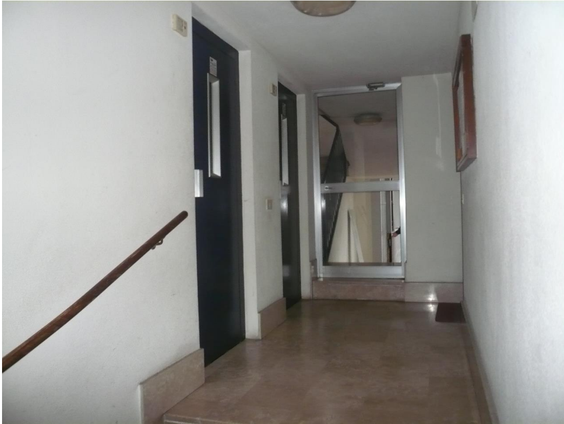
Figura 5 - Particolare parti comuni del fabbricato
