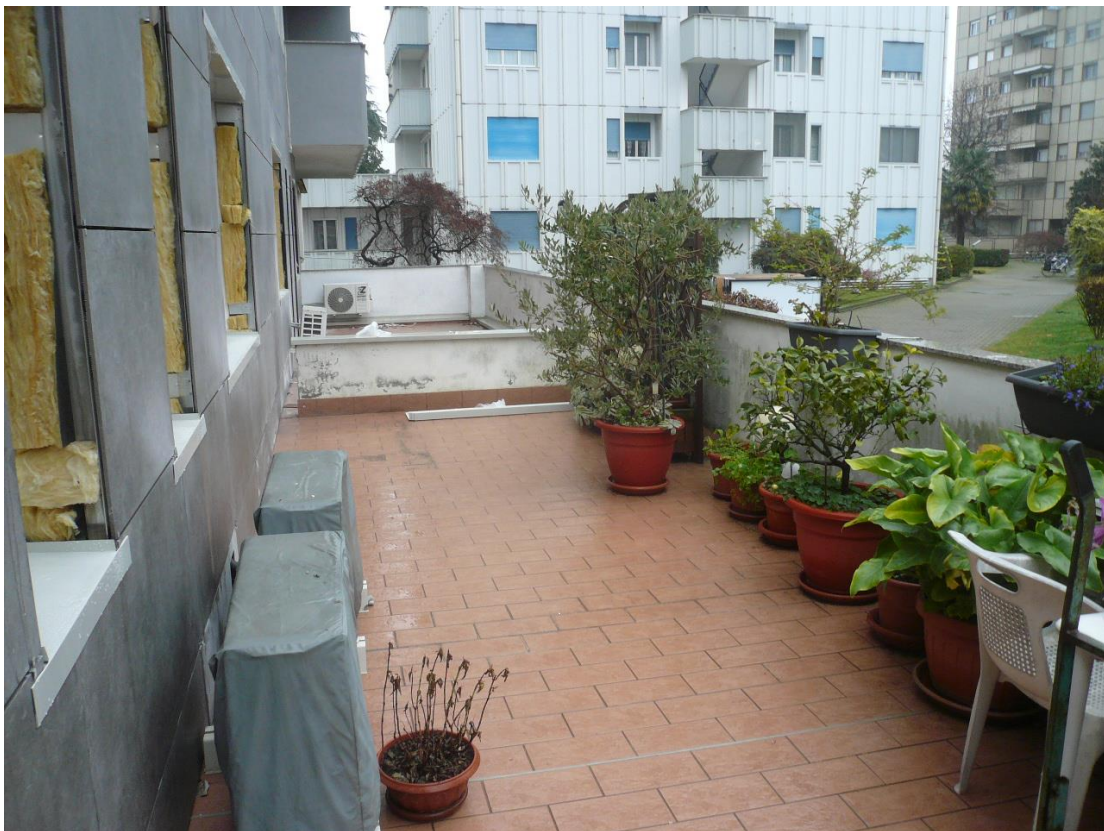
Figura 12 - Particolare terrazza a servizio dell'alloggio
