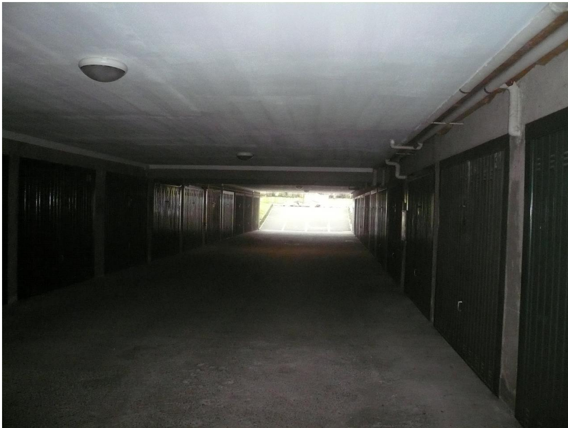
Figura 15 - Particolare corsello box
