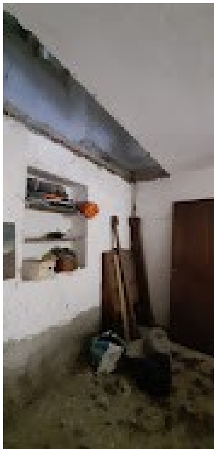
la demolizione del solaio per il collegamento dei due alloggi
