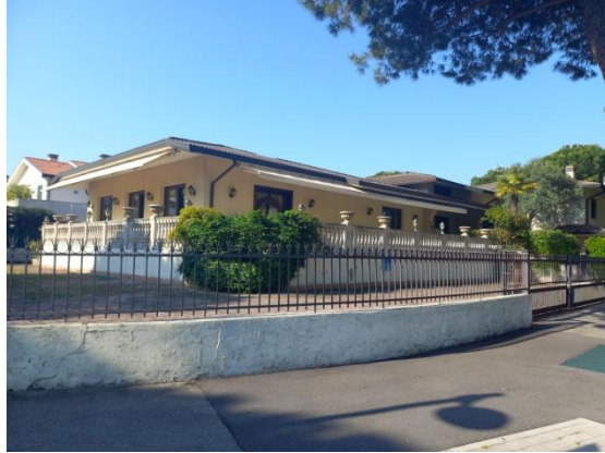
FOTO 2 PROSPETTO EST E NORD
