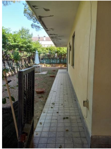
FOTO 8 ESTERNO LATO OVEST
