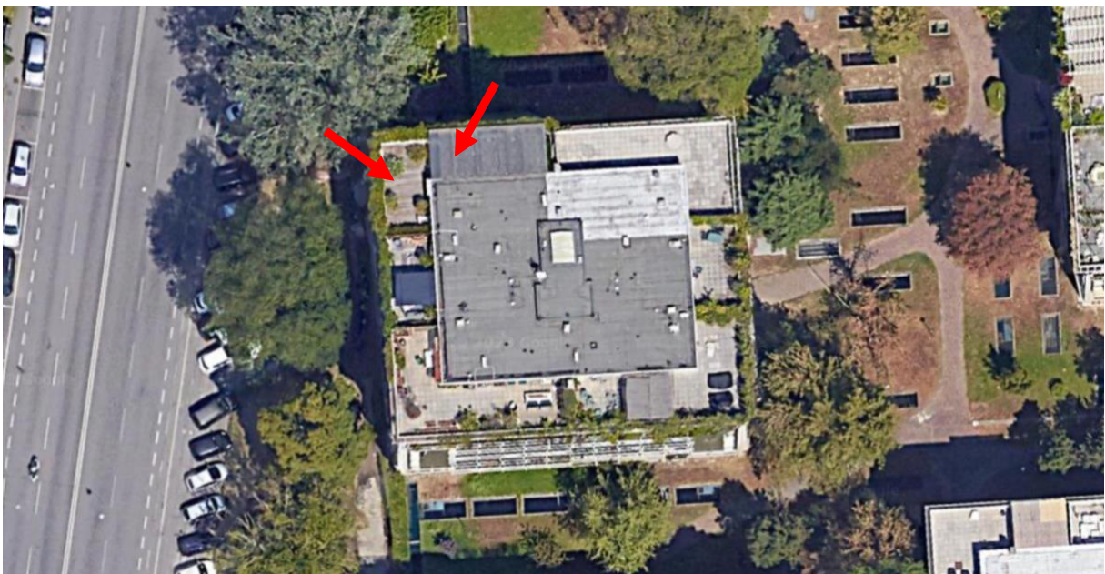
2. Estratto da Google Maps. Il fabbricato che ospita gli immobili pignorati. Le frecce indicano la terrazza parte dell'appartamento pignorato.
