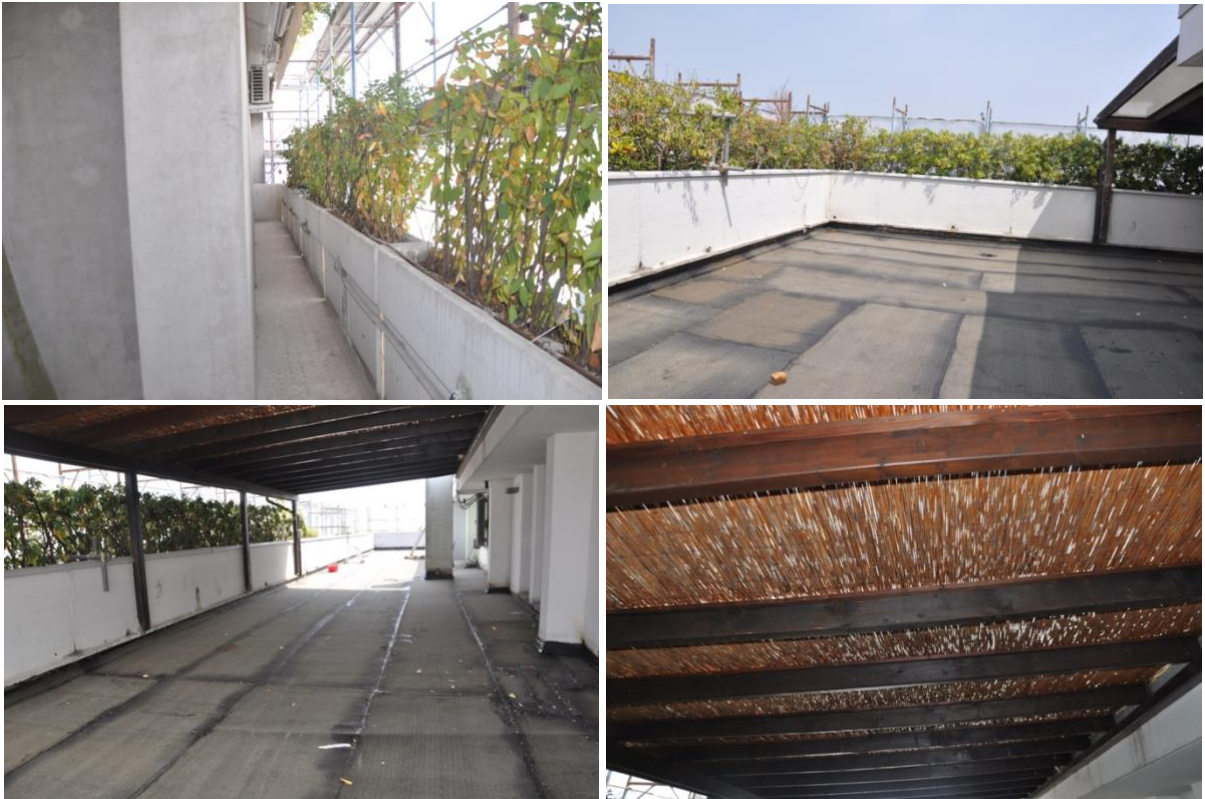
7. Terrazza al piano quinto con accesso dal soggiorno e dal bagno; terrazza al piano sesto - i lavori condominiali di isolamento dell'edificio hanno tolto i divisori fra le terrazze confinanti del sesto piano. La pompeiana non è
