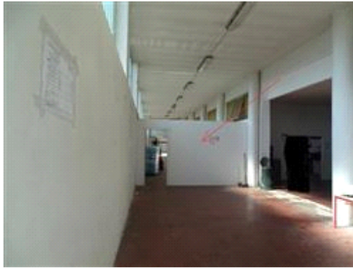
parete da demolire
