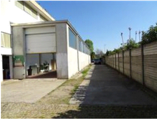
Vista laterale immobile dal cortile interno
