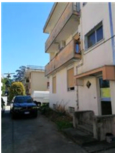
Vista ingresso Uffici cortile interno
