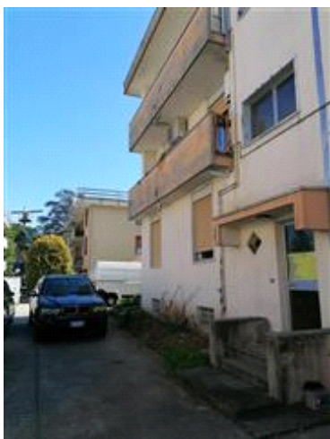
Vista ingresso Uffici cortile interno
