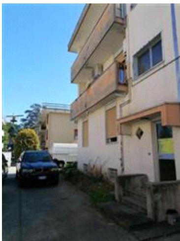
Vista ingresso Uffici cortile interno
