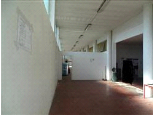
Ingresso laboratorio piano terra
