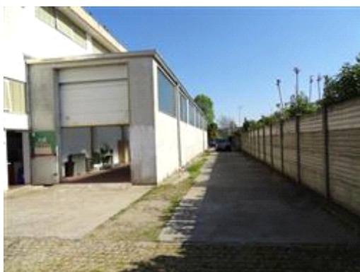
Vista laterale immobile dal cortile interno
