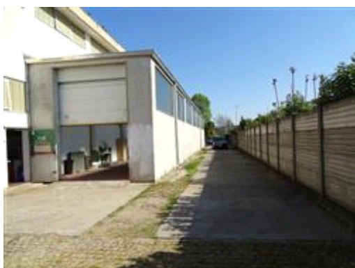
Vista laterale immobile dal cortile interno
