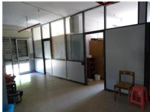
Vista uffici Piano terra
