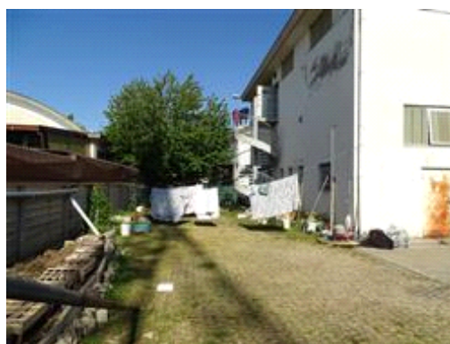
Vista posteriore dal cortile interno
