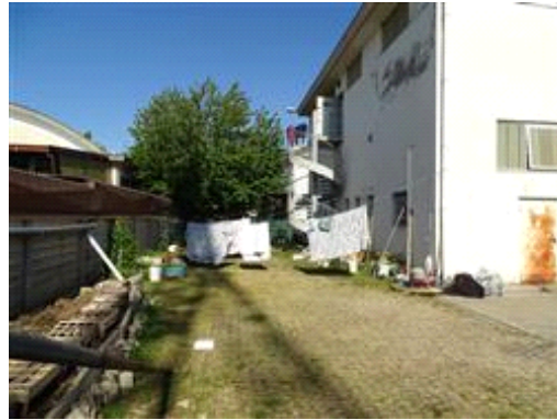
Vista posteriore dal cortile interno
