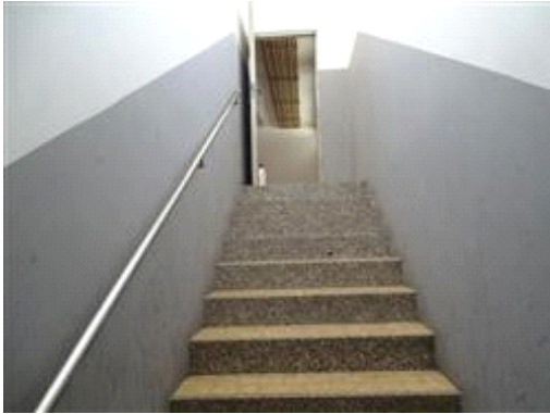
Vista scala accesso piano primo
