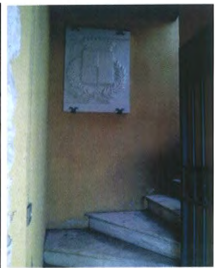
Scala di accesso alla terrazza piano terra
