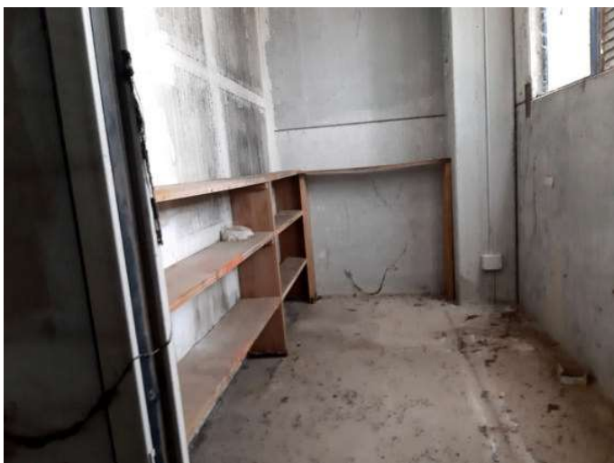
Foto n. 53 – Immobile B - Capannone produzione e lavorazione
