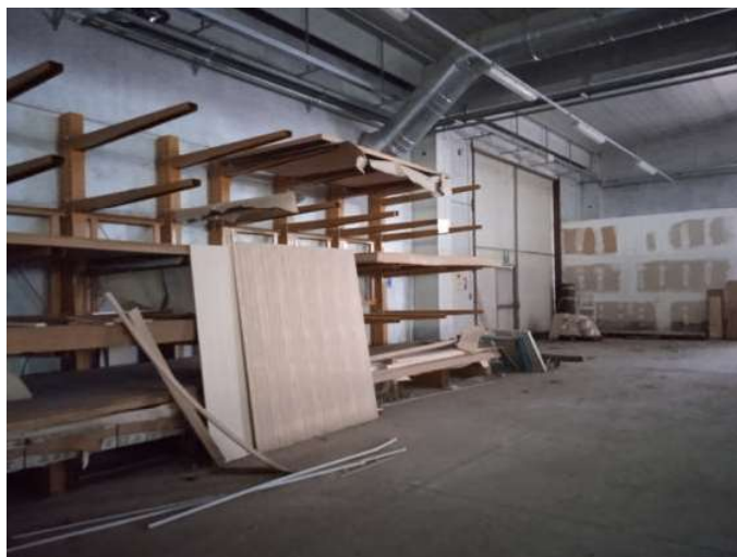
Foto n. 44 – Immobile B - Capannone produzione e lavorazione
