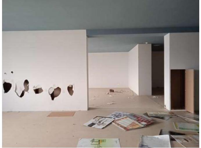
Foto n. 76 – Immobile C - Uffici ed esposizione - primo piano
