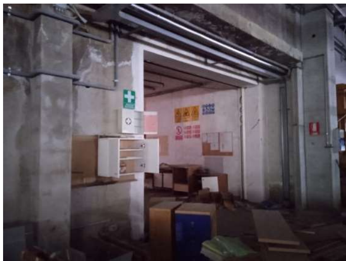
Foto n. 42 – Immobile B - Capannone produzione e lavorazione
