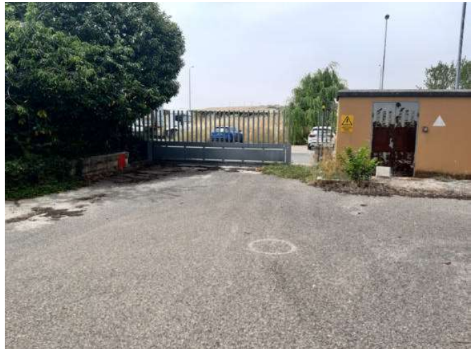
Foto n. 6 – Vista accesso cancello carrabile principale
