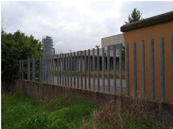
Foto n. 7 – Vista recinzione esterna
