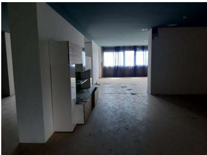
Foto n. 73 – Immobile C - Uffici ed esposizione - primo piano
