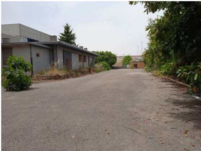
Foto n. 13 – Vista esterna - prospetto lato Nord
