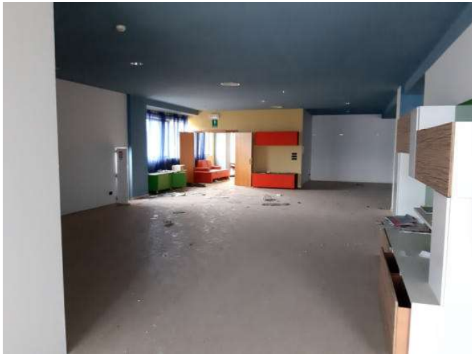
Foto n. 71 – Immobile C - Uffici ed esposizione - primo piano
