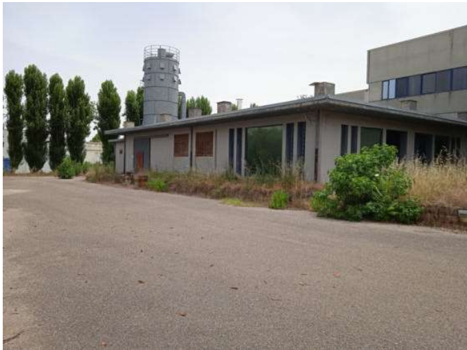
Foto n. 11 – Vista esterna - prospetto lato Nord
