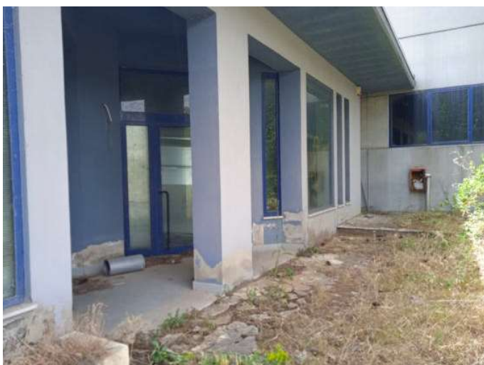
Foto n. 23 – Vista esterna - prospetto lato Ovest
