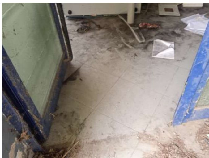
Foto n. 24 – Immobile A - Uffici produzione e magazzino - piano terra
