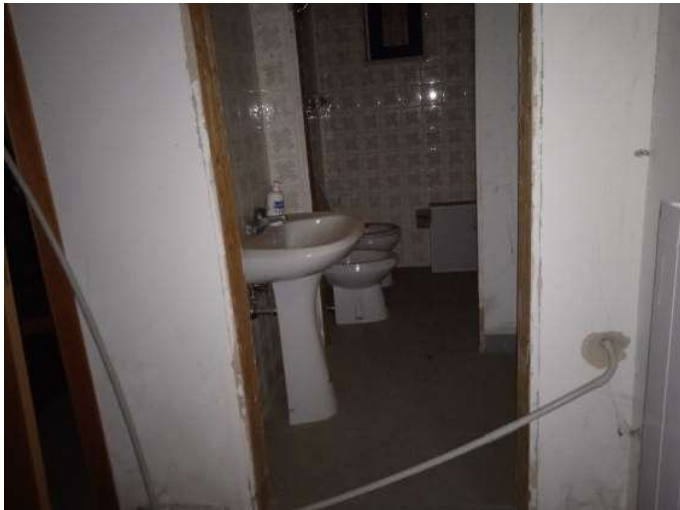
Foto n. 35 – Immobile A - Servizi - piano terra
