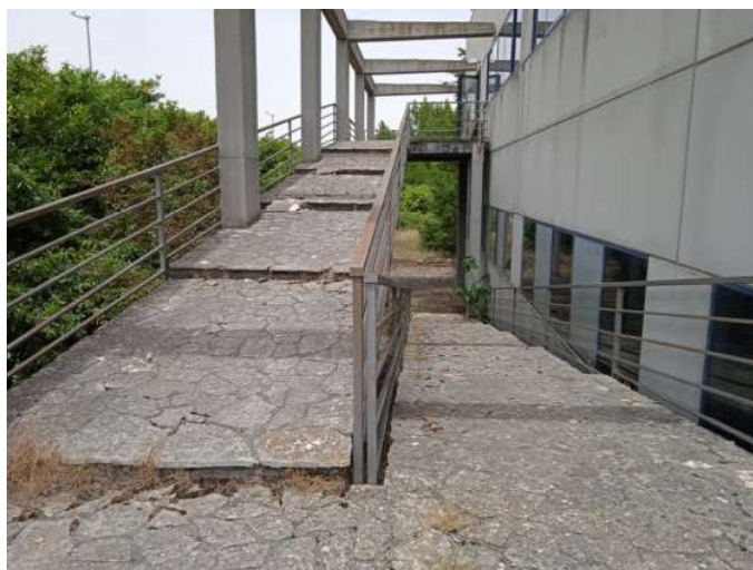
Foto n. 56 – Rampa di accesso al primo piano
