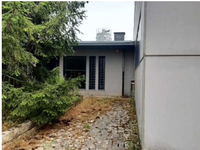
Foto n. 22 – Vista esterna - prospetto lato Ovest
