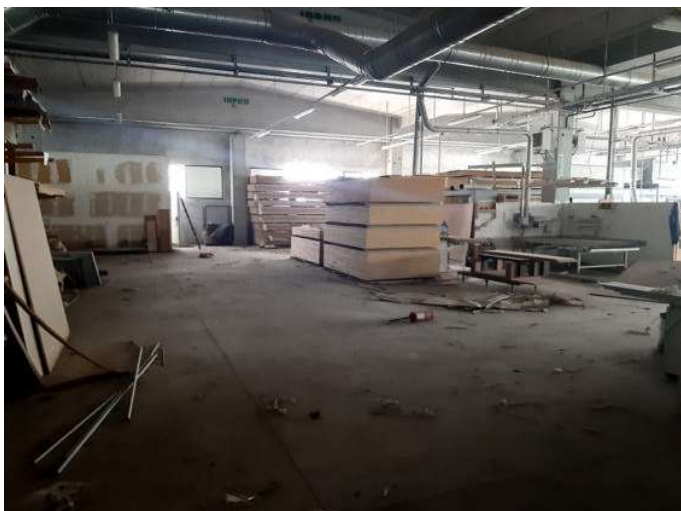
Foto n. 43 – Immobile B - Capannone produzione e lavorazione
