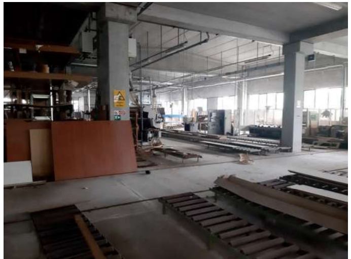
Foto n. 50 – Immobile B - Capannone produzione e lavorazione
