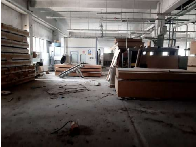
Foto n. 45 – Immobile B - Capannone produzione e lavorazione
