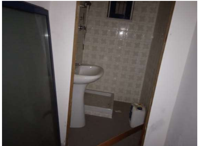
Foto n. 36 – Immobile A - Servizi - piano terra
