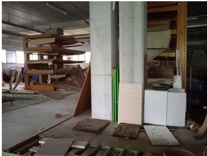
Foto n. 52 – Immobile B - Capannone produzione e lavorazione
