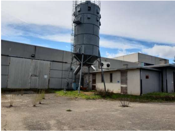
Foto n. 15 – Vista esterna - prospetto lato Nord
