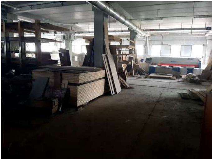
Foto n. 51 – Immobile B - Capannone produzione e lavorazione
