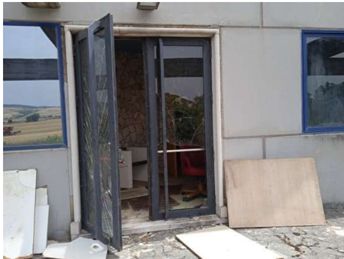
Foto n. 58 – Immobile C - Uffici ed esposizione - primo piano
