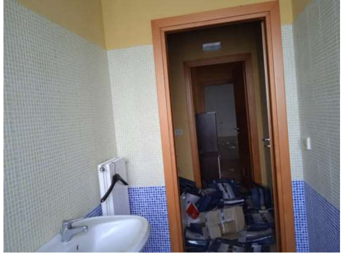
Foto n. 70 – Immobile C - Uffici ed esposizione - primo piano
