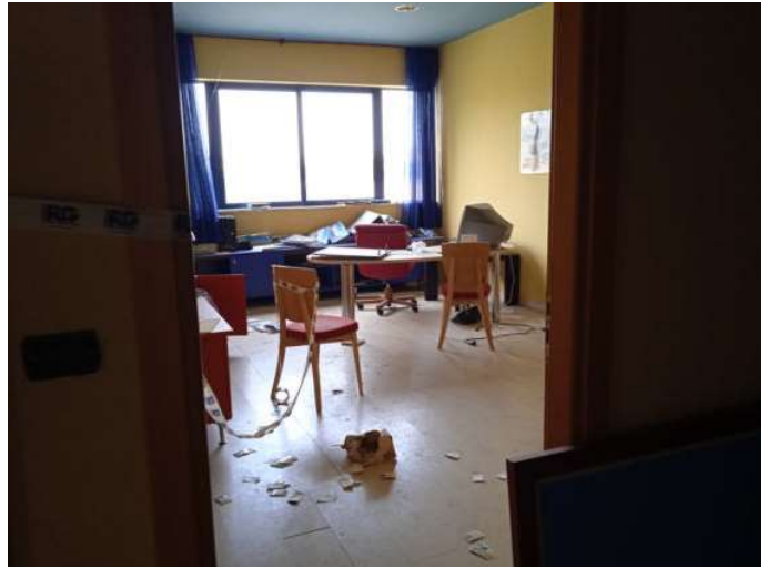
Foto n. 64 – Immobile C - Uffici ed esposizione - primo piano
