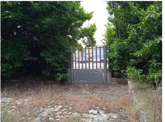
Foto n. 8 – Vista accesso cancello pedonale
