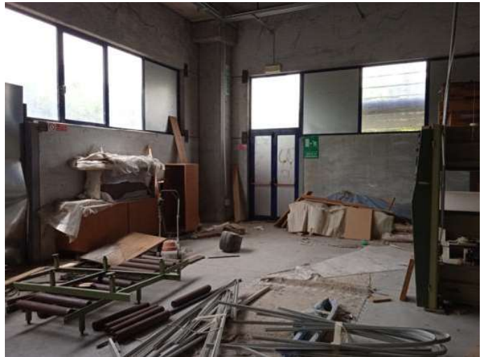
Foto n. 48 – Immobile B - Capannone produzione e lavorazione
