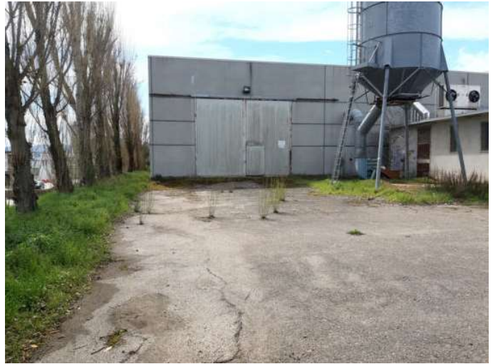
Foto n. 16 – Vista esterna - prospetto lato Nord
