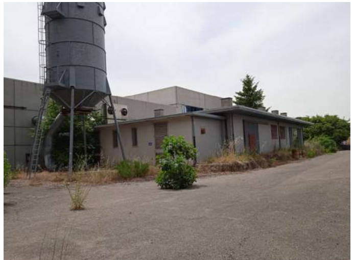
Foto n. 14 – Vista esterna - prospetto lato Nord
