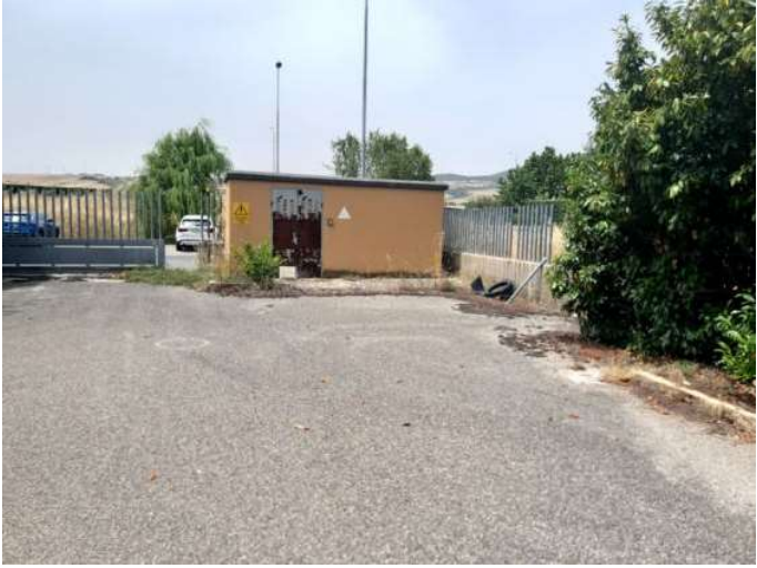
Foto n. 82 – Immobile D - Locali tecnici
