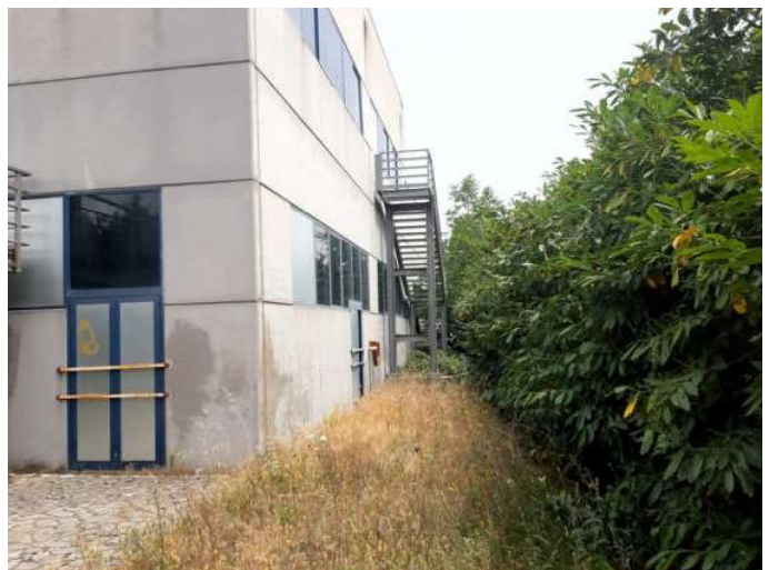
Foto n. 20 – Vista esterna - prospetto lato Sud
