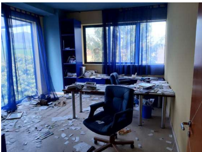
Foto n. 61 – Immobile C - Uffici ed esposizione - primo piano
