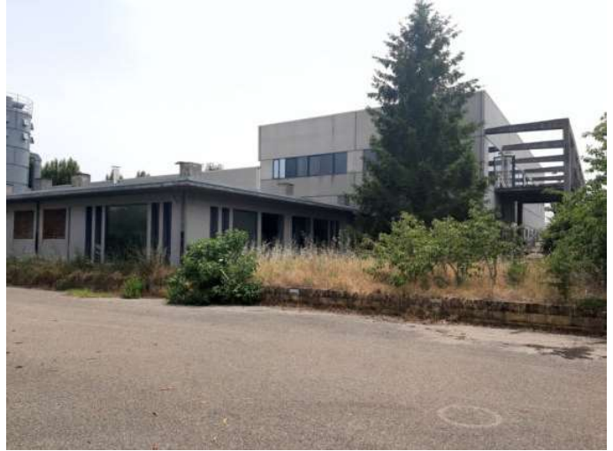
Foto n. 10 – Vista esterna - prospetto lato Nord
