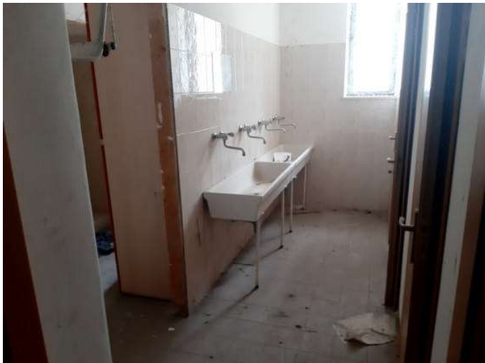
Foto n. 37 – Immobile A - Servizi - piano terra
