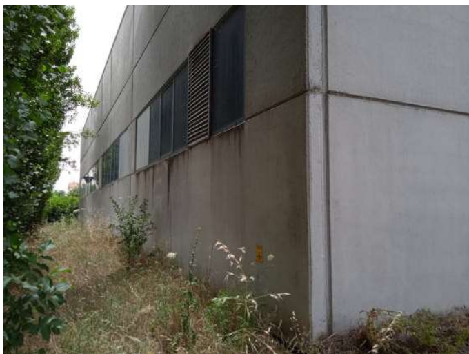
Foto n. 19 – Vista esterna - prospetto lato Est
