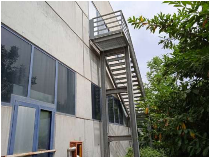
Foto n. 21 – Vista esterna - prospetto lato Sud
