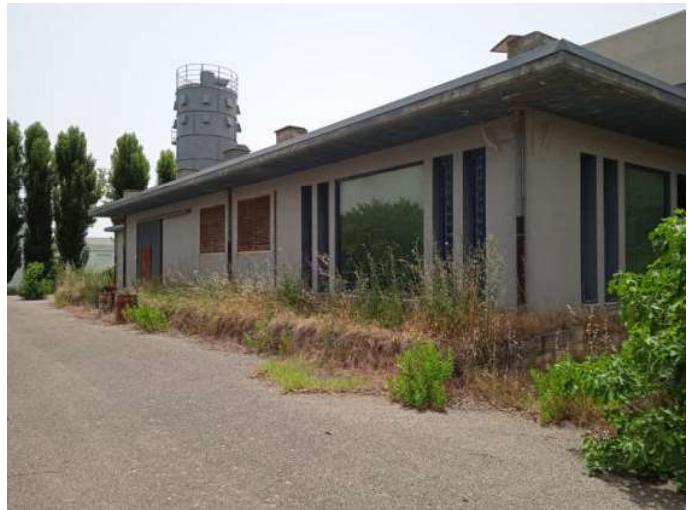
Foto n. 12 – Vista esterna - prospetto lato Nord
