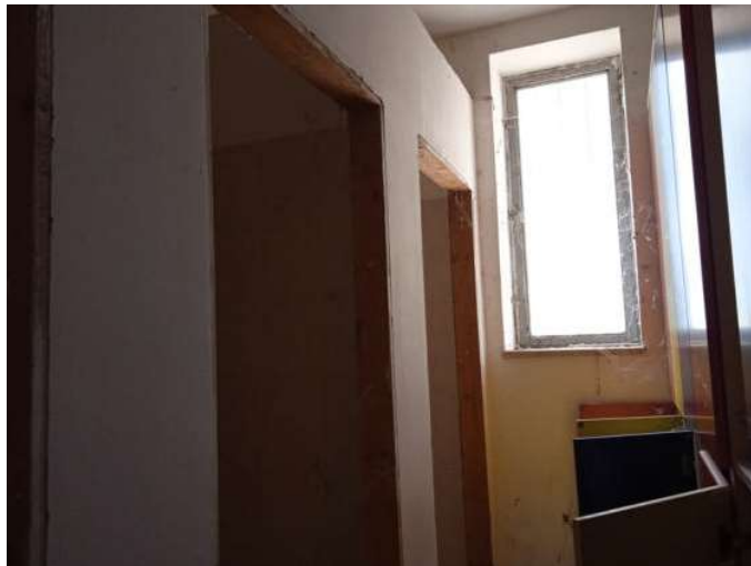
Foto n. 40 – Immobile A - Servizi - piano terra
