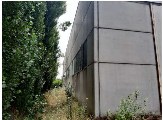
Foto n. 18 – Vista esterna - prospetto lato Est
