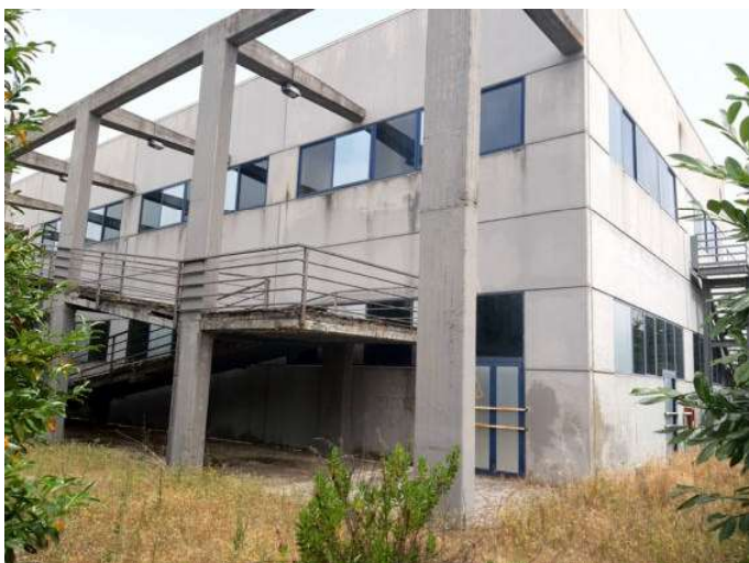
Foto n. 55 – Rampa di accesso al primo piano
