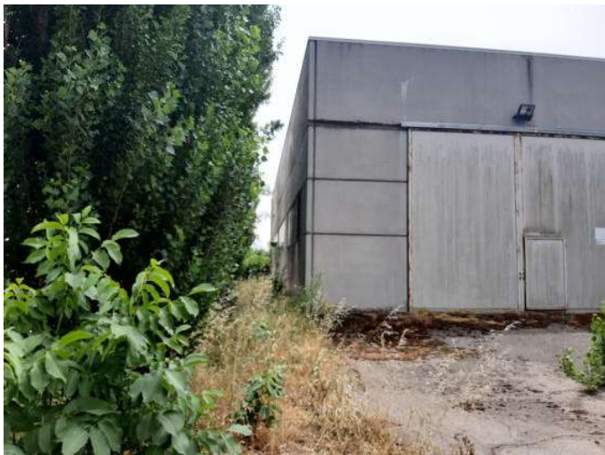
Foto n. 17 – Vista esterna - prospetto lato Est
