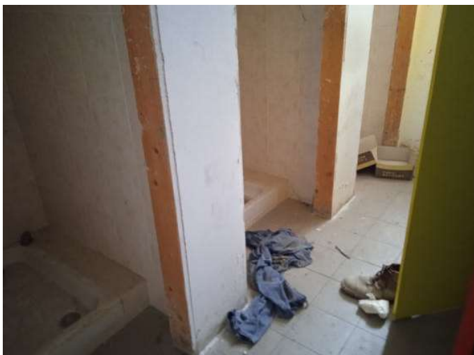
Foto n. 41 – Immobile A - Servizi - piano terra
