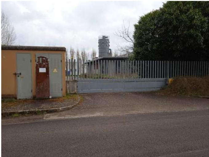
Foto n. 5 – Vista accesso cancello carrabile principale
