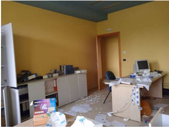
Foto n. 63 – Immobile C - Uffici ed esposizione - primo piano
