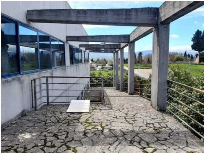
Foto n. 57 – Rampa di accesso al primo piano
