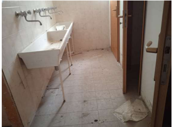
Foto n. 38 – Immobile A - Servizi - piano terra
