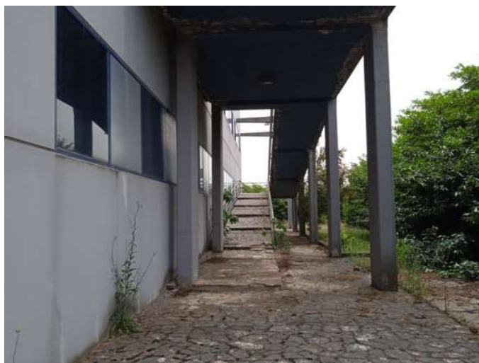
Foto n. 54 – Rampa di accesso al primo piano
