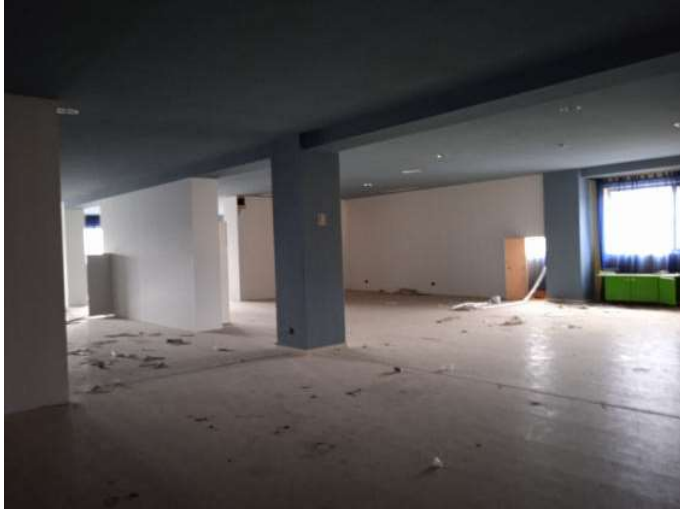
Foto n. 75 – Immobile C - Uffici ed esposizione - primo piano
