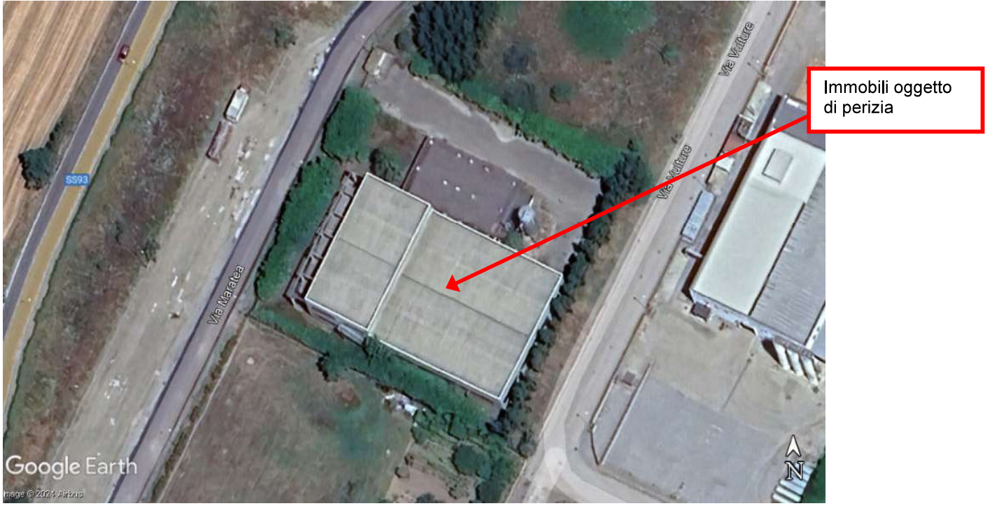
Foto n. 2 – Immobili siti in Atella - Zona PIP - Vista aerea
