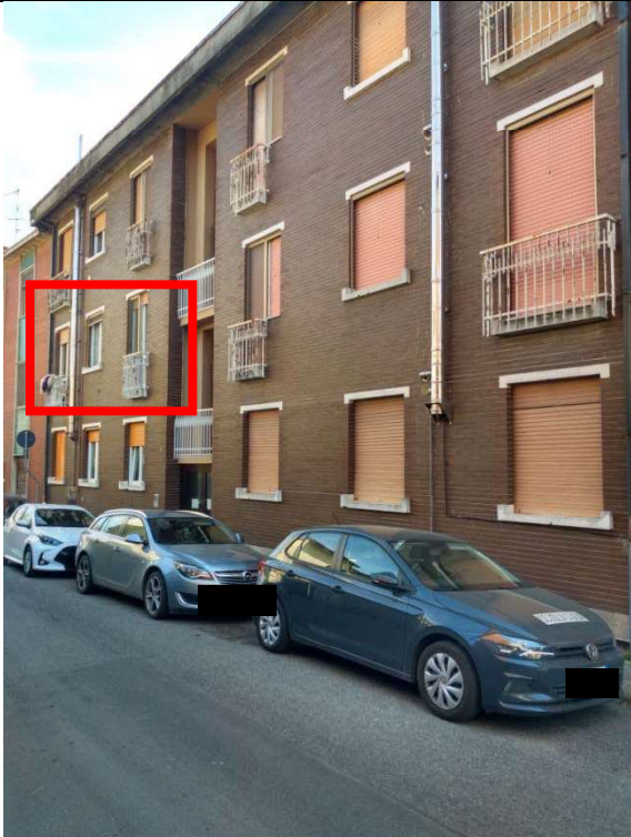
Immagine 1 – Vista dello stabile dalla Via Umberto I con indicazione dell'appartamento oggetto di stima
