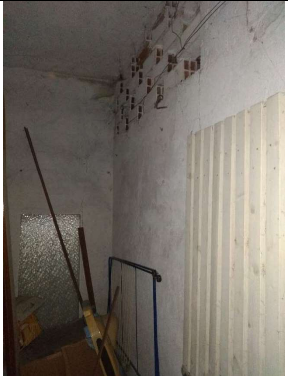
Immagine 18 - Vista interna della cantina pertinenziale
