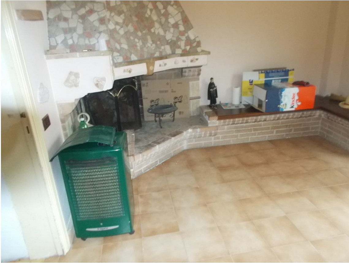
Foto 07 – Particolare camino Piano Terra
