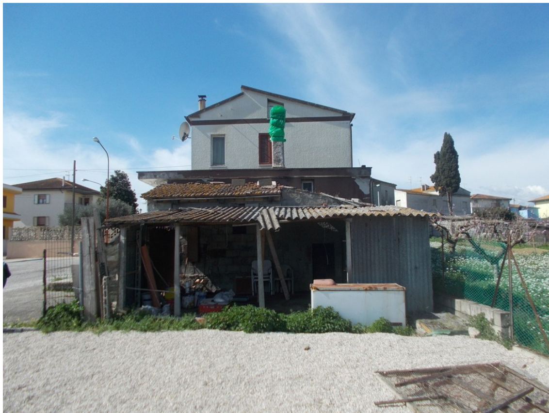
Foto 02 – Vista esterna immobile
