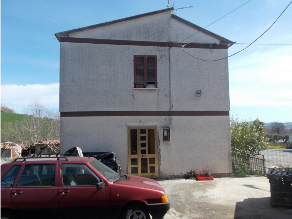
Foto 03 – Vista esterna immobile
