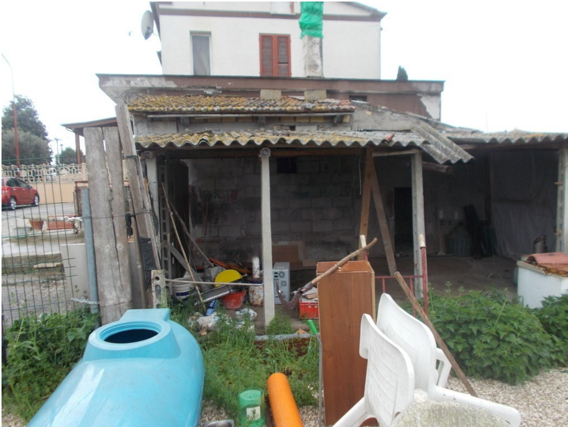
Foto 15 – Annessi da demolire
