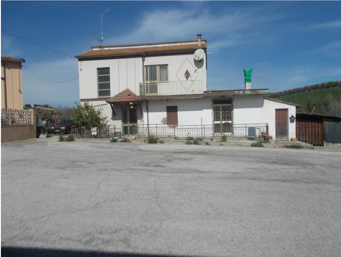
Foto 01 – Vista esterna immobile
