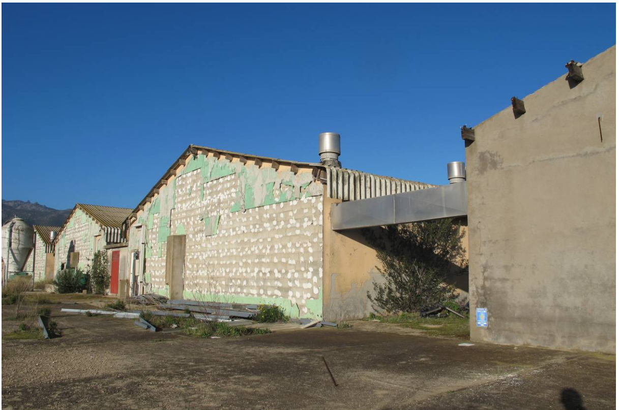
66 – BOX SVEZZAMENTO, BOX INGRASSO E SALE PARTO – (Particelle 153-154-155-149) Fronte Est
