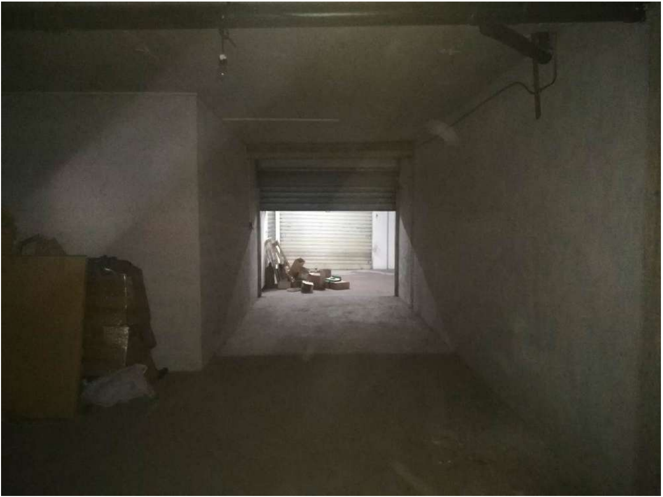
Foto 6 – visione interna della porta di accesso
