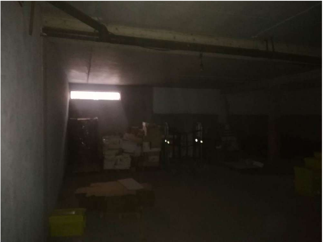
Foto 10 interno . finestra alta sulla rampa di accesso da Piazza Aldo Moro
