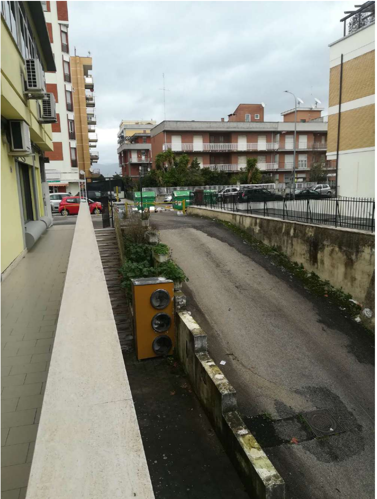
Foto 3 – rampa di ingresso da Via degli Aurunci
