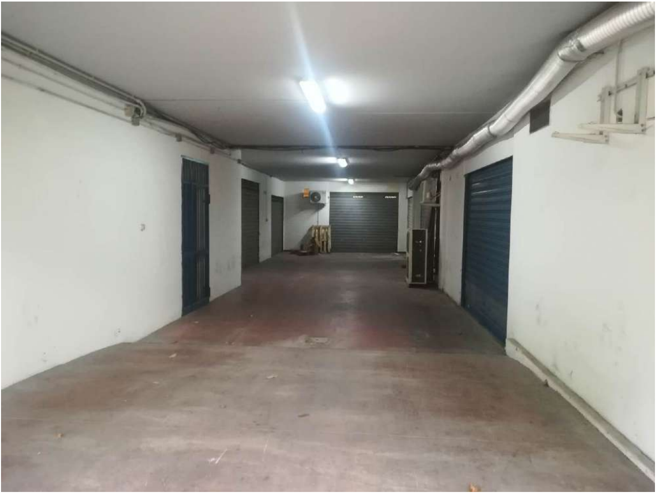
Foto 4 – corridoio di accesso ai magazzini
