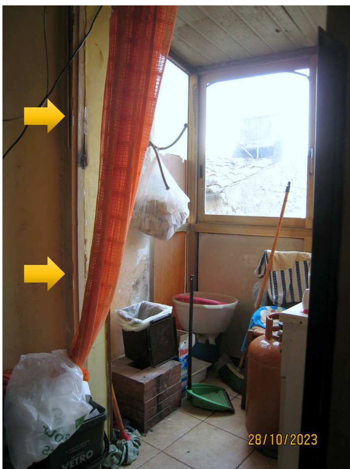
Foto n. 61-62. L'originario terrazzino attinente la cucina è stato chiuso con una struttura in alluminio, pannelli sintetici e copertura con pannelli grecati tipo sandwich. L'originario infisso, segnato da frecce gialle, è stato rimosso.
