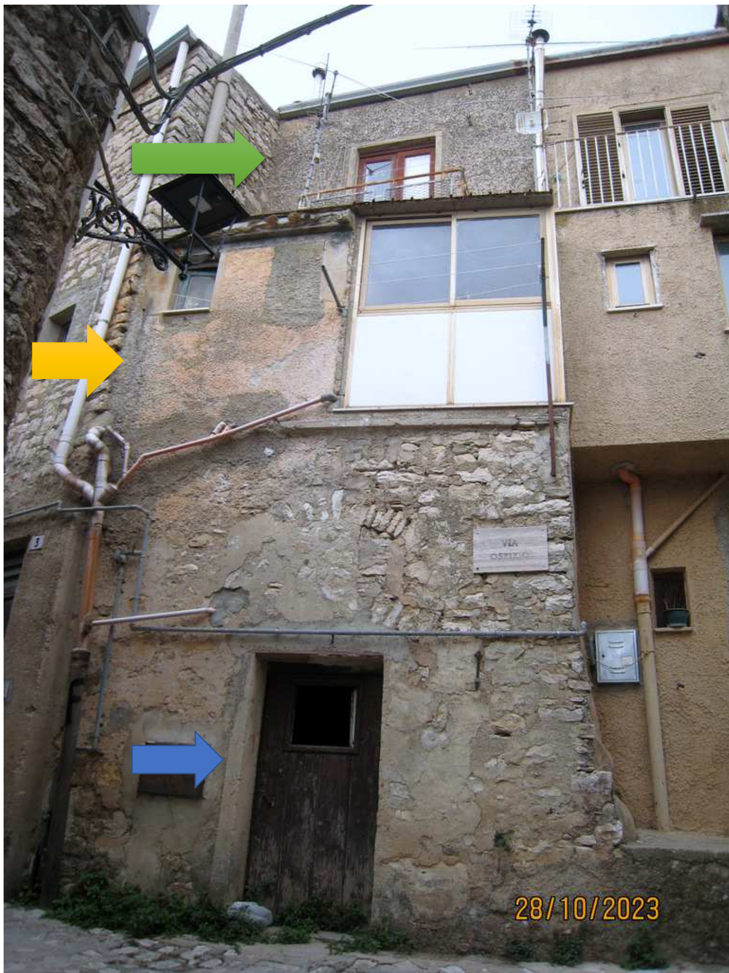
Foto n. 45. Il prospetto su Via Ospizio. La freccia verde segnala il P.T. rispetto alla Via S. Antonio; la freccia gialla il piano seminterrato rispetto alla Via S. Antonio. La freccia blu il piano terra su Via Ospizio indicato nella planimetria catastale del 1962, ma non in possesso della debitrice, come ha dichiarato durante il primo accesso.
