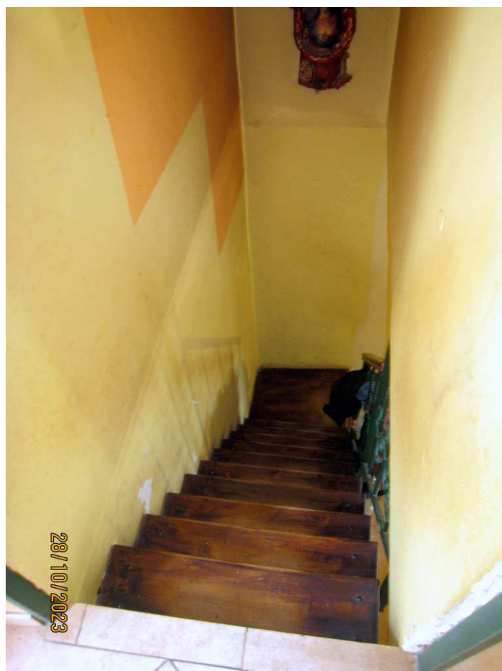
Foto n. 49. La scala che si diparte dall'ingresso e scende verso il piano seminterrato
