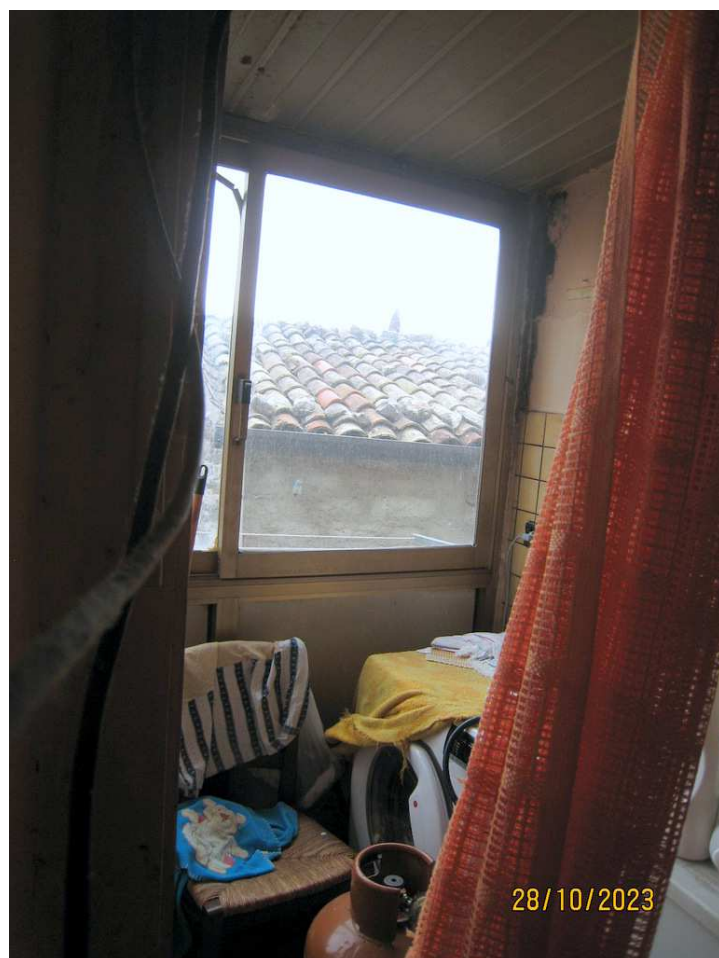
Foto n. 61-62. L'originario terrazzino attinente la cucina è stato chiuso con una struttura in alluminio, pannelli sintetici e copertura con pannelli grecati tipo sandwich. L'originario infisso, segnato da frecce gialle, è stato rimosso.
