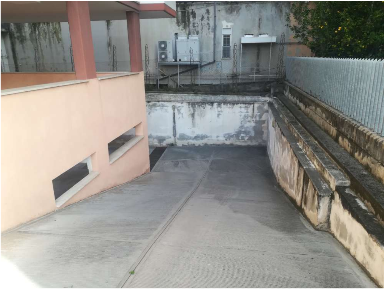
Foto 2 – rampa di accesso
