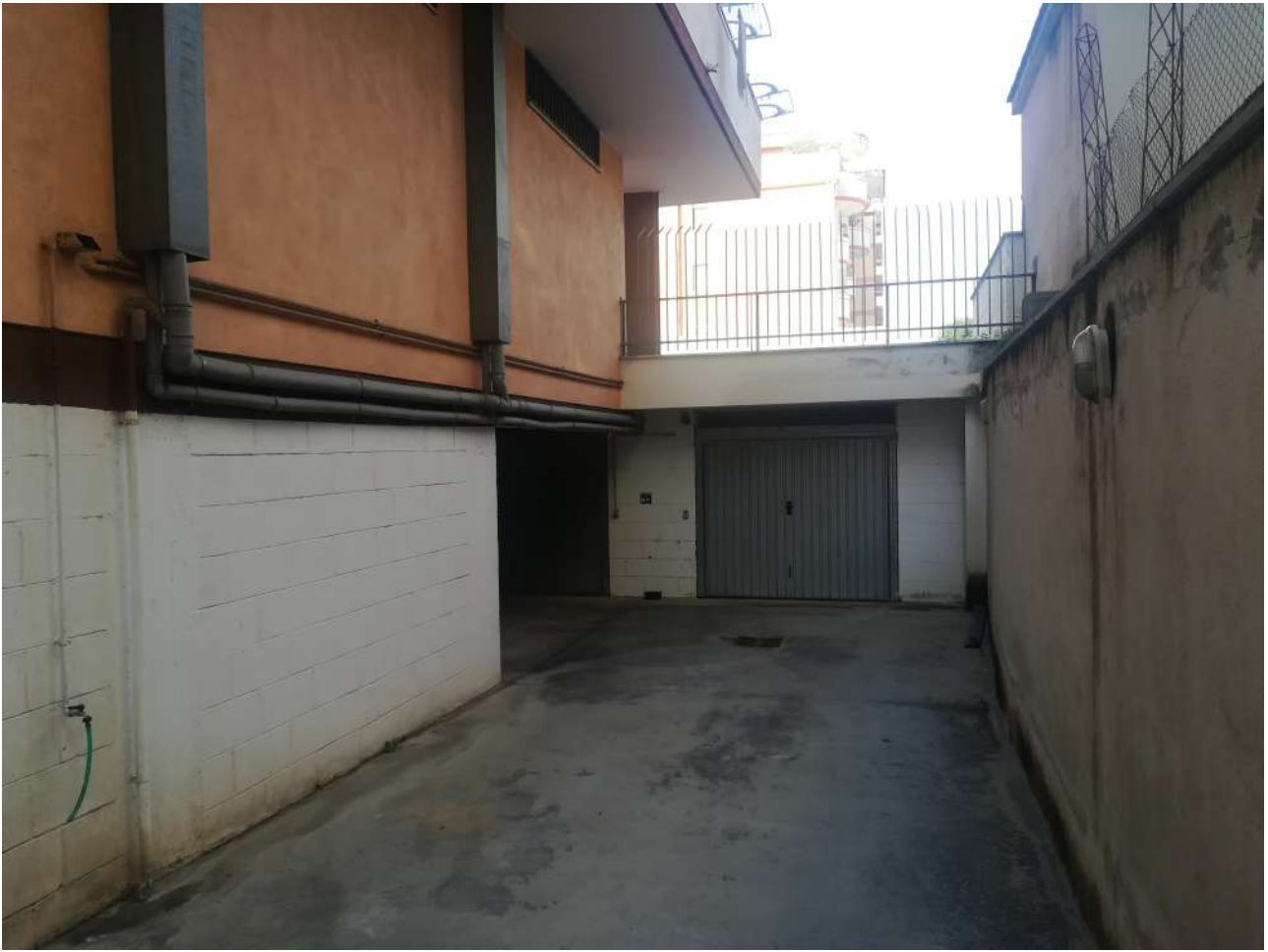
Foto 3 – rampa di accesso
