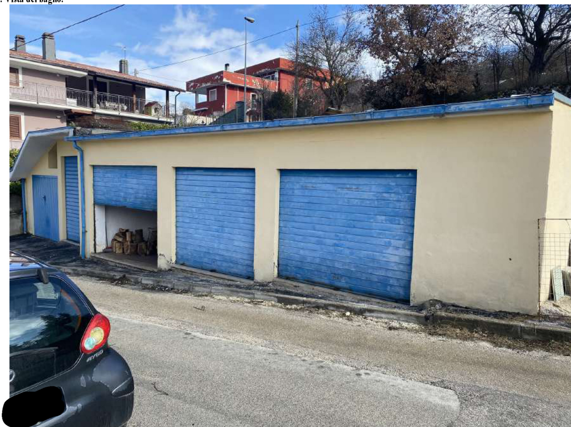
Foto 26: Vista del Garage (Primo garage da DX).
