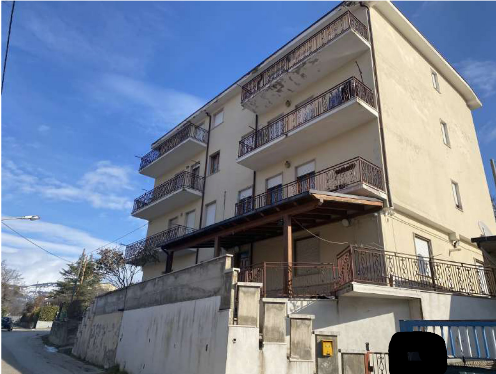
Foto 2: Vista d'insieme del fabbricato e del Bene al livello rialzato da strada.
