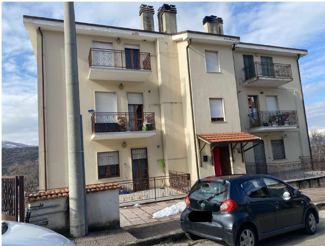
Foto 15: Vista d'insieme del fabbricato e del Bene, porzione a SX al Primo livello dalla strada.
