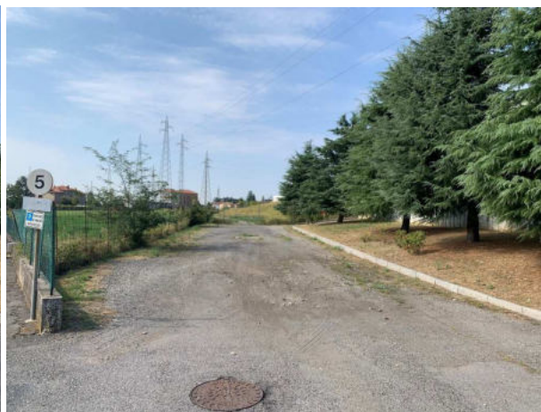
Foto 1 – strada lott. da completare
