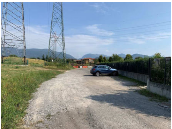
Foto 10 – strada lottizzazione da completare
