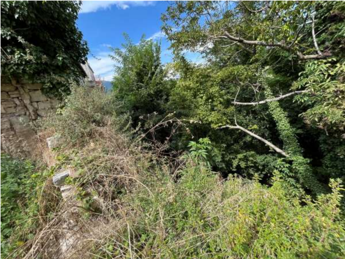
FOTO 12: VISTA LATO NORD-OVEST E RETRO DELL'EDIFICIO
