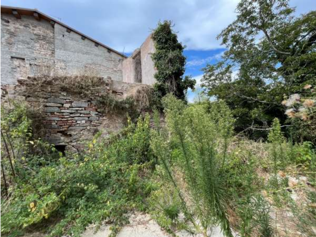
FOTO 10: PARTICOLARE LATO NORD-EST (ANGOLO NORD-OVEST)
