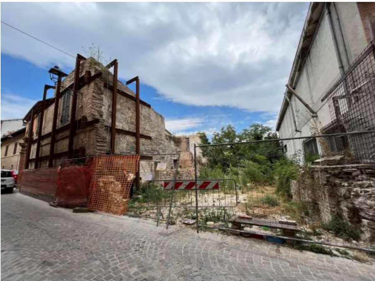
FOTO 5: PARTICOLARE LATO NORD-EST E DELLA CORTE
