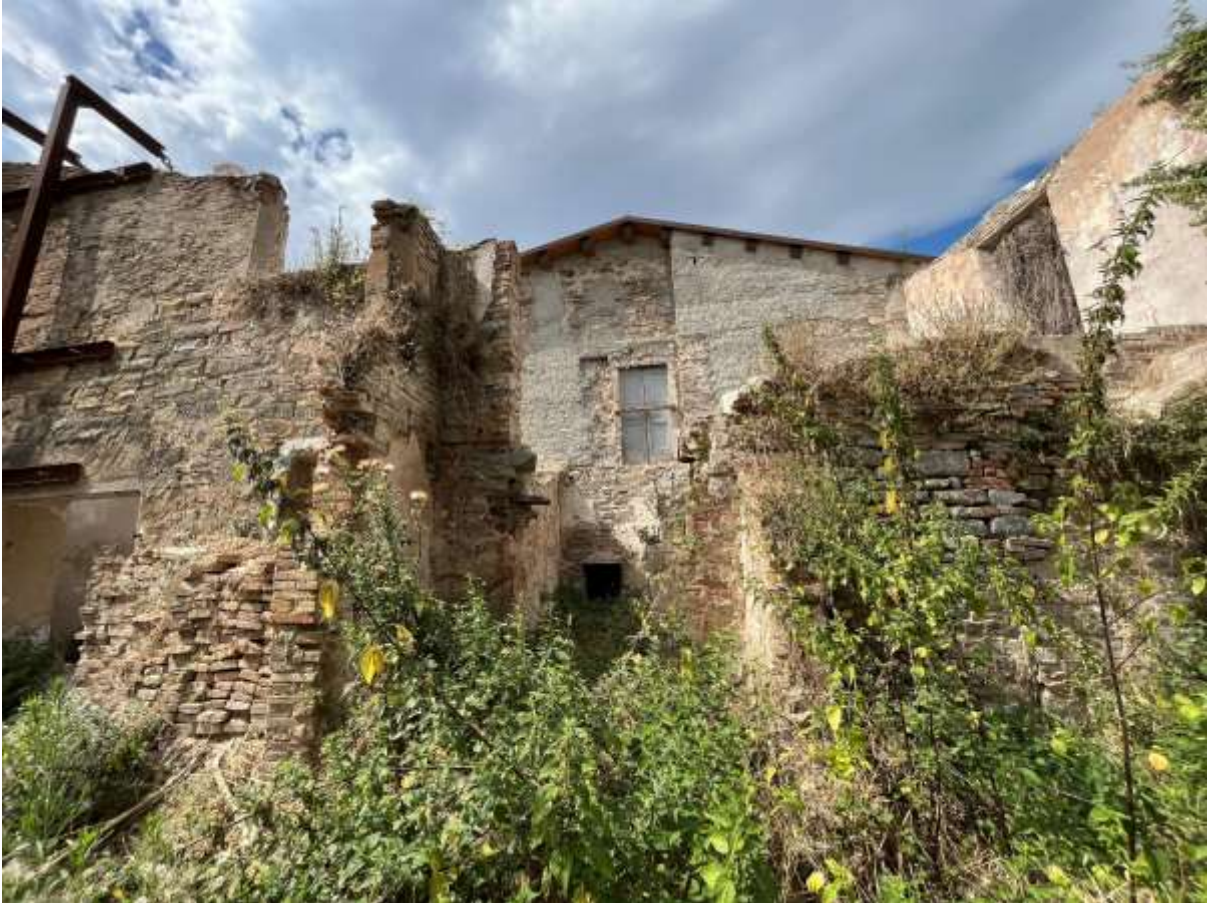
FOTO 8: PARTICOLARE LATO NORD-EST DALLA CORTE
