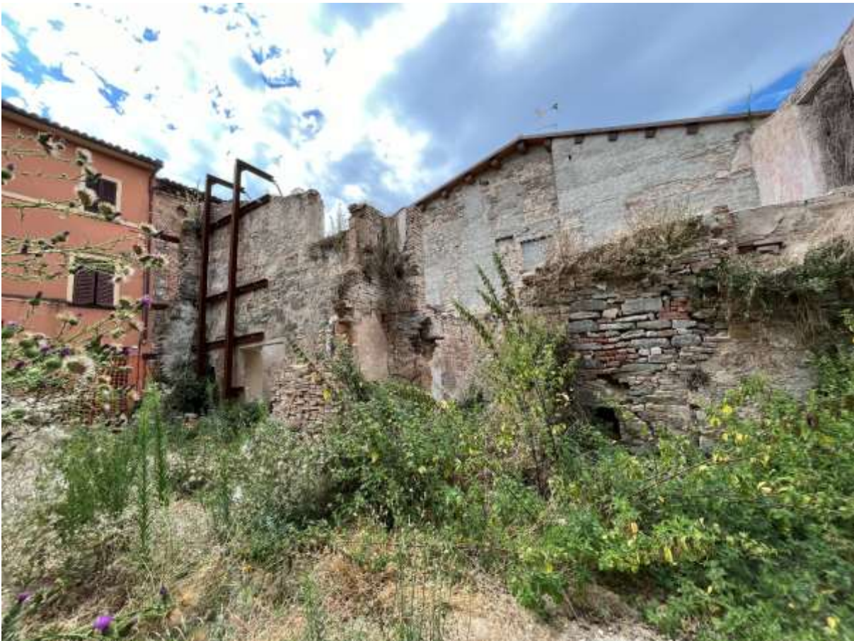
FOTO 9: PARTICOLARE LATO NORD-EST DALLA CORTE VISTA DA NORD-OVEST
