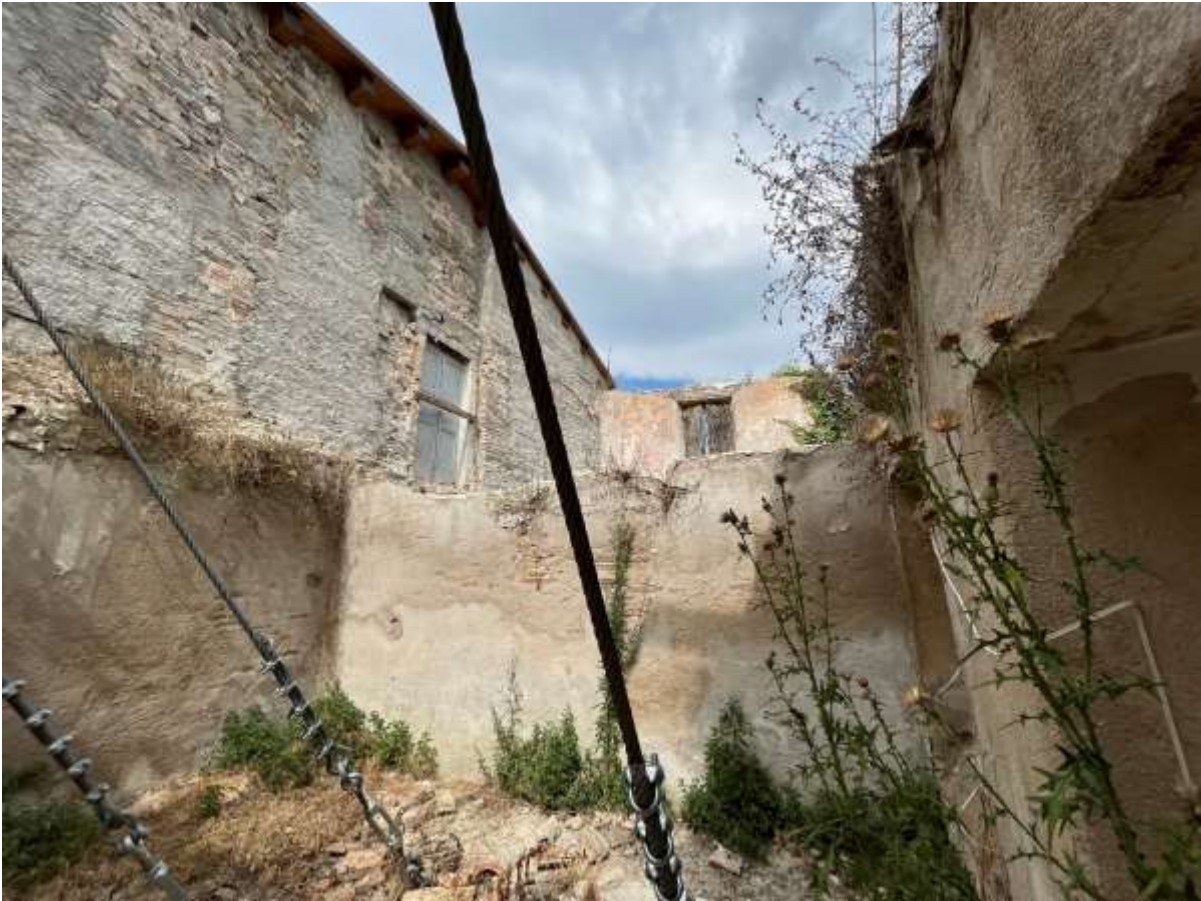
FOTO 16: VISTA INTERNA PORZIONE A RIDOSSO DI VIA UMBERTO I
