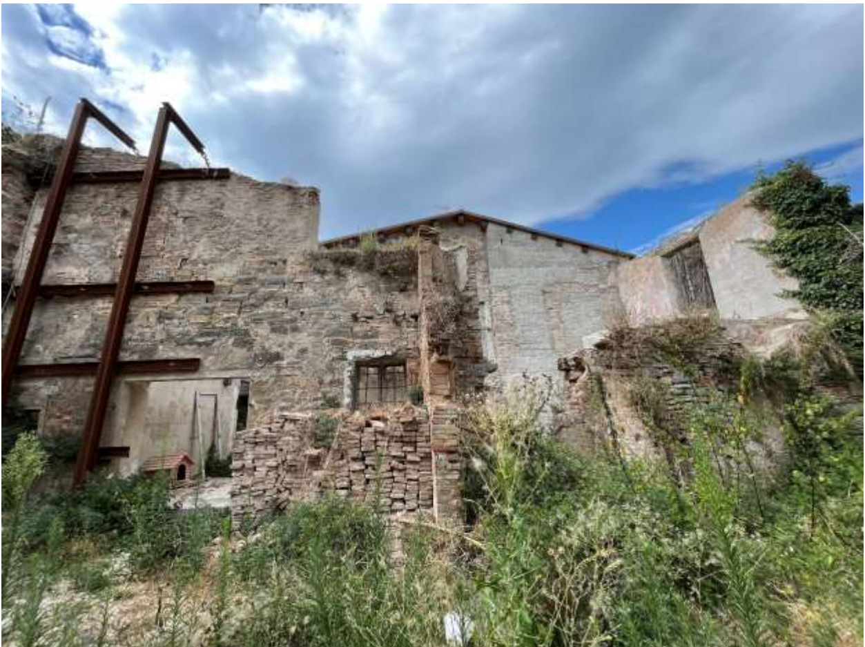
FOTO 7: PARTICOLARE LATO NORD-EST DALLA CORTE (VISTA FRONTALE)
