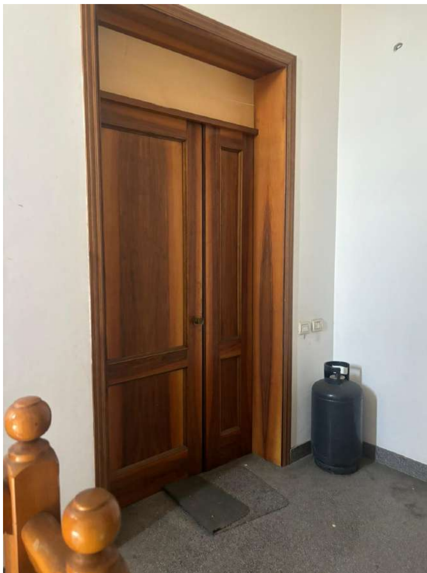
Foto 07 Ingresso Foglio 10 - Part.896 - Sub.11 Piano terzo
