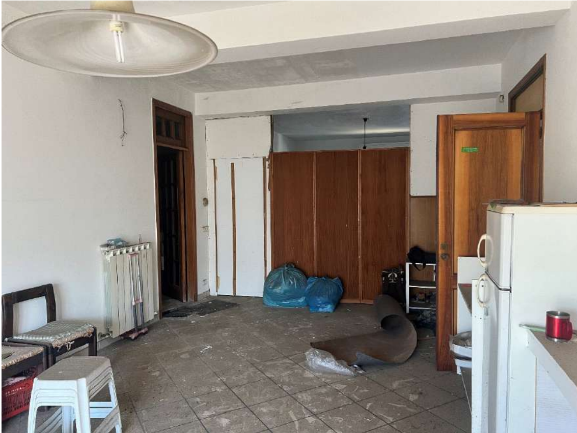
Foto 09 Cucina/Soggiorno Foglio 10 - Part.896 - Sub.11 Piano terzo
