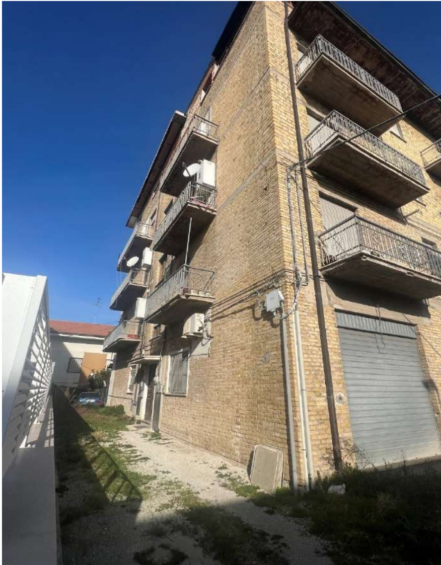
Foto 01 Vista lato ingresso
