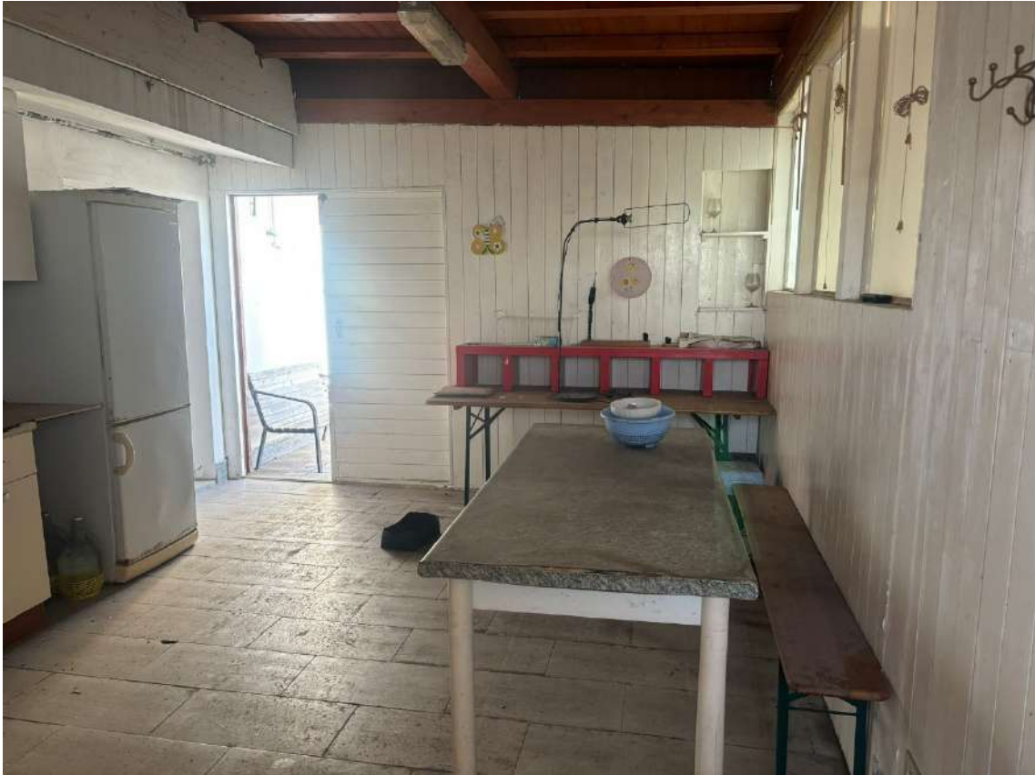
Foto 57 Chiusura balcone Foglio 10 – Part.896 - Sub.19 Piano quarto
