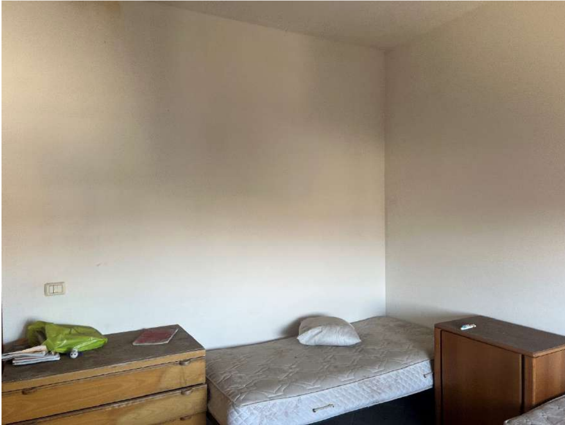
Foto 14 Camera Foglio 10 - Part.896 - Sub.11Piano terzo
