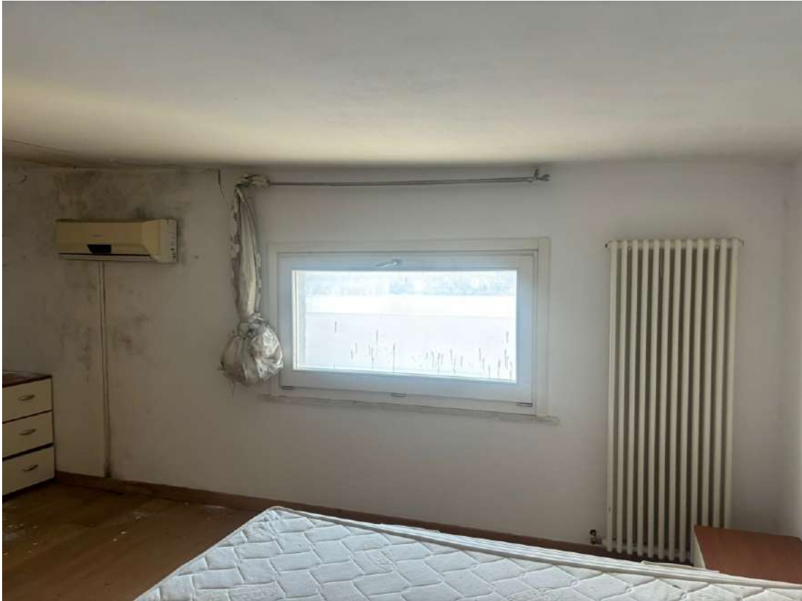
Foto 37 Camera Foglio 10 - Part.896 - Sub.19 Piano quarto
