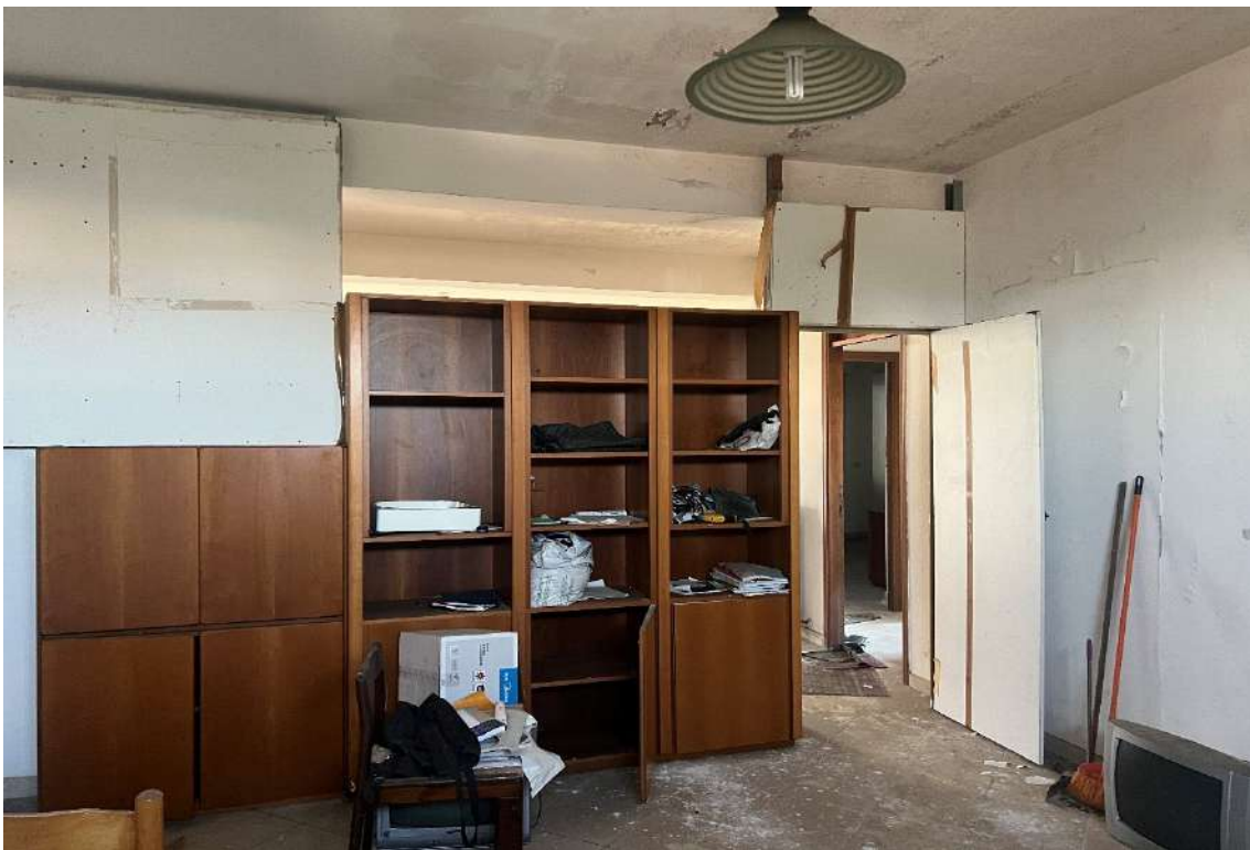
Foto 15 Camera Foglio 10 - Part.896 - Sub.11Piano terzo
