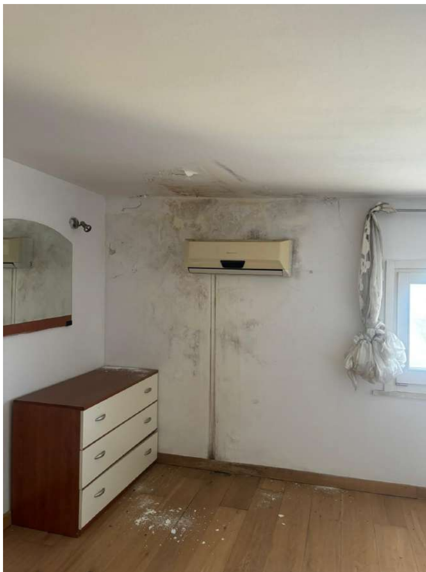
Foto 36 Camera Foglio 10 - Part.896 - Sub.19 Piano quarto
