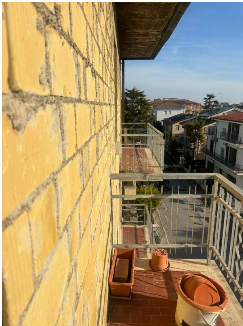
Foto 22 Terrazzo Foglio 10 - Part.896 - Sub.12 Piano terzo
