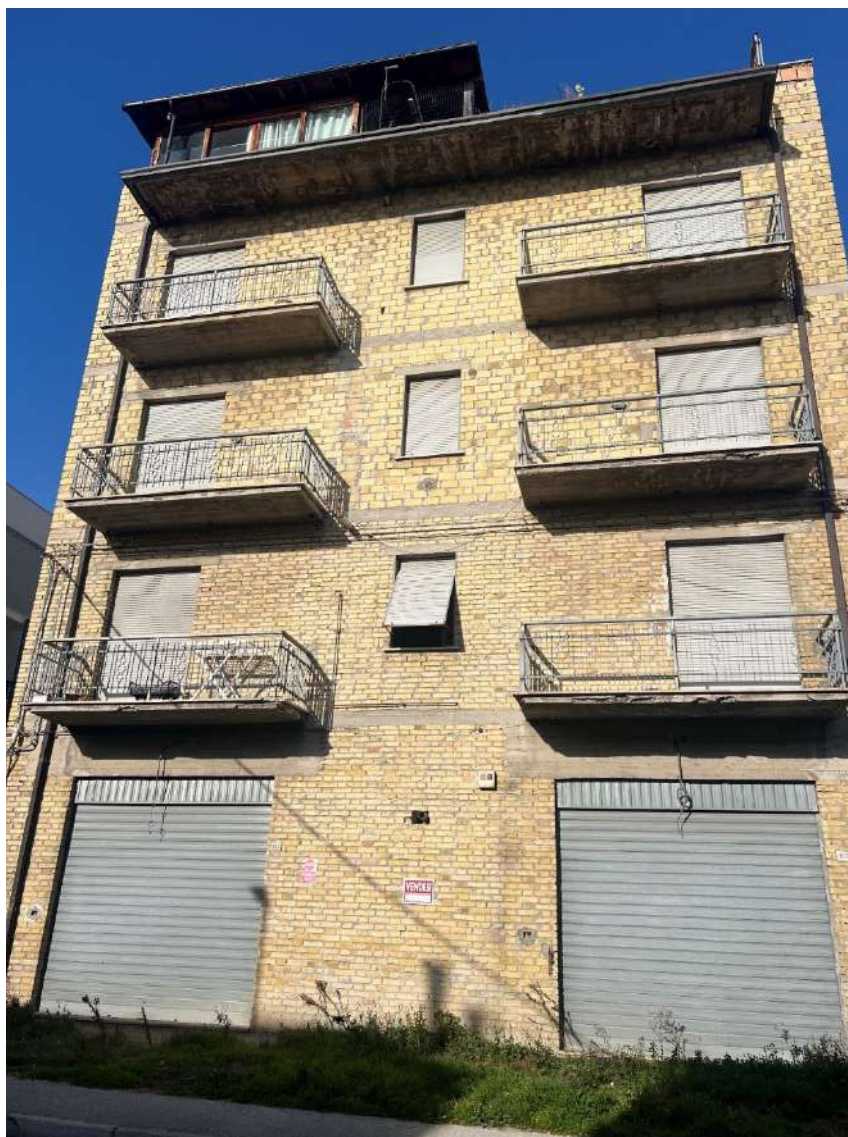
Foto 03 Vista lato su strada
