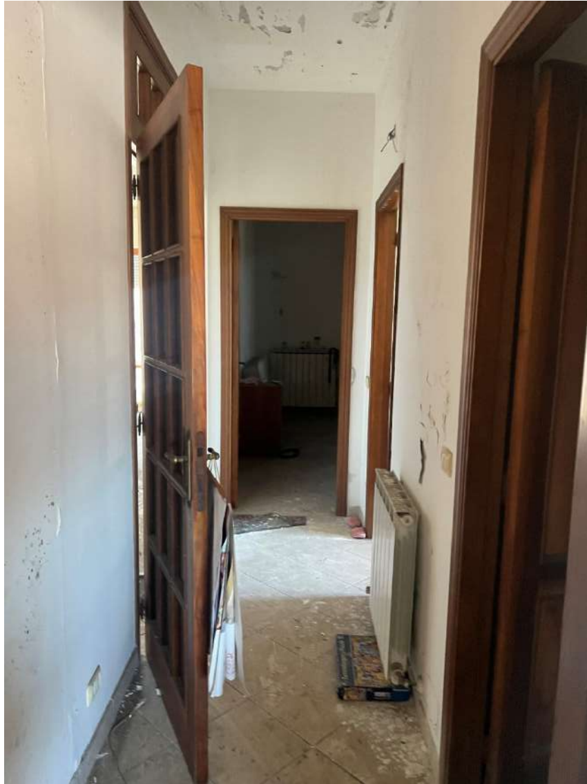
Foto 16 Corridoio Foglio 10 - Part.896 - Sub.11 Piano terzo
