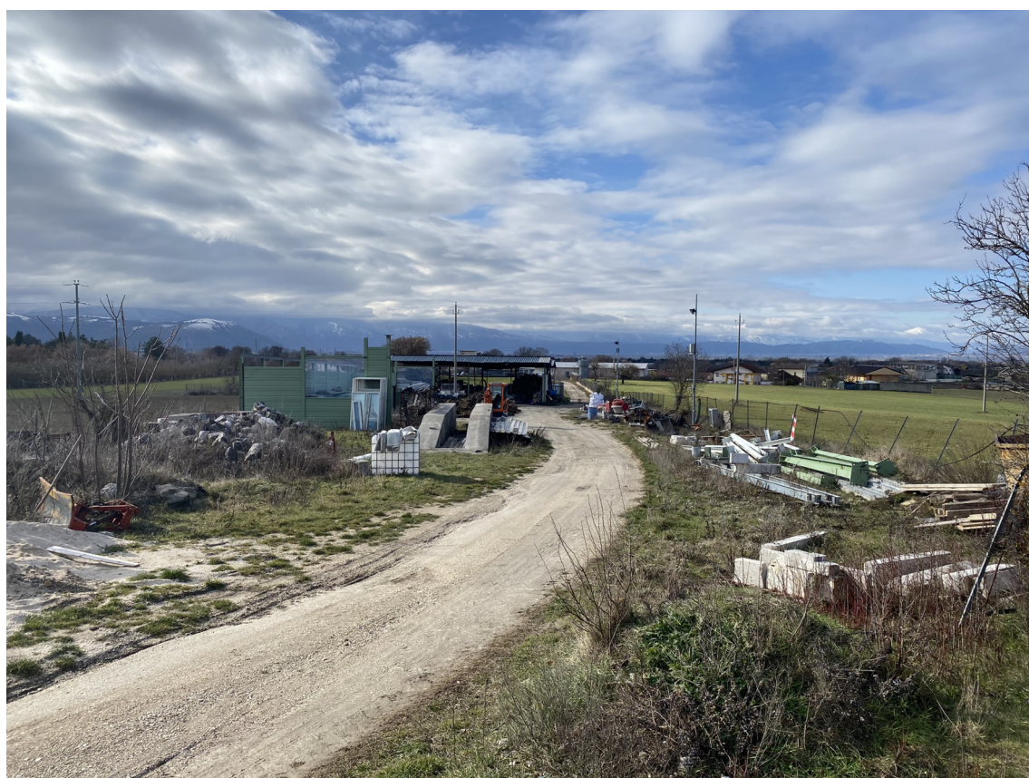
Foto D: Materiali ed Attrezzature edili presenti e sparse in modo diffuso sul terreno.
