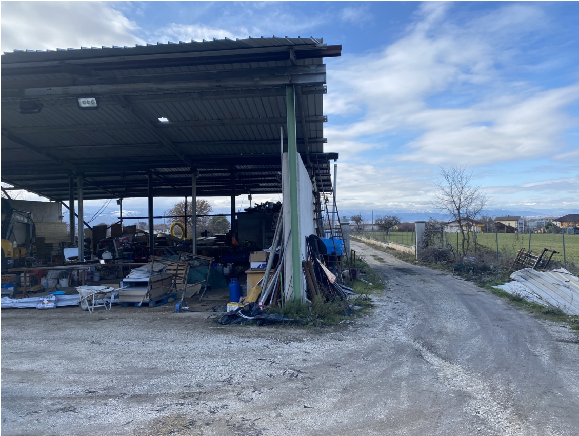
Foto A: Vista della Tettoia Metallica da smantellare.
