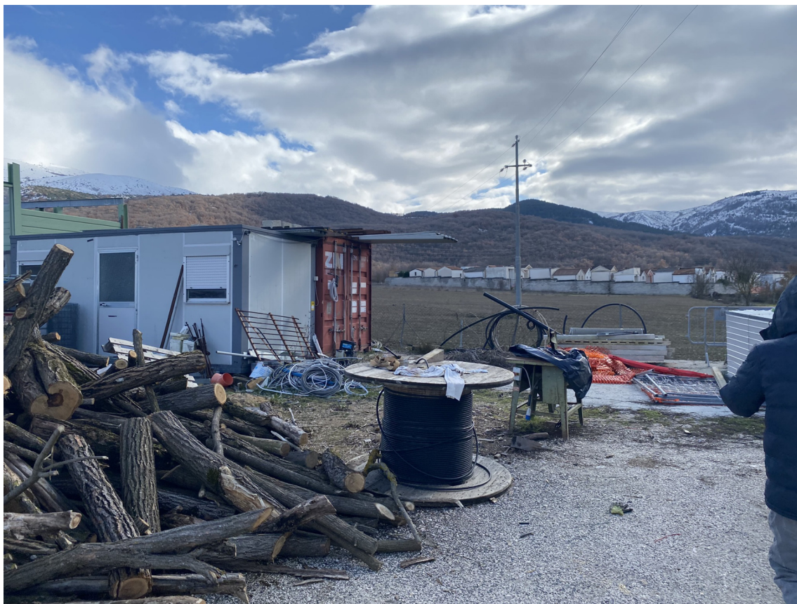
Foto C: Container ad uso Ufficio removibile da smantellare.
