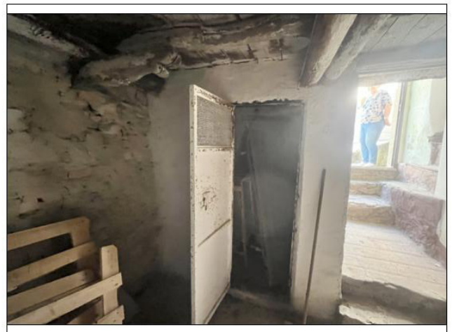
Magazzino al Piano Terra
