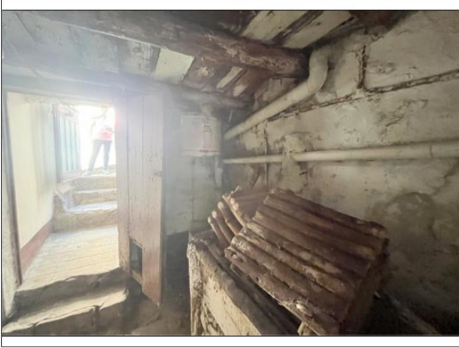
Magazzino al Piano Terra
