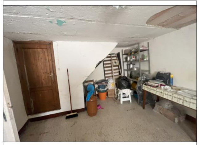
Camera Piano Primo con accesso dalla Part. 679 sub 2
