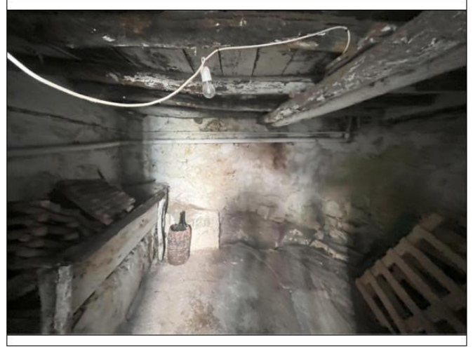
Magazzino al Piano Terra
