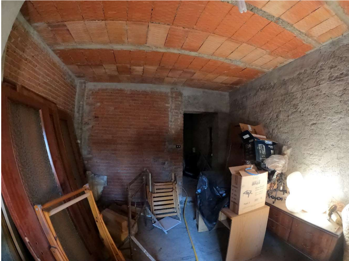
Foto 11 – Camera da ristrutturare al piano primo
