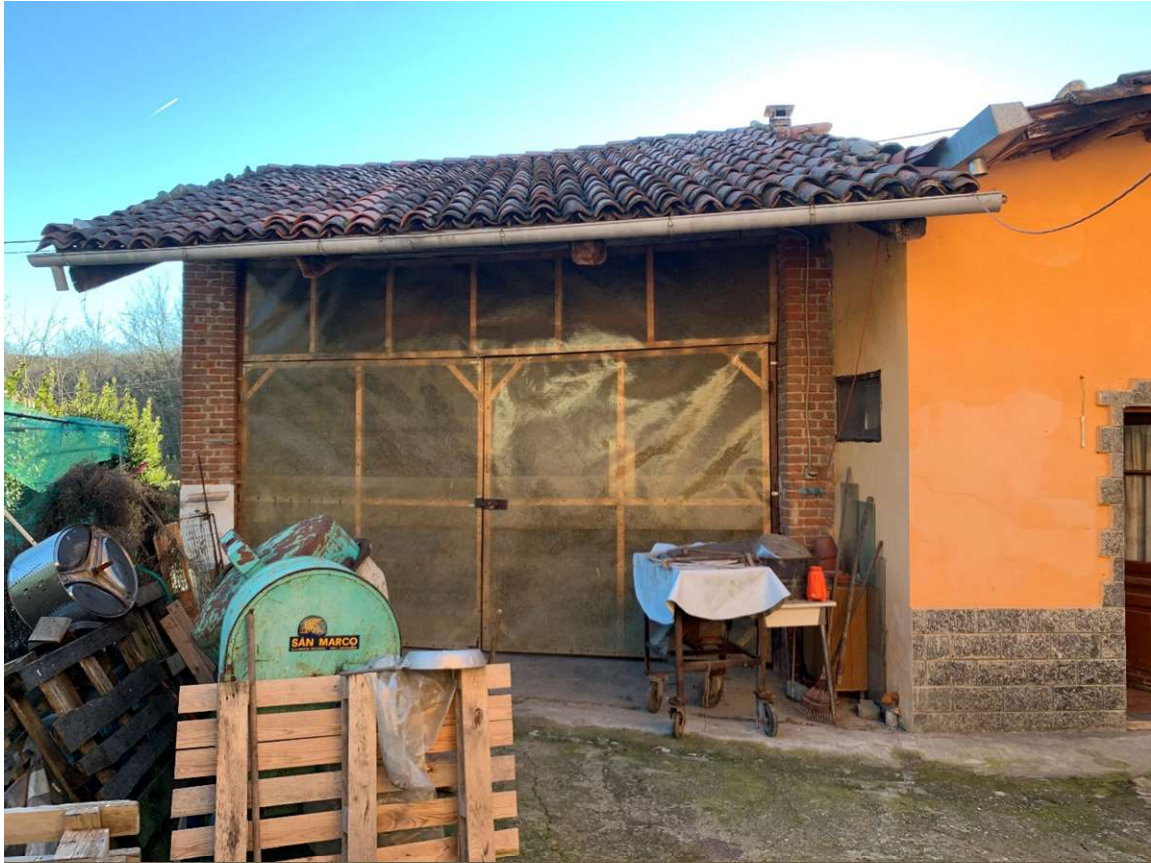
Foto 3 – Locale accessorio verso la strada
