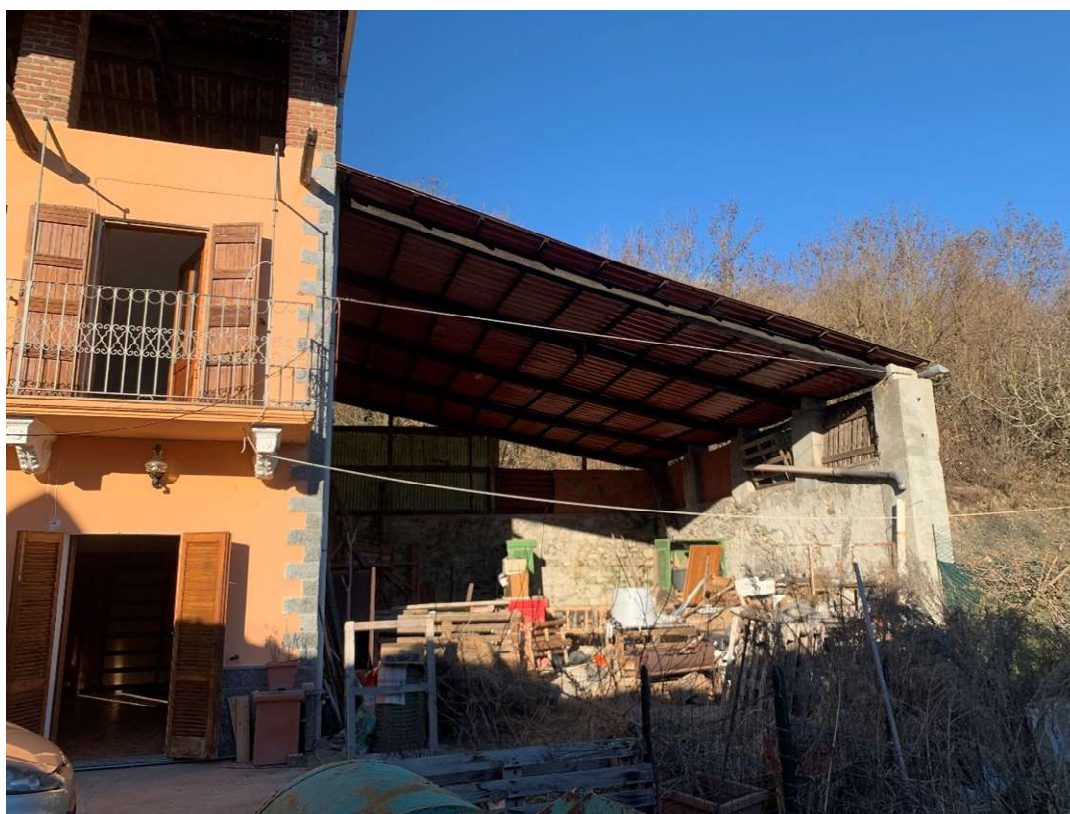
Foto 2 – Vista della tettoia laterale
