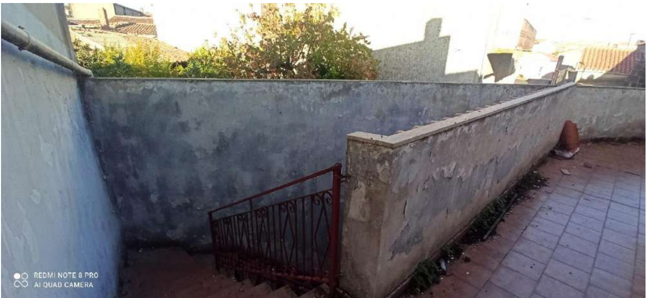
Foto n.04 – terrazzo accesso piano primo
