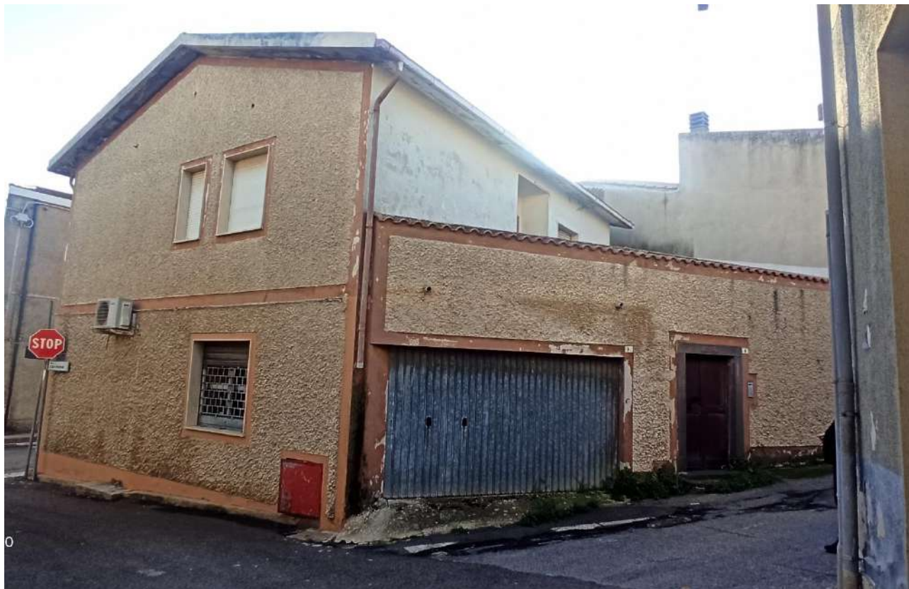
Foto n.01 – prospetto su strada, via Carmine, Borore
