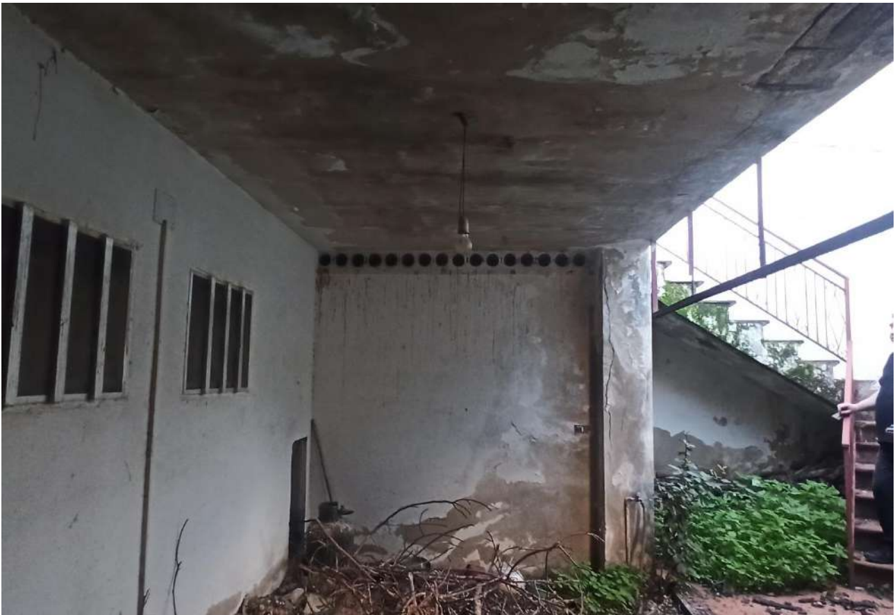
Foto n.03 – vista porticato piano terra
