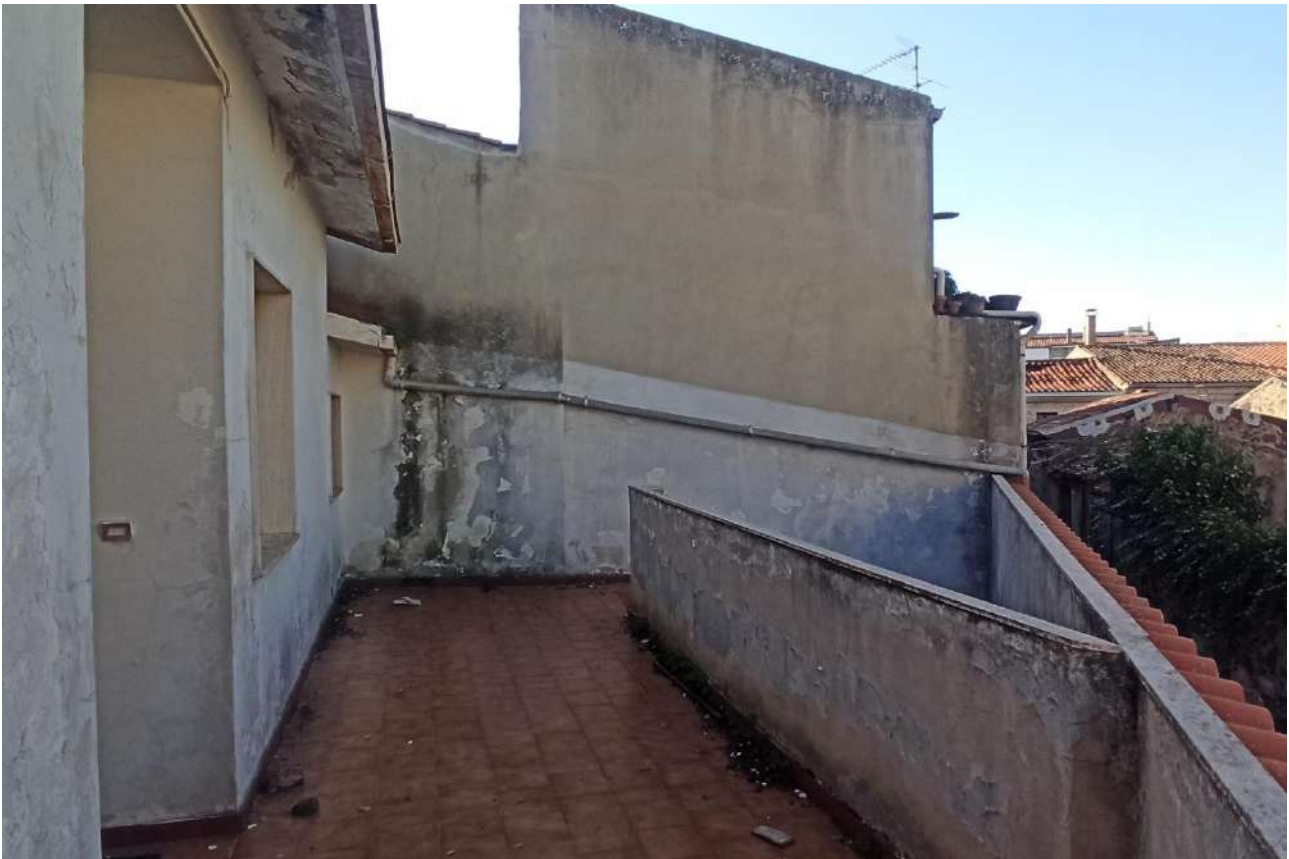
Foto n.05 – terrazzo accesso piano primo
