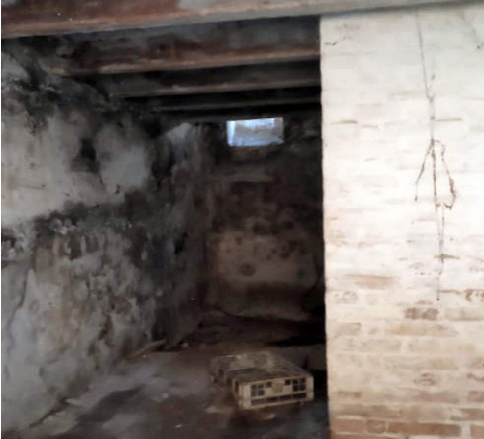
Cantina al piano interrato
