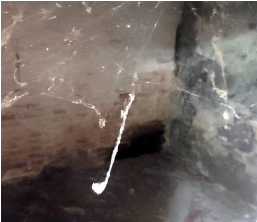
Cantina al piano interrato
