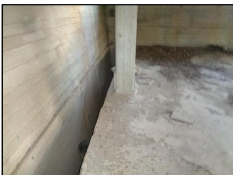
Cavedio di separazione in piano terra
