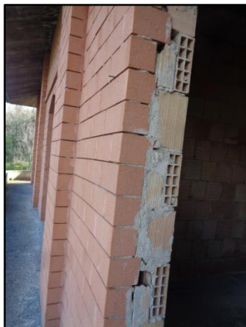
Particolare muratura di tompagno
