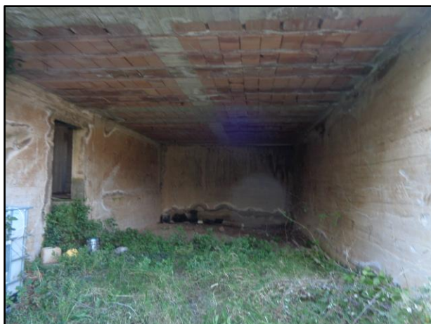
Locale al piano S1 sul fronte nord del fabbricato
