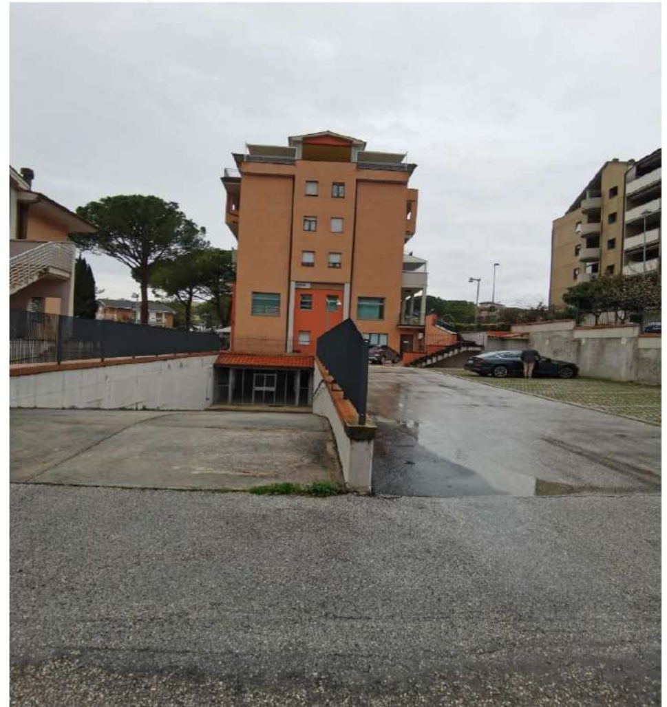
FOTO N° 5bis – Prospetto Sud-Est
