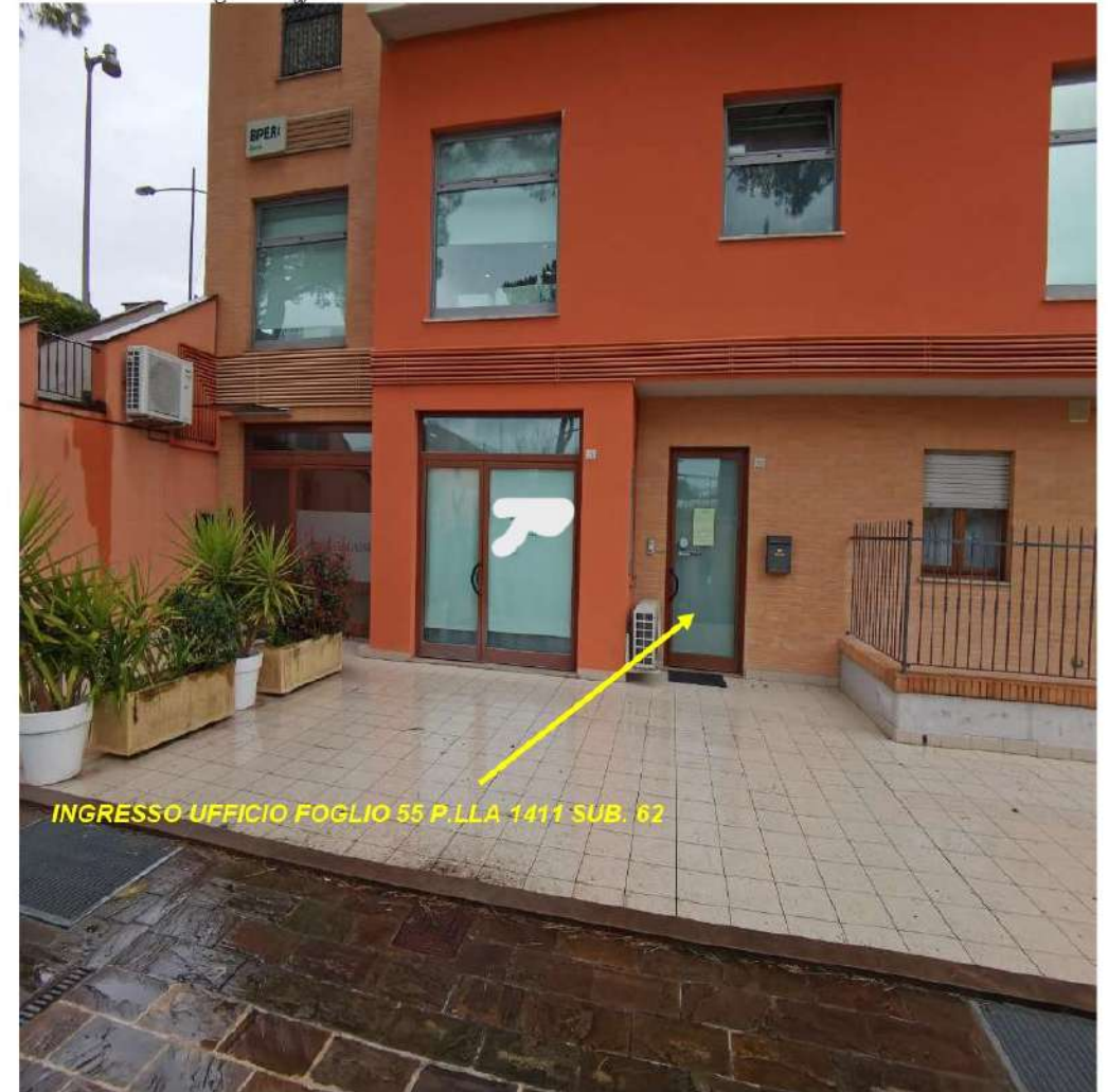
FOTO N° 6 bis – ingresso ufficio sub. 62
