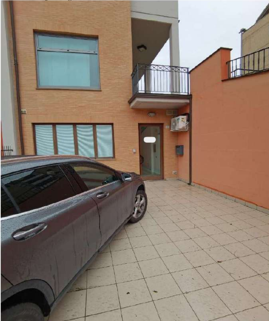
FOTO N° 6 – ingresso ufficio sub. 26
