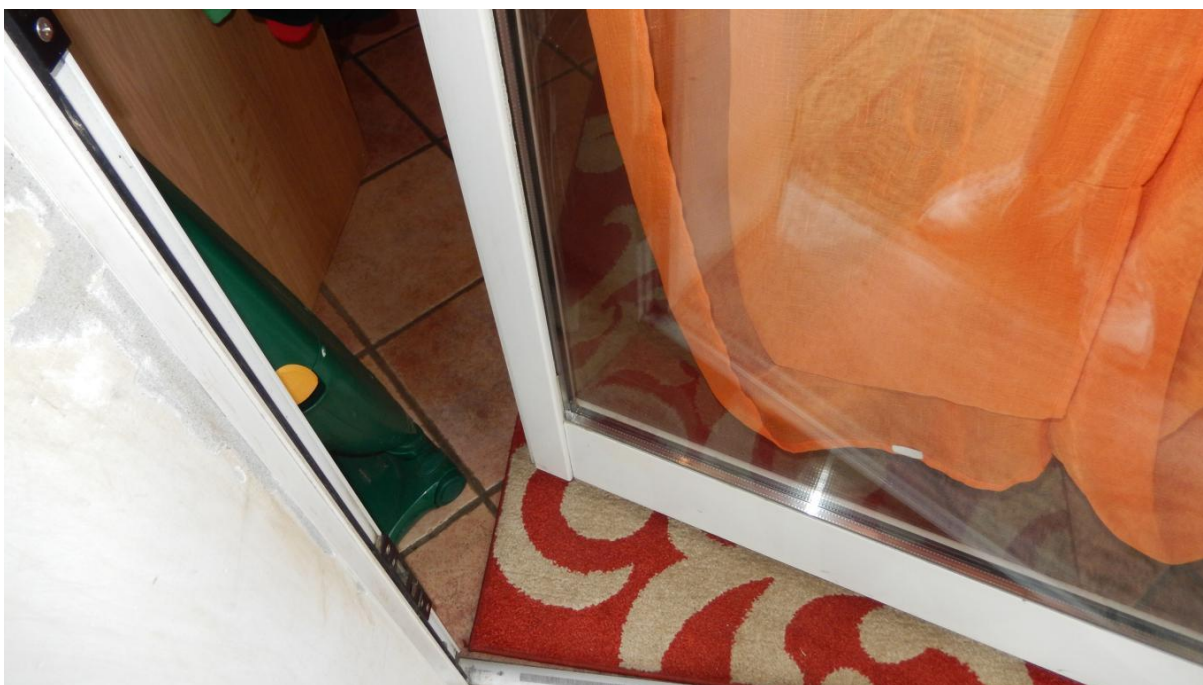
PARTICOLARE INFISSI RECENTI (MODERNI)
