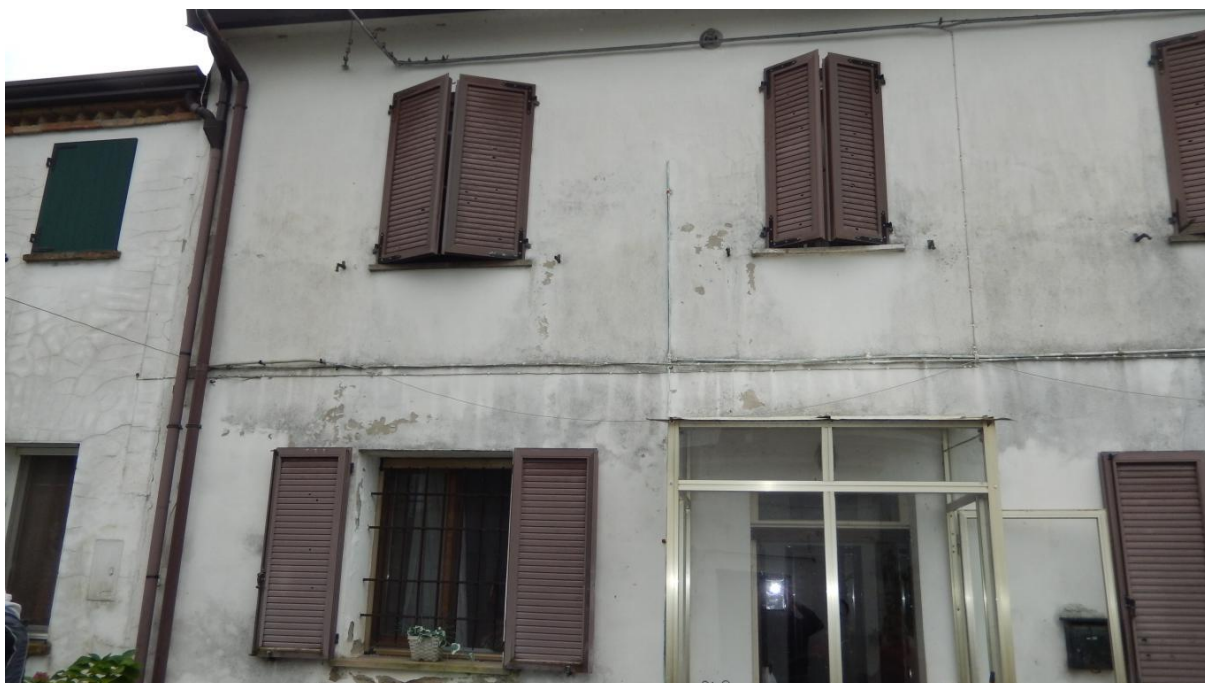
PROSPETTO PRINCIPALE (EST) PROSPICIENTE SU CORTE COMUNE
