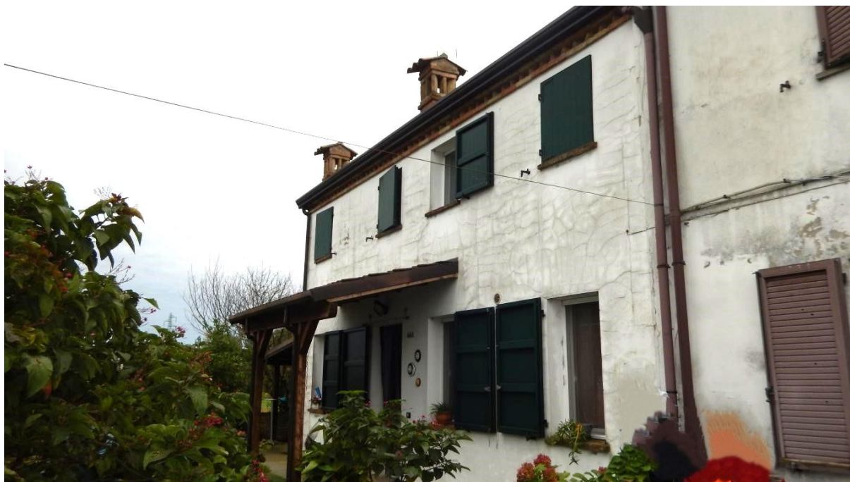
PROSPETTO PRINCIPALE EST IN ADIACENZA A SUB 5
