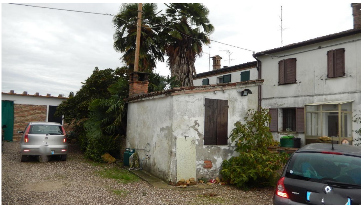
EX LAVANDERIA VISTA NORD / EST, SU CORTE COMUNE
