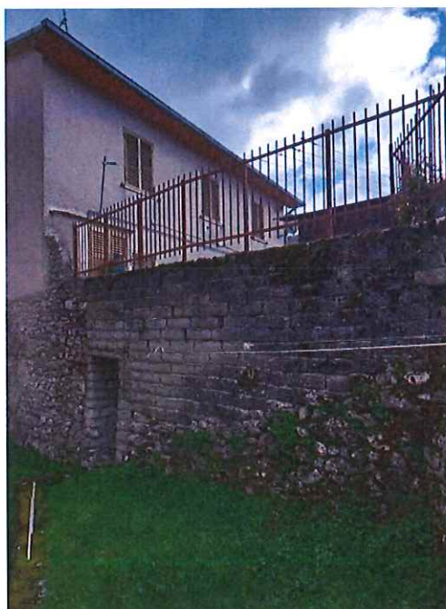
Foto 6 – locale di sgombero esterno
