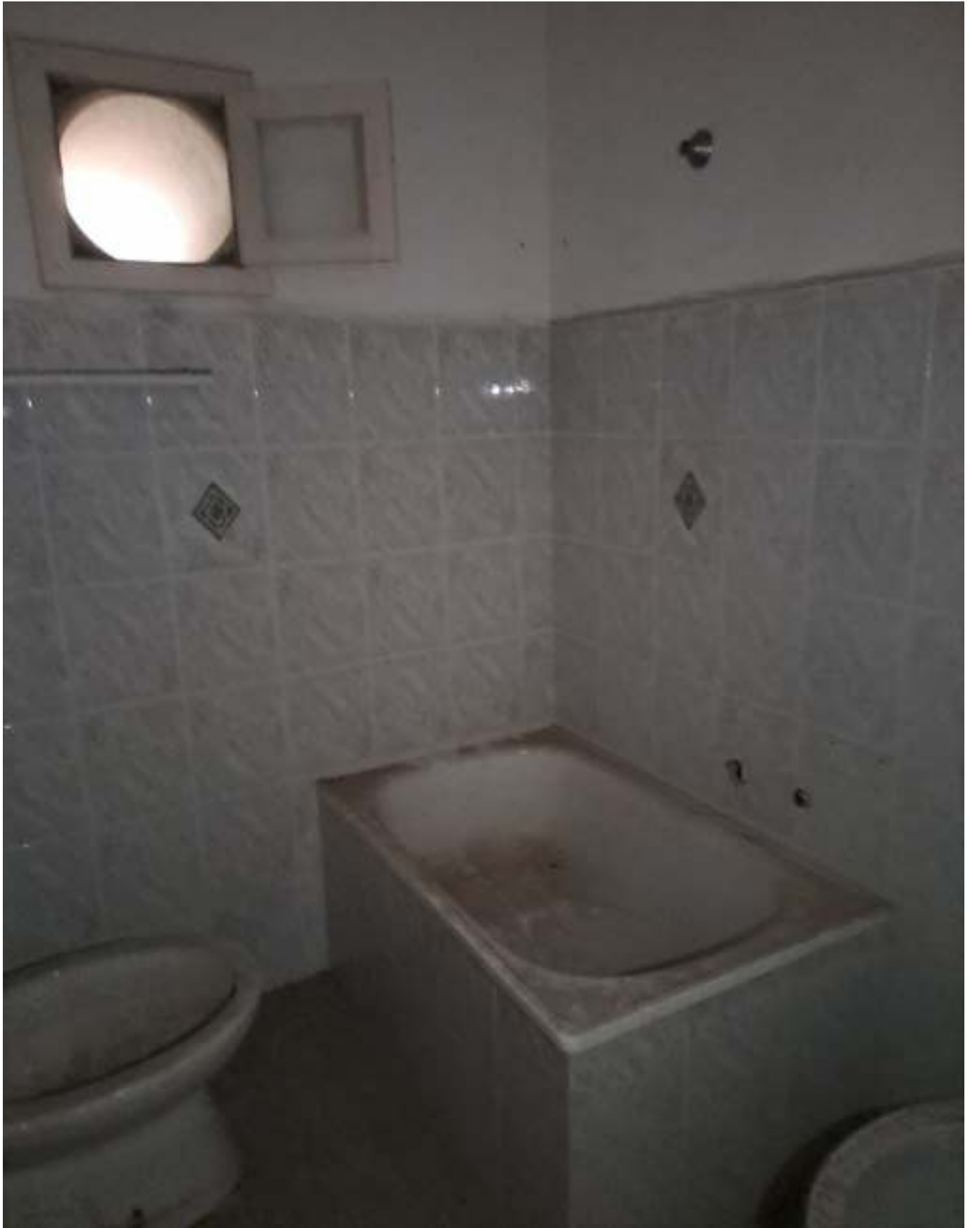
FOTO N. 10 VISTA DEL LOCALE BAGNO
