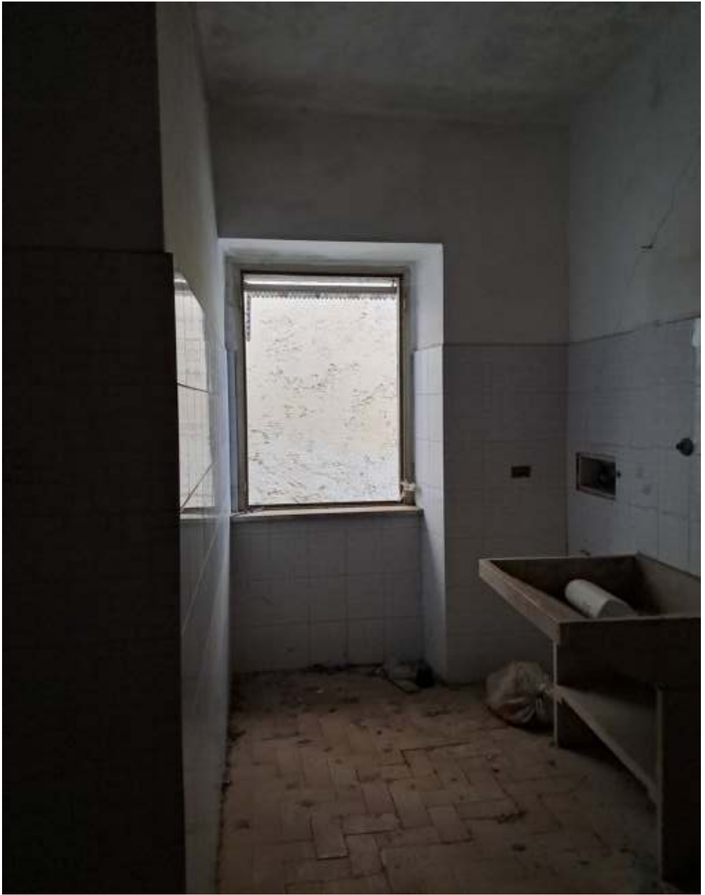
FOTO N. 8 VISTA DEL LOCALE CUCINA
