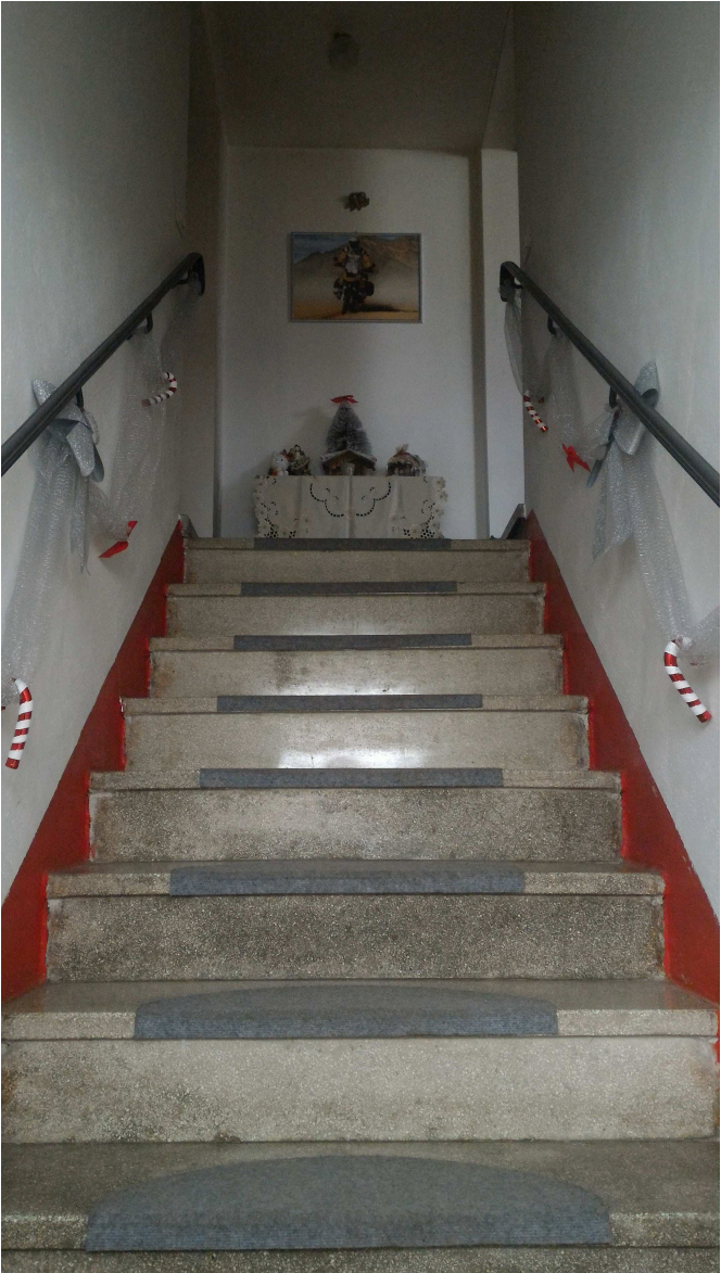
Foto n. 20: vista della scala principale di collegamento tra piano terra e primo
