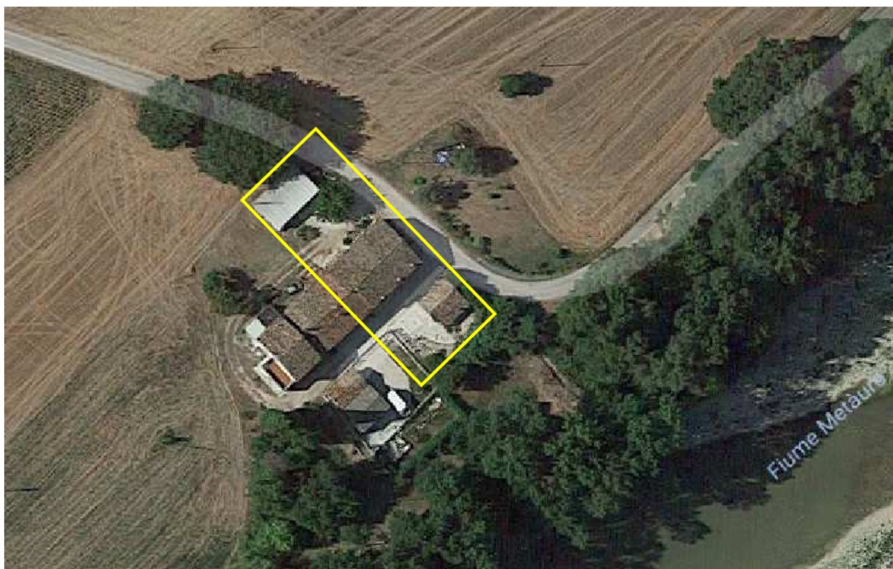
Foto n. 12: vista aerea della porzione di fabbricato che ospita l'immobile e i locali accessori oggetto di perizia
