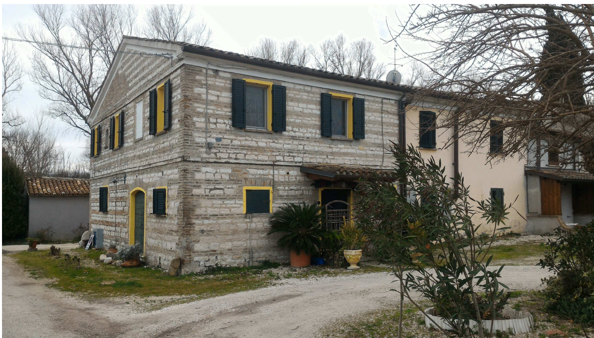
Foto n. 14: vista della porzione di fabbricato dall'antistante Via La Barca (prospetti nord ed ovest)
