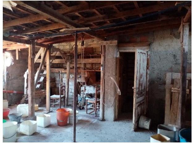
Foto N° 14 Lastrico solare con copertura precaria
