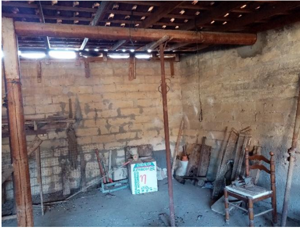
Foto N° 13 lastrico solare e copertura precaria
