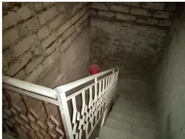
Foto n° 16 Vano scale – pianerottolo Lastrico solare
