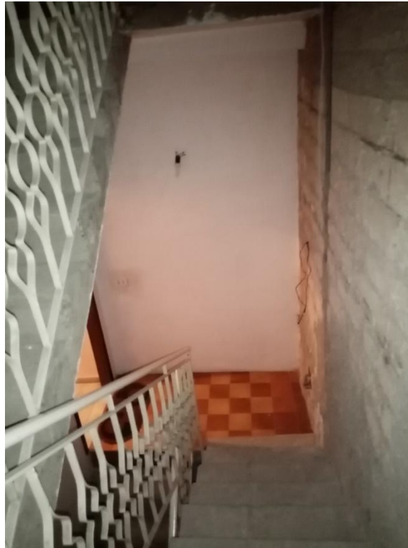
Foto n° 15 Vano scale – pianerottolo ingresso 3 piano
