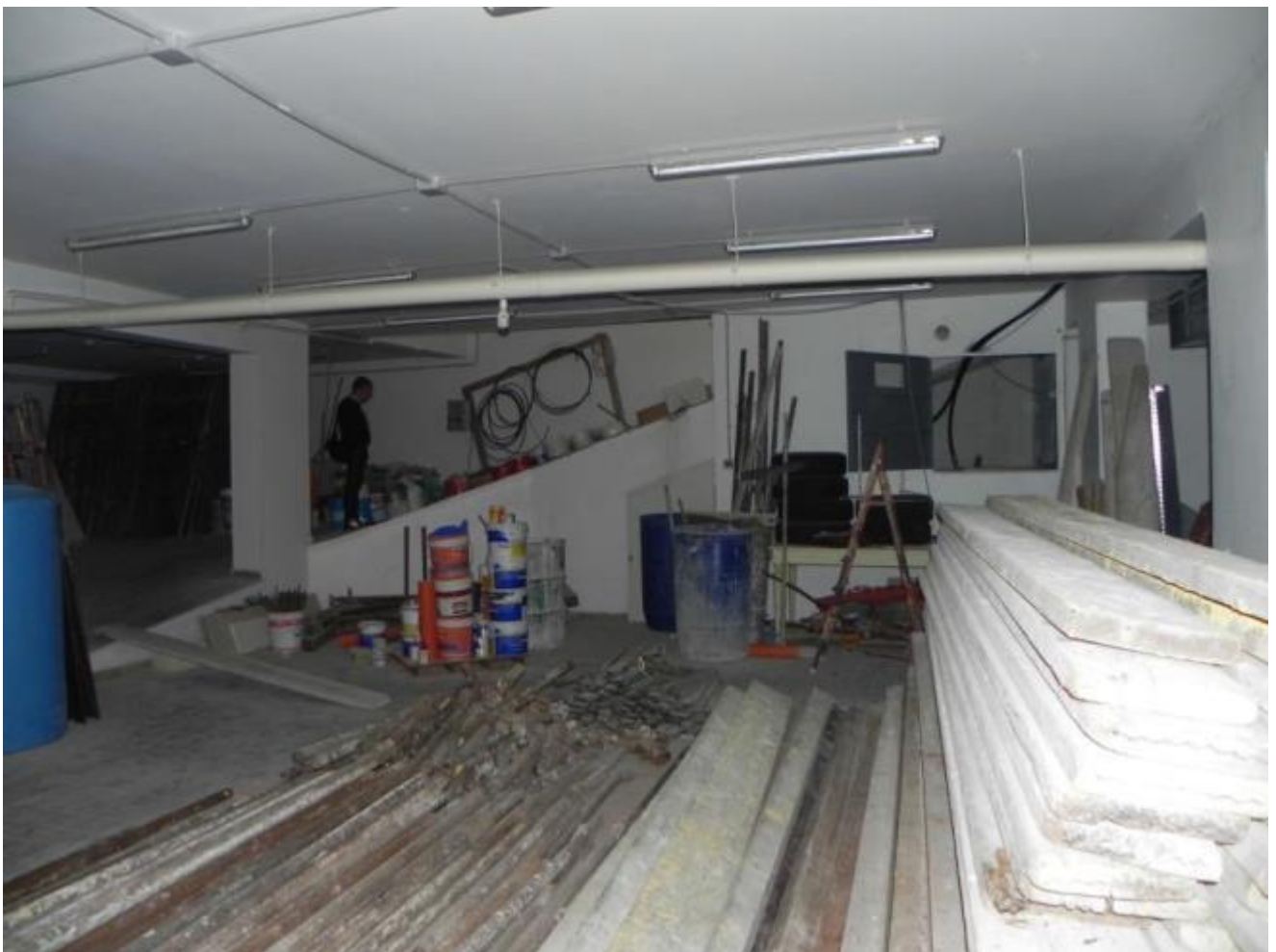
Piano seminterrato - vista dall'interno del seminterrato
