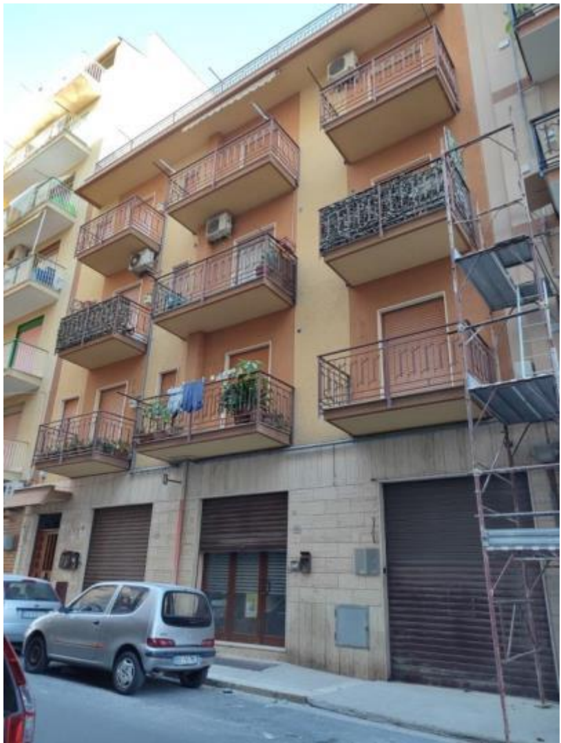
Vista dell'edificio dalla Via Derelitto
