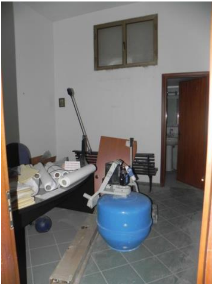
Piano terra - vano a ovest e in fondo ingresso al wc
