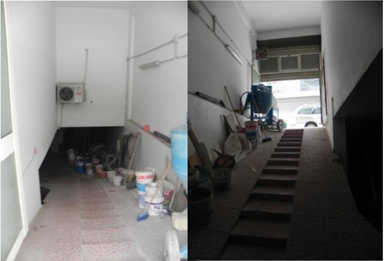
Piano seminterrato - rampa di accesso al piano seminterrato
