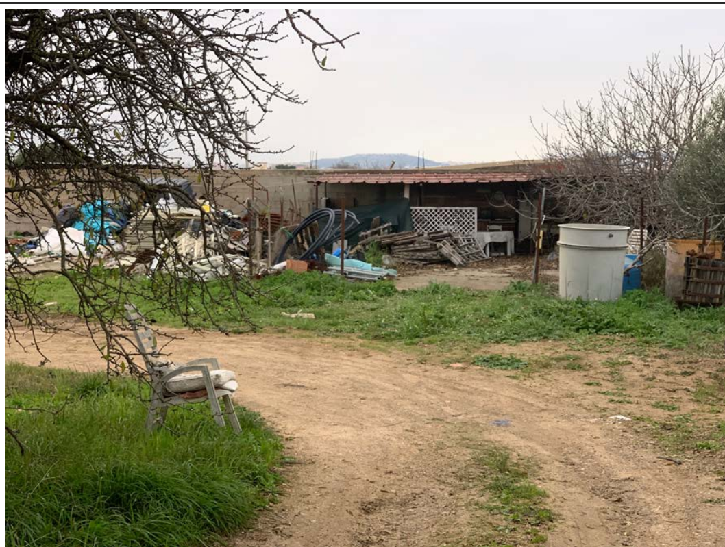
Figura 17 veduta dell'immobile in prossimità del confine col lotto rif. 3, nel dettaglio tettoie per ricovero attrezzi e accumulo materiali.
