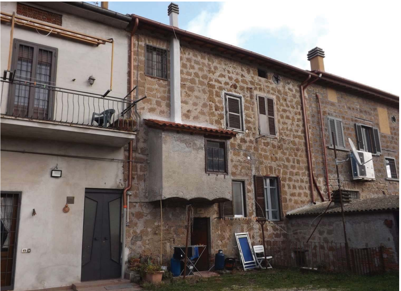
Foto 5 – Prospetto secondario del fabbricato sulla corte comune posta sul retro dell'edificio
