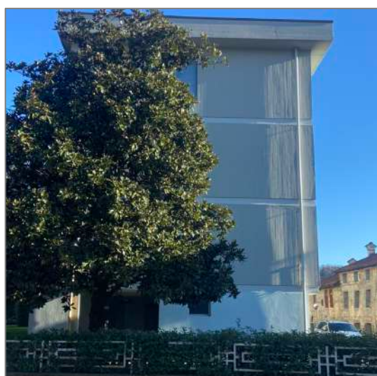
Foto 4. La palazzina fronte Nord
