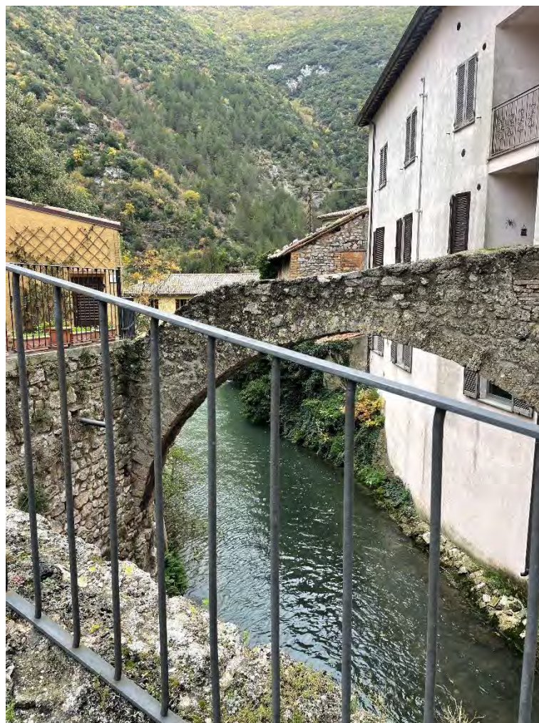
Foto n. 6 – Vista del fiume Potenza che costeggia il lato posteriore del fabbricato
