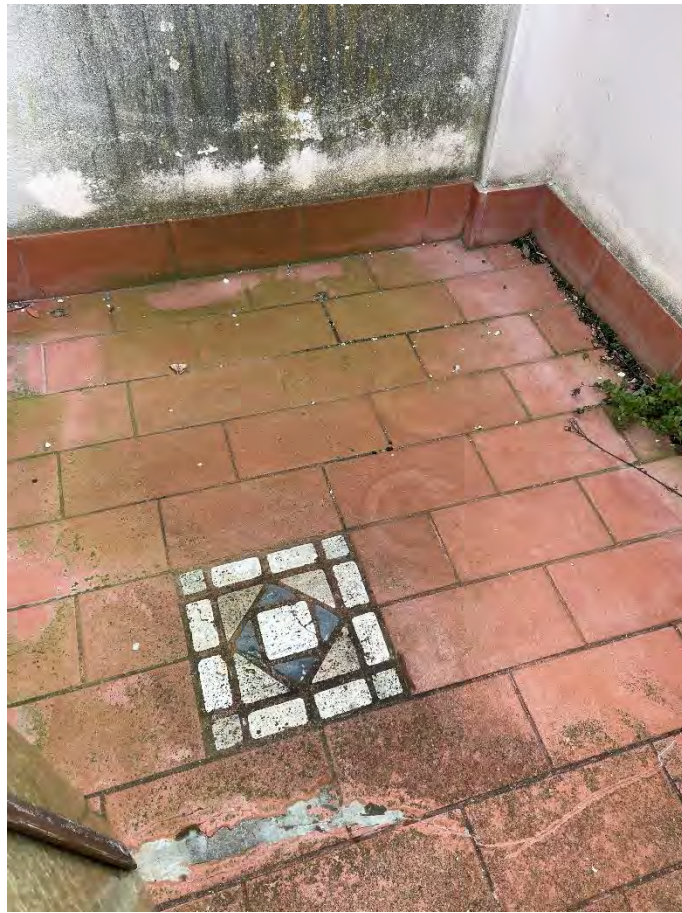
Foto n. 39 – Particolare pavimentazione lastrici solari
