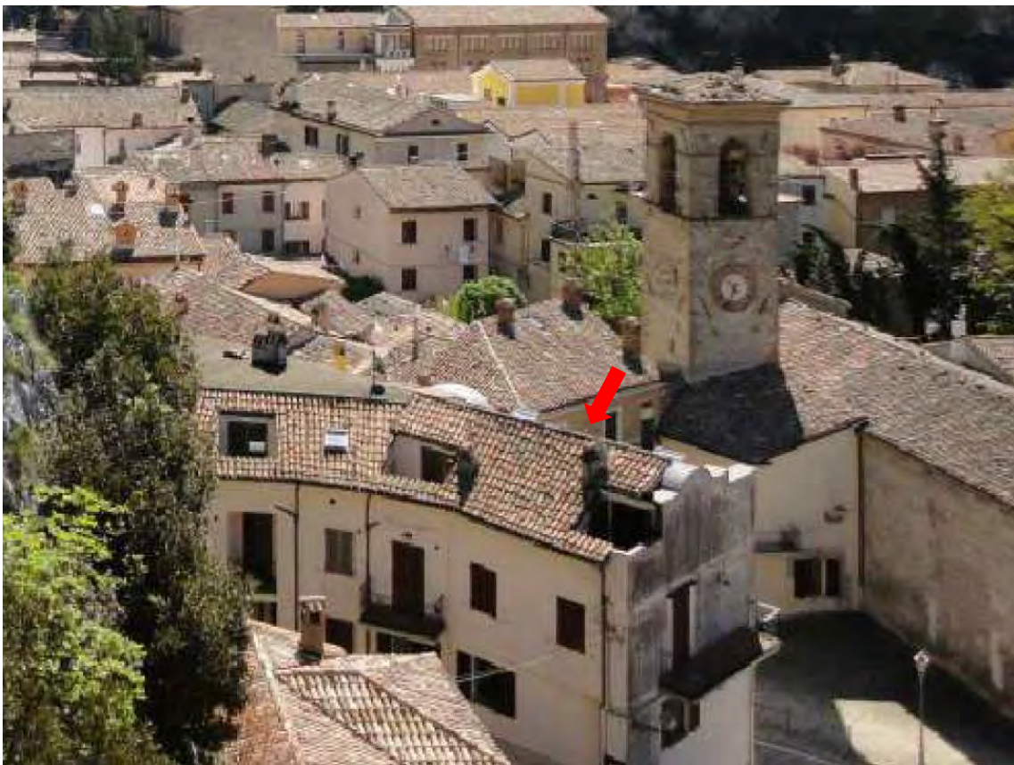
Foto n. 2 – Vista dal sentiero Li Vurgacci
