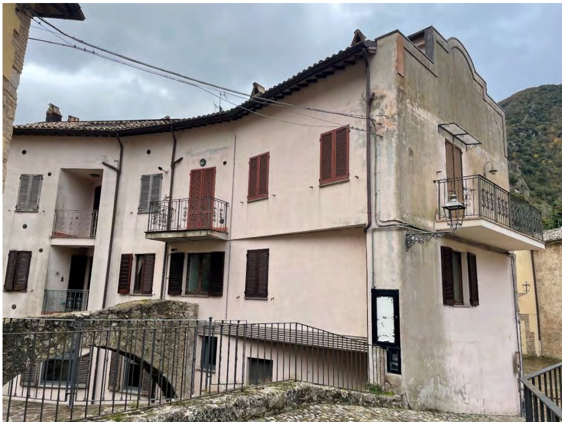
Foto n. 5 – Vista posteriore del fabbricato condominiale dal ponte Marmone
