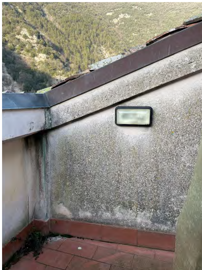
Foto n. 38 – Vista lastrico solare
