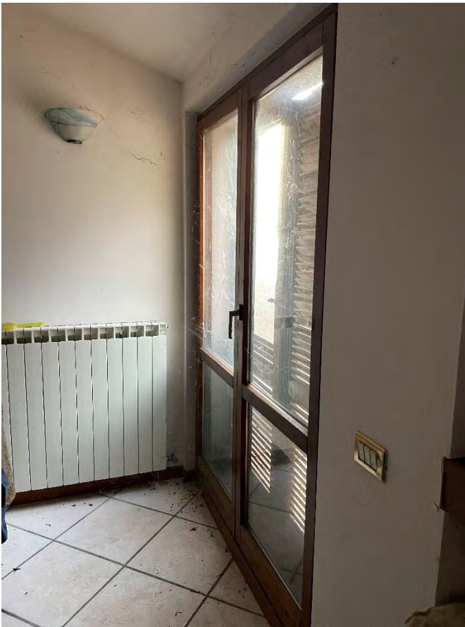
Foto n. 33 – Infisso, pavimentazione e radiatori
