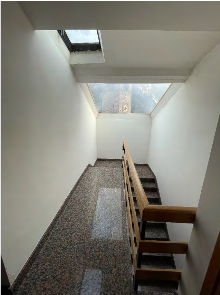
Foto n. 11 – Pianerottolo P. 3 con velux
