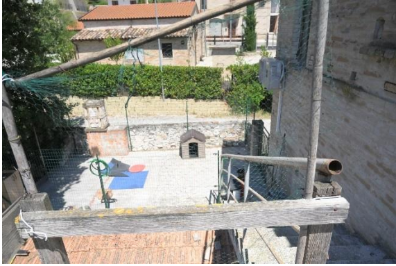
Foto – 16 scala esterna 1° piano
