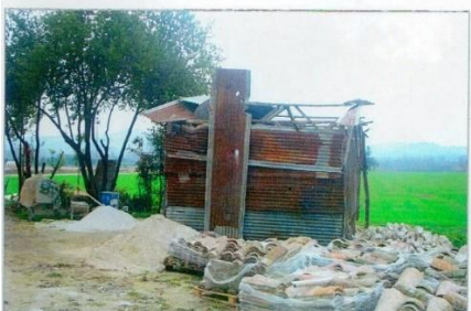
Foto – 20 locale deposito IMMAGINE DEL 2007
