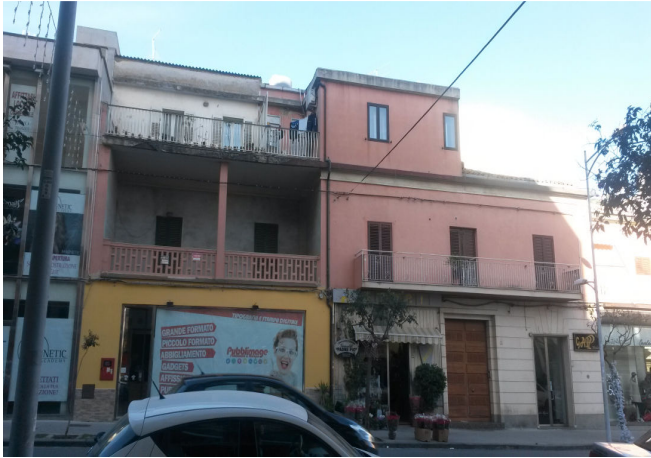
1. Prospetto del fabbricato su Viale P. Umberto
