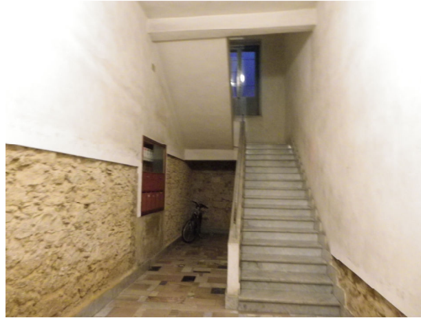
2. Vista vano scala al piano terra
