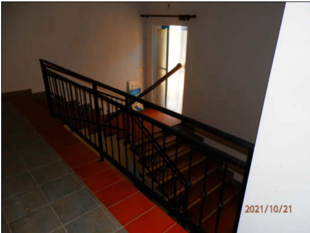
Fotografia N. 16 - Vano scala, Piano Primo
