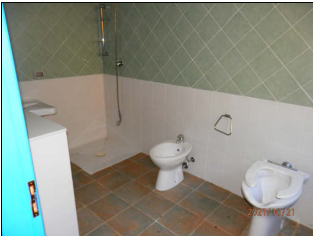
Fotografia N. 14 - W.C. da 6,10mq, Piano Terra
