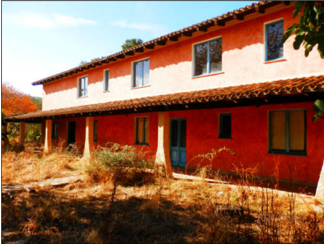
Fotografia N. 1 - prospetto Est lato ingresso principale
