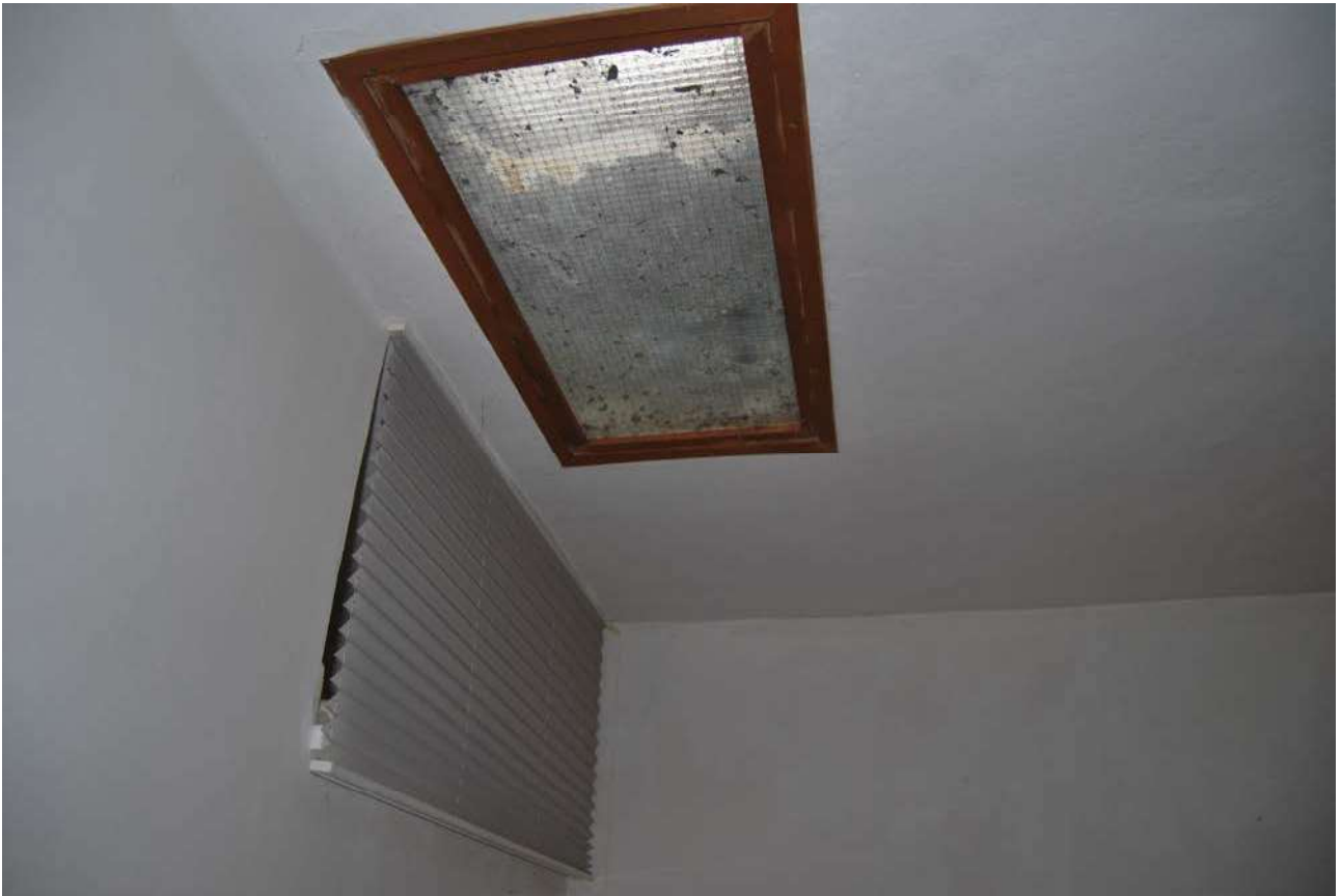
Particolare del lucernario nella sala a piano secondo
