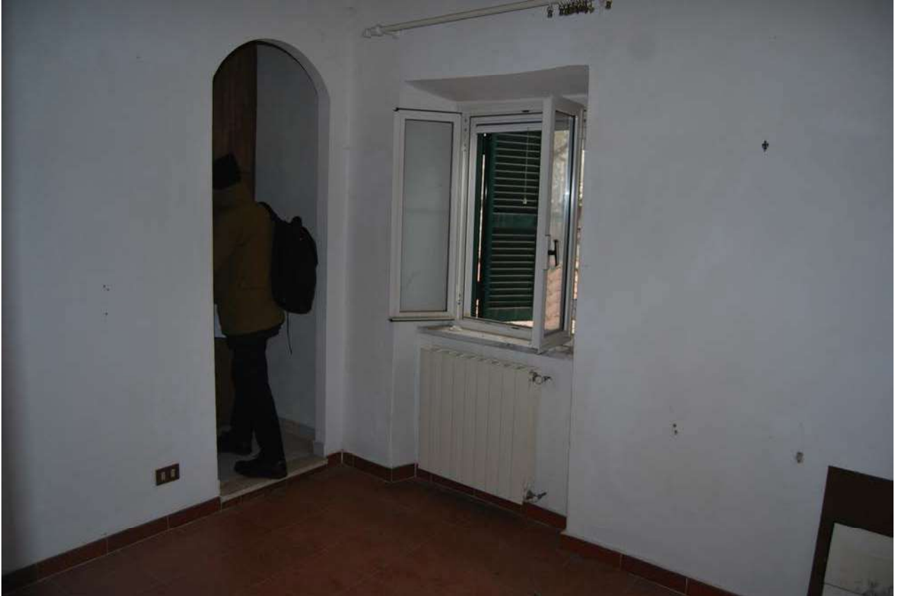
Particolare della sala a piano secondo e l'accesso al disimpegno del bagno
