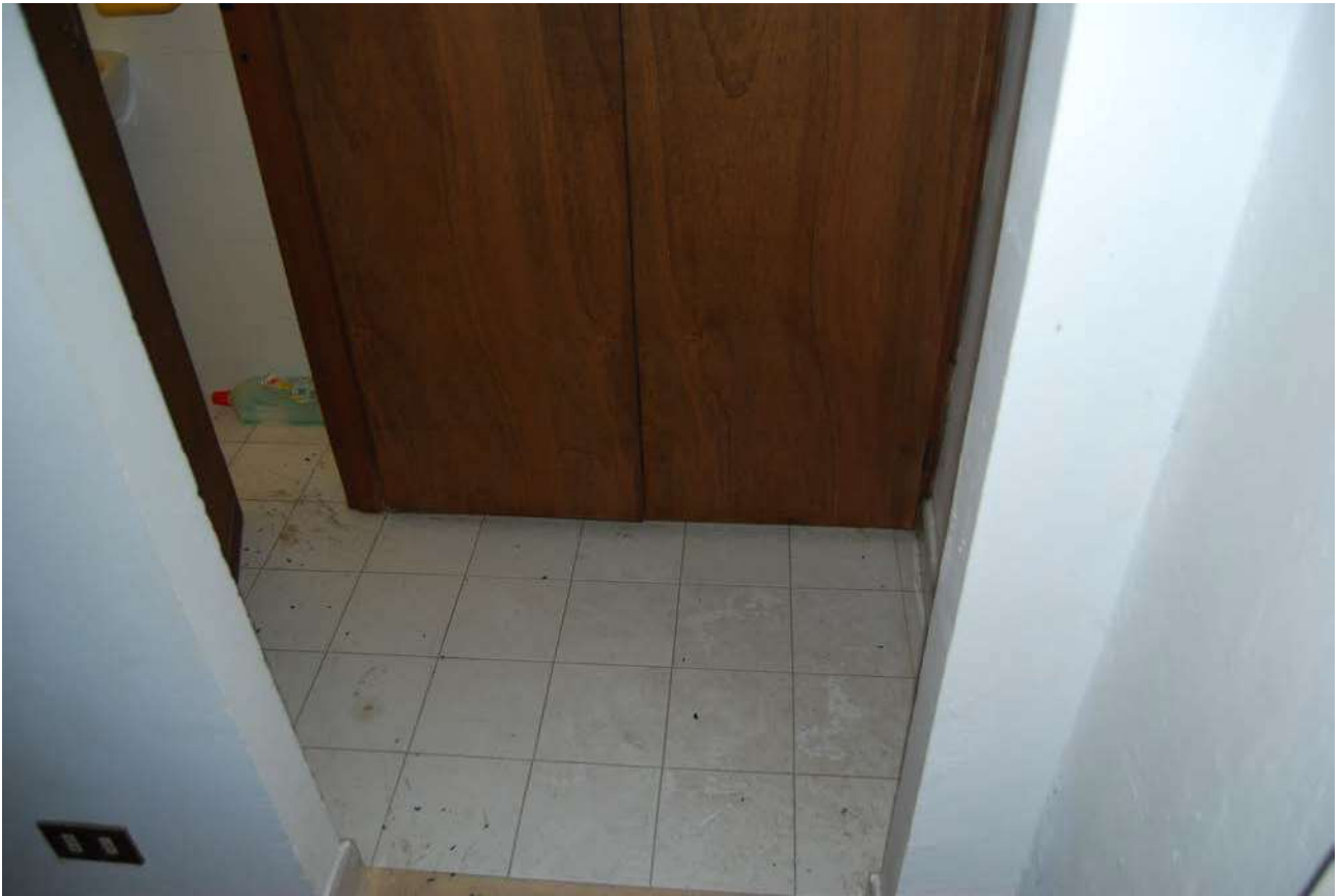
Particolare del disimpegno del bagno a piano secondo
