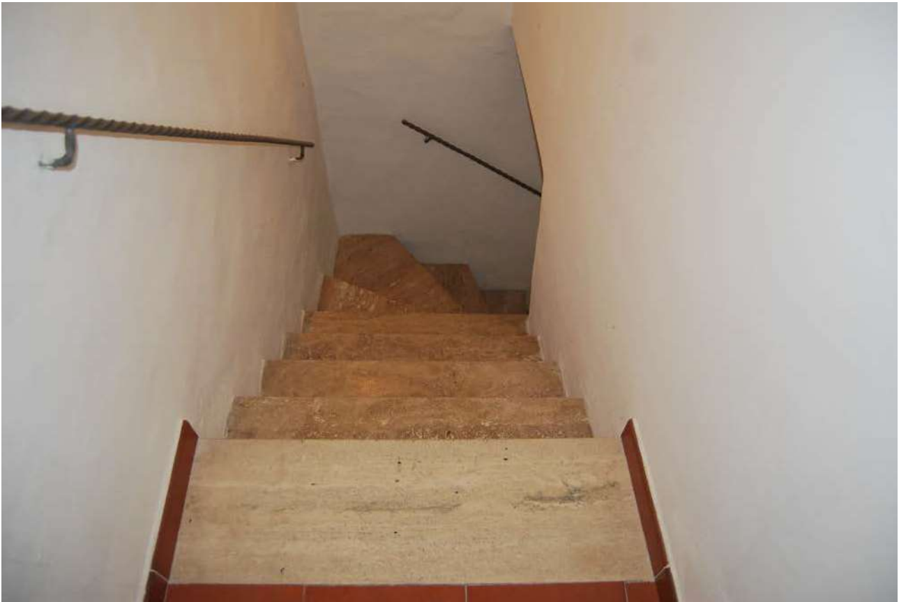
Particolare della scala di collegamento da piano primo al piano secondo
