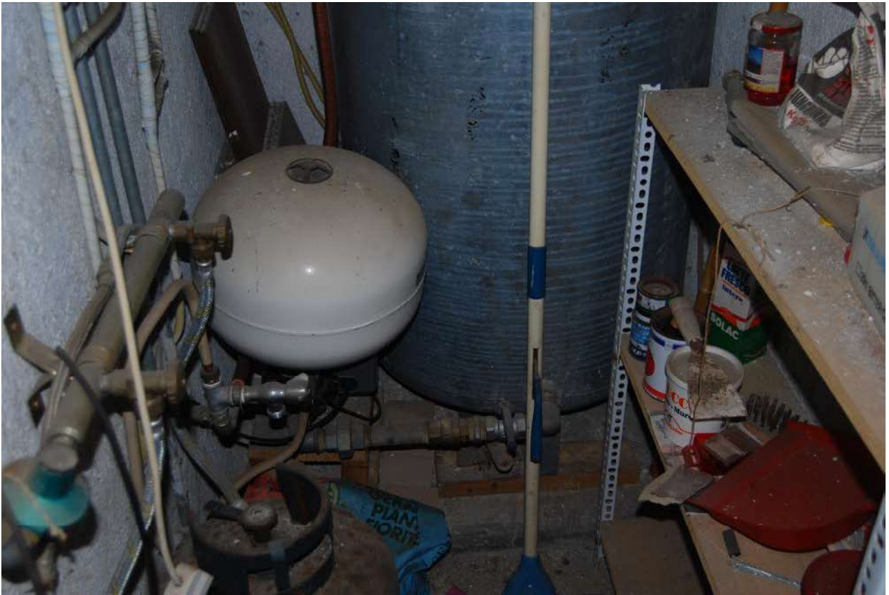
Particolare del ripostiglio, usato come locale tecnico
