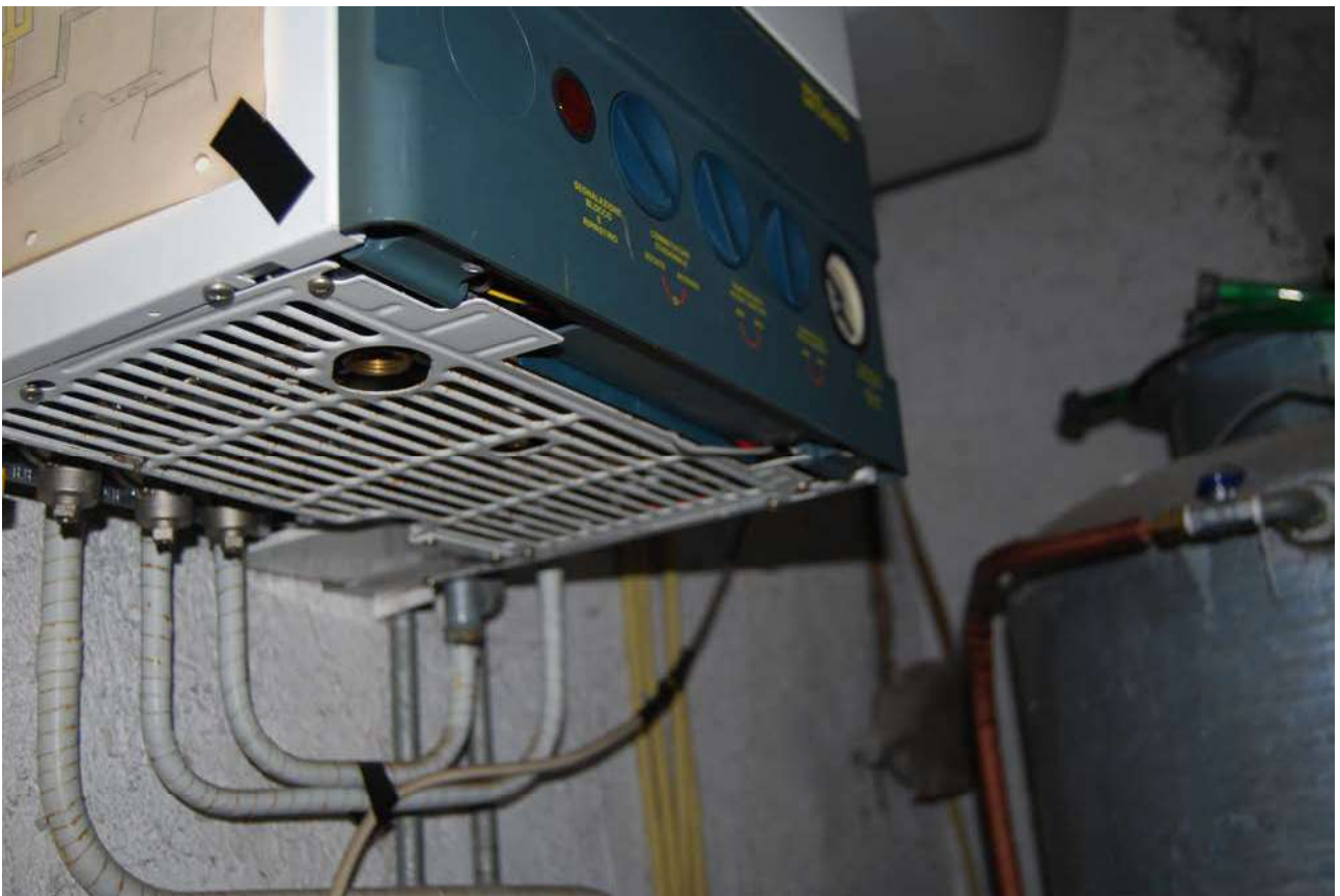
Particolare del ripostiglio, usato come locale tecnico
