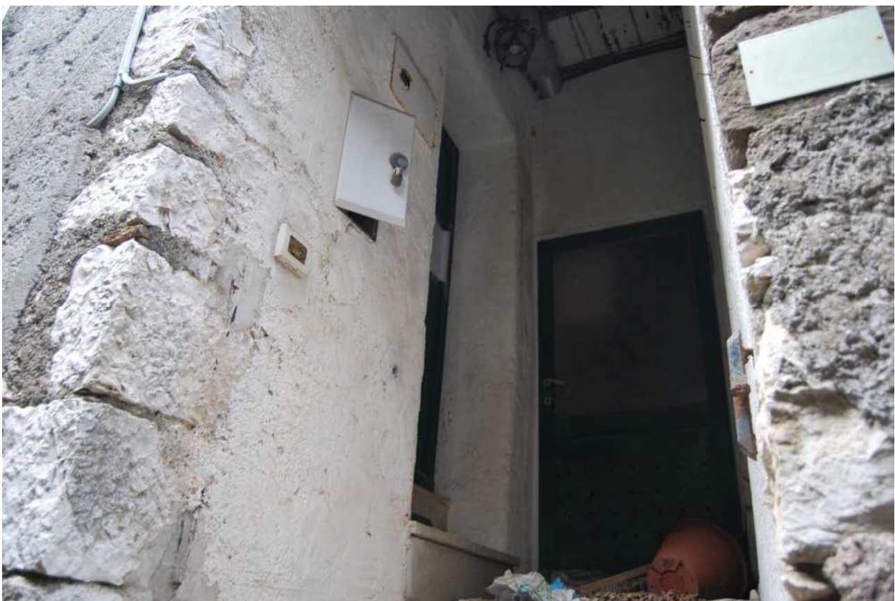
Particolare dell'ingresso all'appartamento (a sinistra) ed al ripostiglio (frontalmente)
