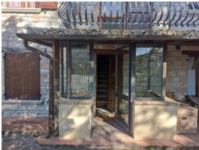
La veranda a protezione dell'ingresso principale (da rimuovere)
