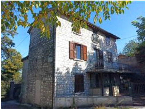
La casa vista da via dei Tiratori
