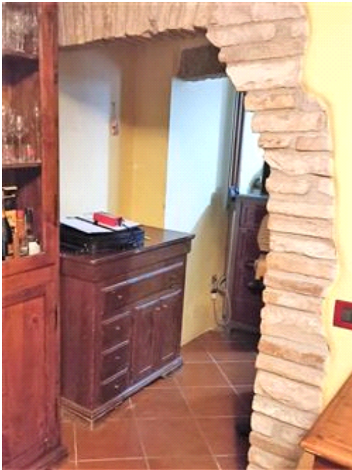
Piano terra: il passaggio in luogo del wc di progetto
