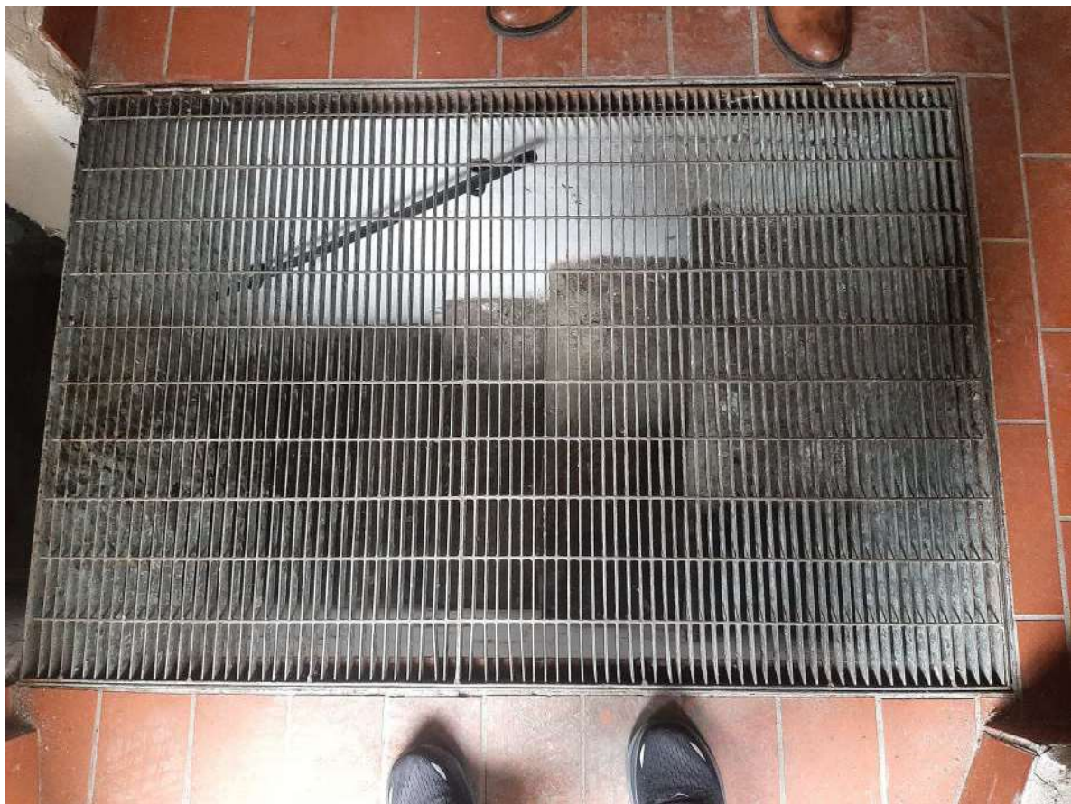
SCALA ACCESSO CANTINA
