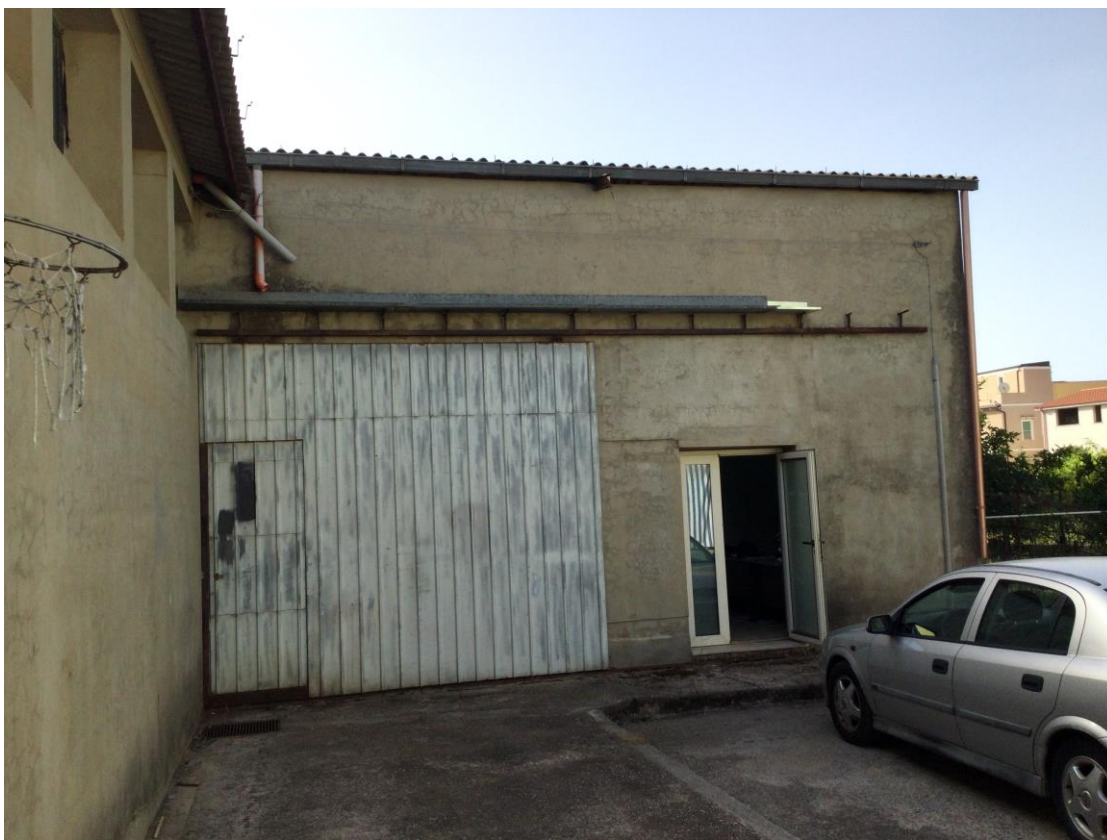
Vista del prospetto posteriore
