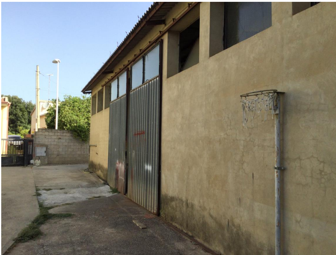
Vista del prospetto posteriore
