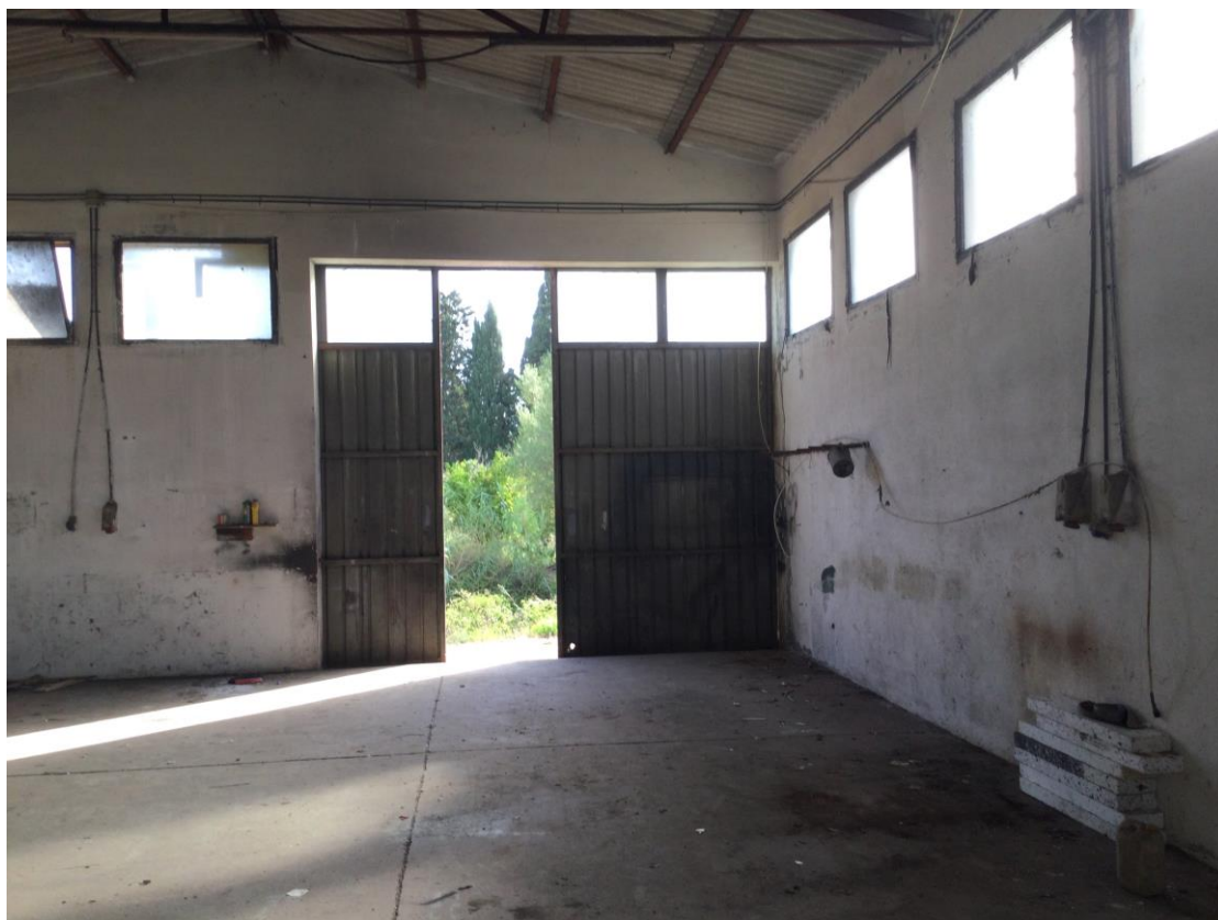
Vista dell'interno verso l'ingresso
