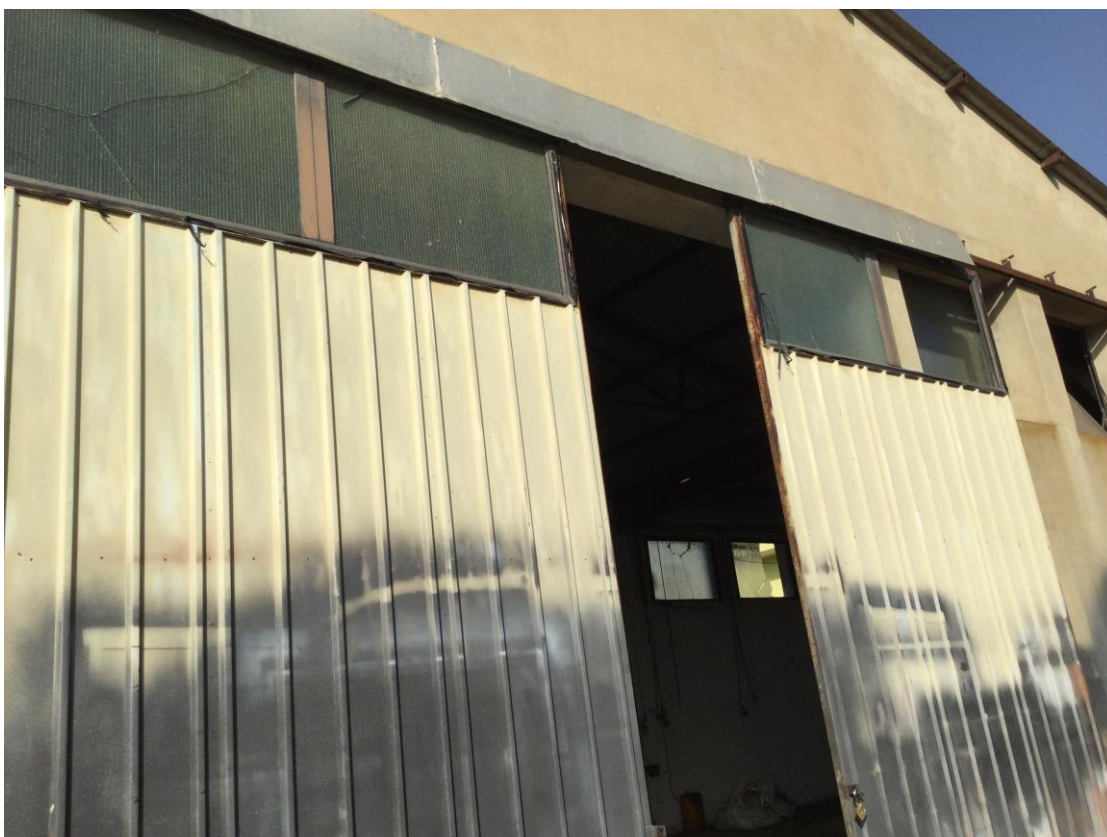
Vista dell'ingresso pedonale e carrabile
