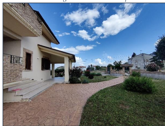
Figura 4 Particolare ingresso pedonale
