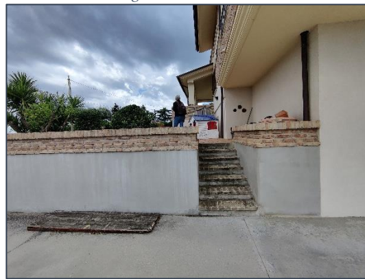
Figura 8 Particolare prospetto posteriore
